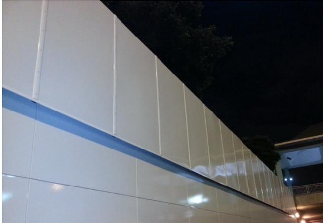
**Imagen 9. Parte superior de los paramentos de los accesos con paneles vitrificados de 2 mm y perfiles cubrejuntas.**
