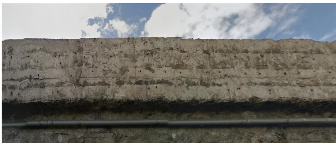
**Imagen 34. Parte superior del paramento en el acceso del paso inferior de Torre Las Palmas en el que se aplicará revestimiento mediante enfoscado**
