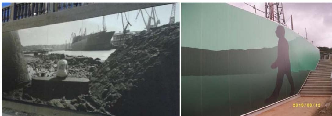
**Imagen 17. Acabado serigrafiado en paneles tipo sándwich.**
