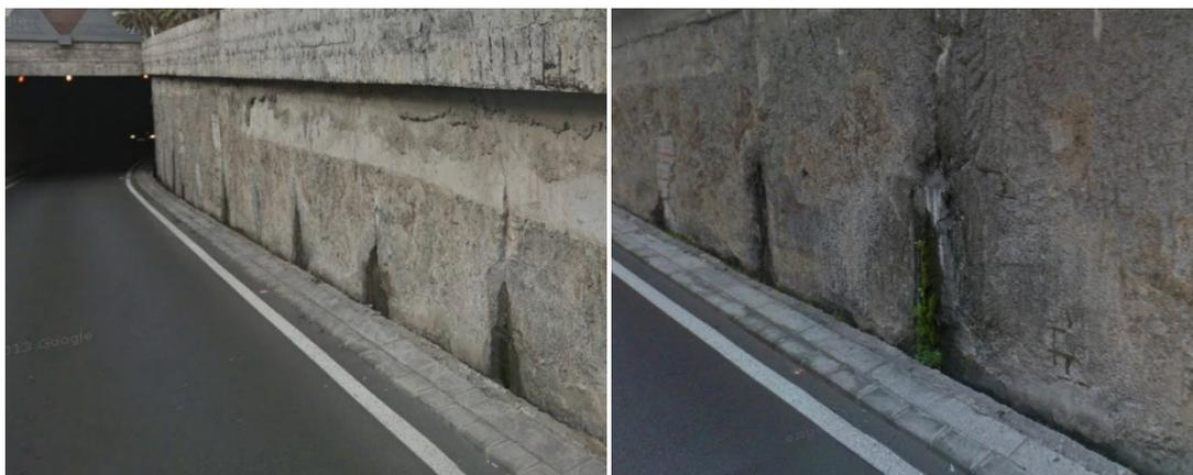
Imagen 4. Escalón existente en el paramento y filtraciones de agua en el Paso Inferior de la C/ Pérez Muñoz
