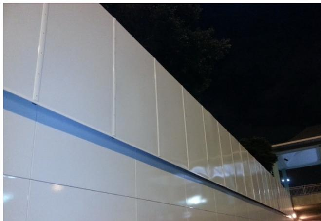
**Imagen 10. Parte superior de los paramentos de los accesos con paneles vitrificados de 2 mm y perfiles cubrejuntas.**
