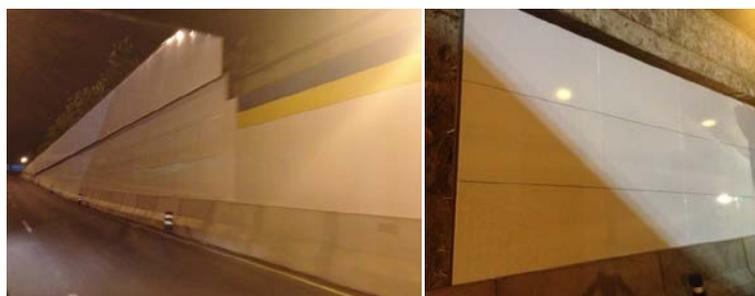
Imagen 9. Paneles vitrificados de cuatro bordes en el interior y en la parte inferior de los accesos
