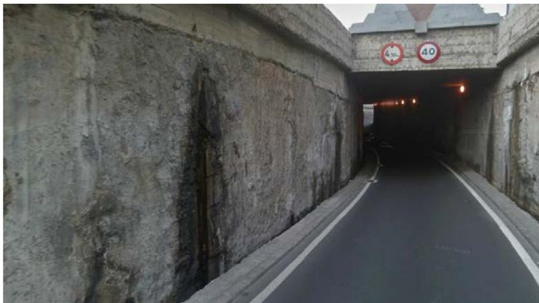
**Imagen 4. Evidencias de filtración de agua en los paramentos de los accesos en el Paso Inferior de la C/ Pérez Muñoz**
