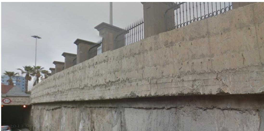
**Imagen 27. Parte superior del paramento en el acceso del paso inferior de la calle Pérez Muñoz en el que se aplicará revestimiento mediante enfoscado**
