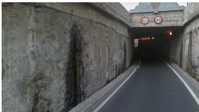
**Imagen 3. Evidencias de filtración de agua en los paramentos de los accesos en el Paso Inferior de la C/ Pérez Muñoz**
