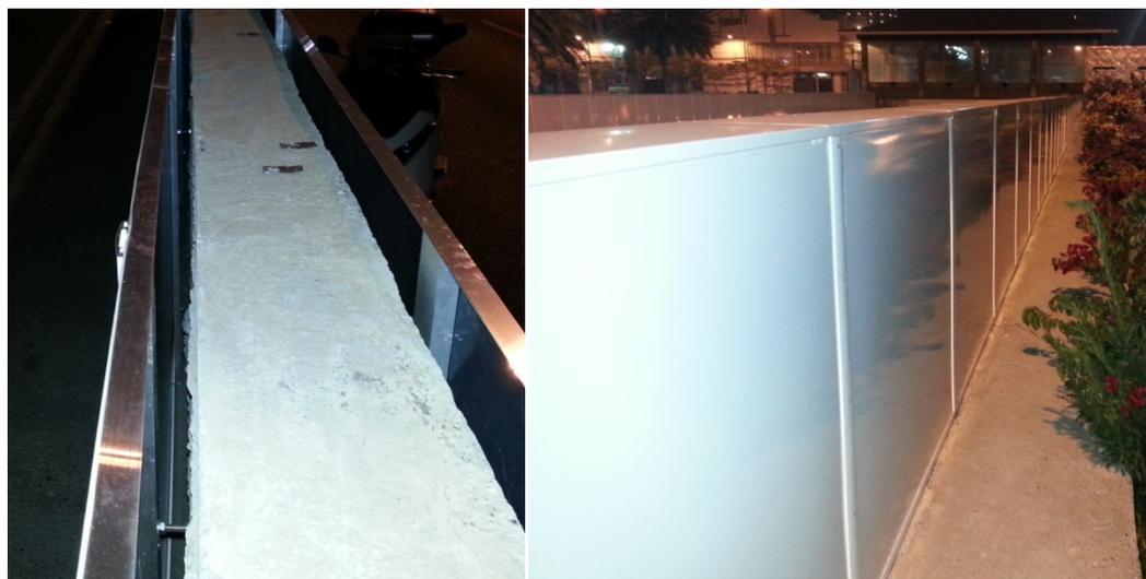
**Imagen 11. Murete de coronación a falta del remate superior y acabado final**
