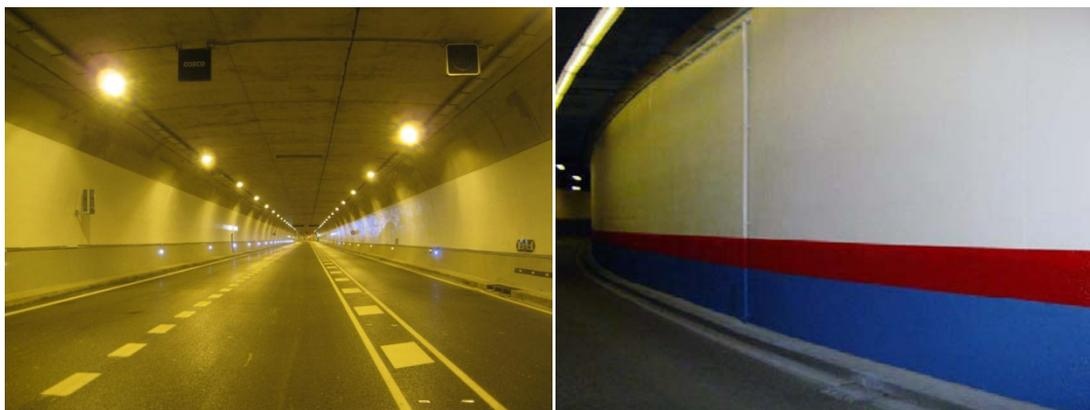
**Imagen 12. Ejemplos de revestimientos a base de pinturas**
