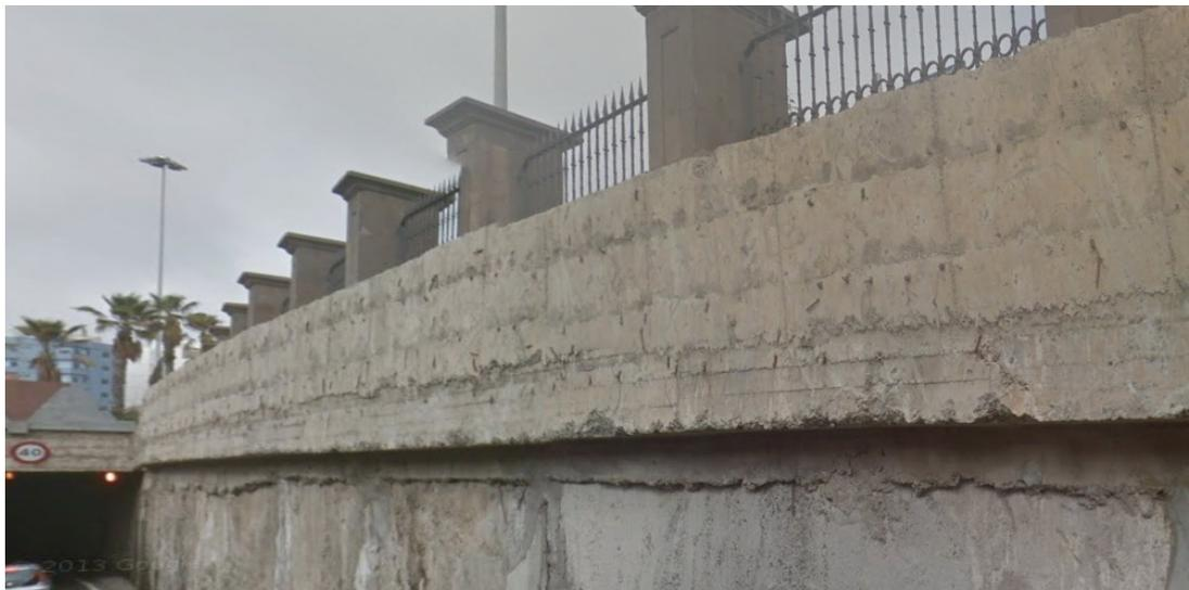
**Imagen 35. Parte superior del paramento en el acceso del paso inferior de la calle Pérez Muñoz en el que se aplicará revestimiento mediante enfoscado**
