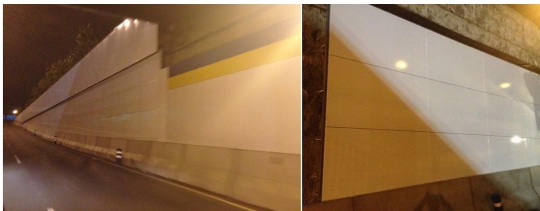
Imagen 8. Paneles vitrificados de cuatro bordes en el interior y en la parte inferior de los accesos
