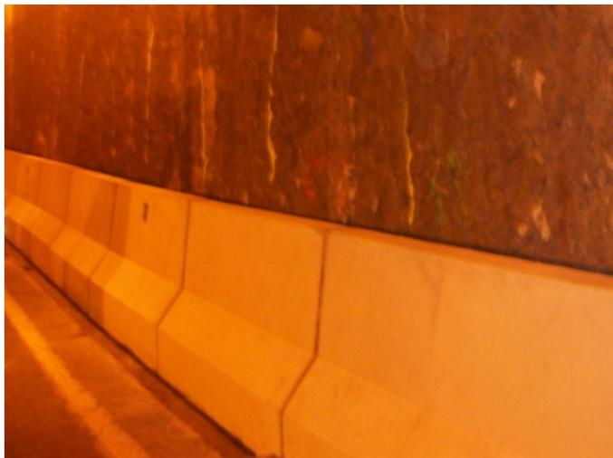
**Imagen 5. Barrera de hormigón colocada**
