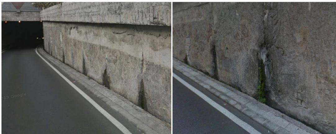
**Imagen 5. Escalón existente en el paramento y filtraciones de agua en el Paso Inferior de la C/ Pérez Muñoz**
