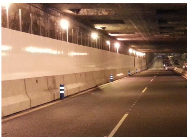
Imagen 6. Balizas colocadas en paso inferior en la Avenida Marítima
