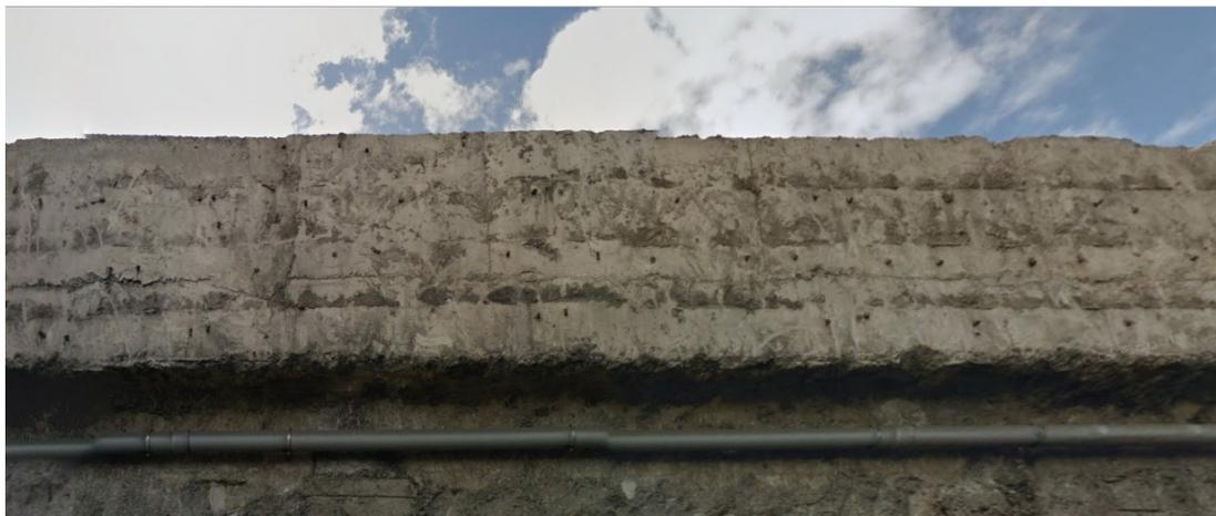
**Imagen 26. Parte superior del paramento en el acceso del paso inferior de Torre Las Palmas en el que se aplicará revestimiento mediante enfoscado**
