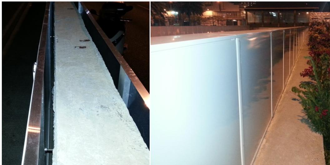
**Imagen 10. Murete de coronación a falta del remate superior y acabado final**
