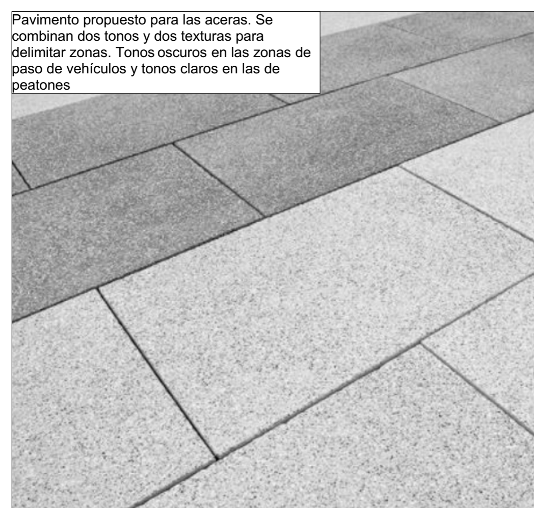
Pavimento propuesto para las aceras. Se combinan dos tonos y dos texturas para delimitar zonas. Tonos oscuros en las zonas de paso de vehículos y tonos claros en las de peatones
