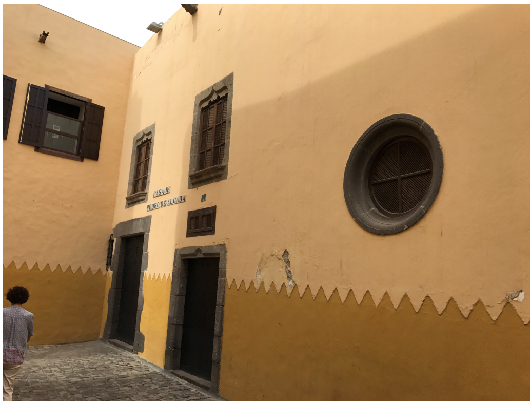
07. Enfoscados defectuosos en Pasaje de Pedro de Algaba
