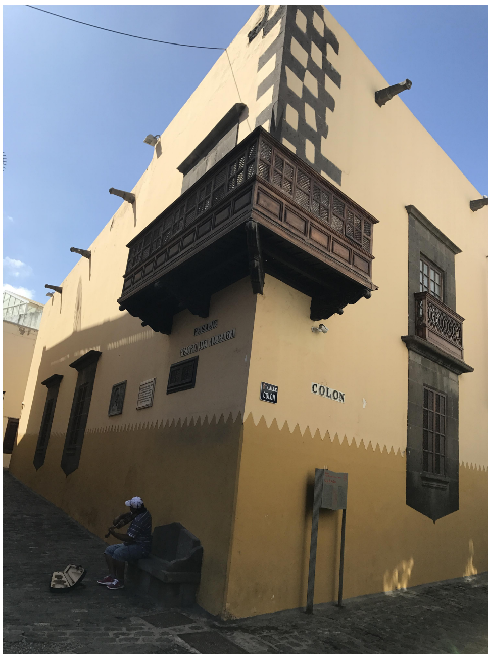
08. Balcón a restaurar en esquina de calle Colón y Pasaje de Pedro de Algaba
