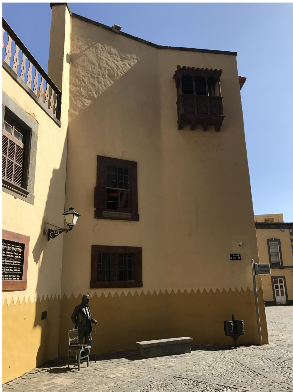
03. Fachada y Balcón sobre el que se actúa en todos sus elementos en calle Herrería esquina con Plaza del Pilar Nuevo
