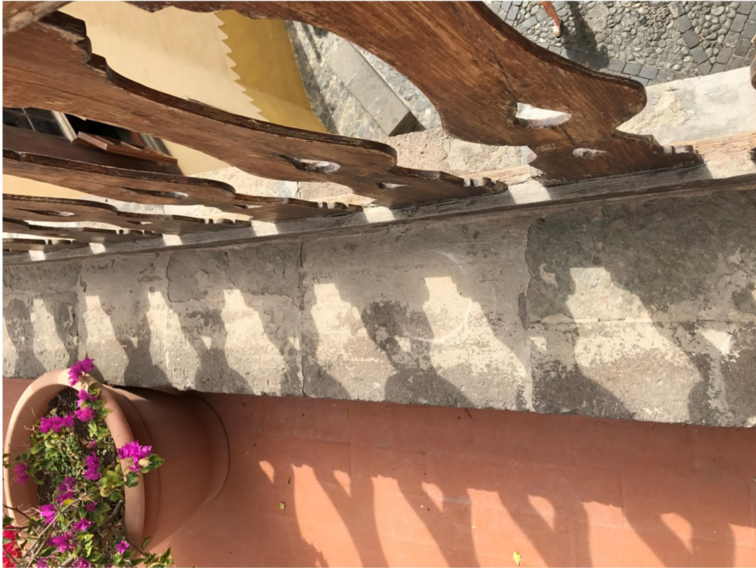
06. Barandilla de madera y Mampostería de piedra de Pretil a restaurar en calle Herrería.
