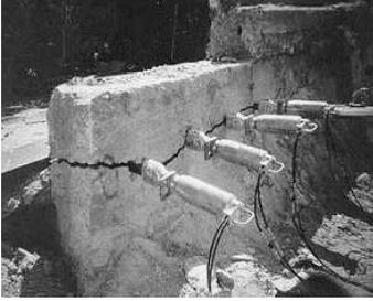
*Demolición de pantalla con perforadores eléctricos*
