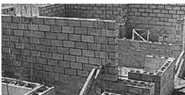
Muro de carga de bloques de hormigón (<http://www.corblock.com.ar>)
