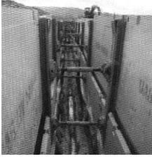
Barras, tubos o tablones que se utilizan en obra para soportar cargas verticales (puntales) u horizontales (codales). Se usan en entibaciones, apeos y refuerzos provisionales.
