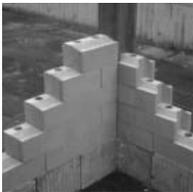
*Muro de carga de bloques de suelo-cemento machihembrados en seco (<http://www.crid.or.cr>)*
