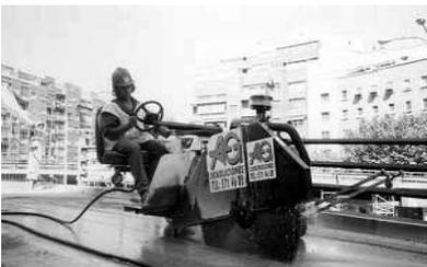
*Demolición de tablero por corte con disco*
