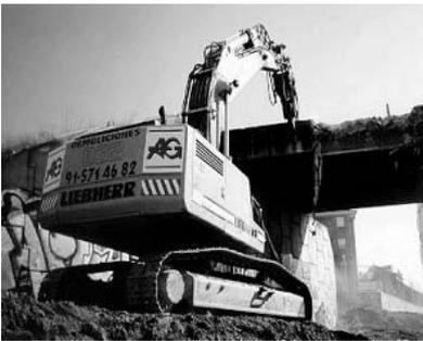
*Demolición de tablero con martillo hidráulico*
