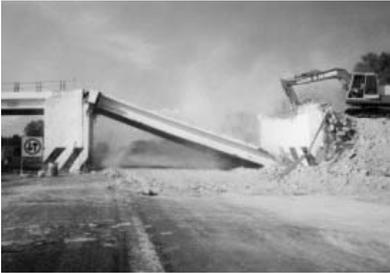
*Demolición de tablero por corte con martillo hidráulico*
