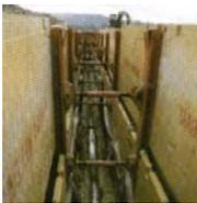
Sistema provisional de contención de tierras en vaciados del terreno, como taludes, zanjas, pozos, túneles y minas, que equilibra la presión que el terreno trasmite a las superficies del vaciado y permite trabajar en él.
