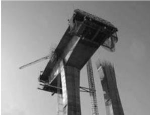
*Encofrado deslizante* <http://www.eipsa.net>
