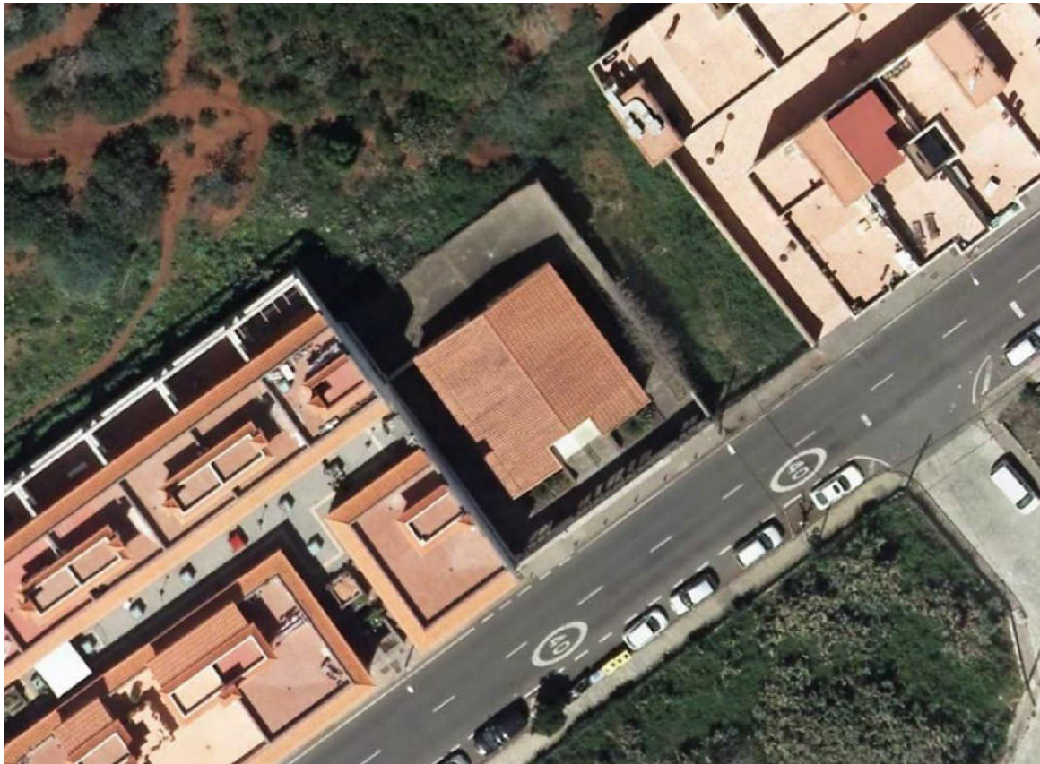
Imagen 1. Ortofoto de la parcela ocupada por el edificio.
