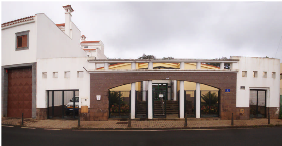
Imagen 2. Vista exterior del edificio
