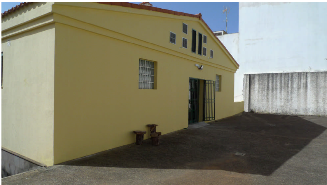
Fotografía 07.- Fachada posterior edificio existente (13 de marzo de 2016)
