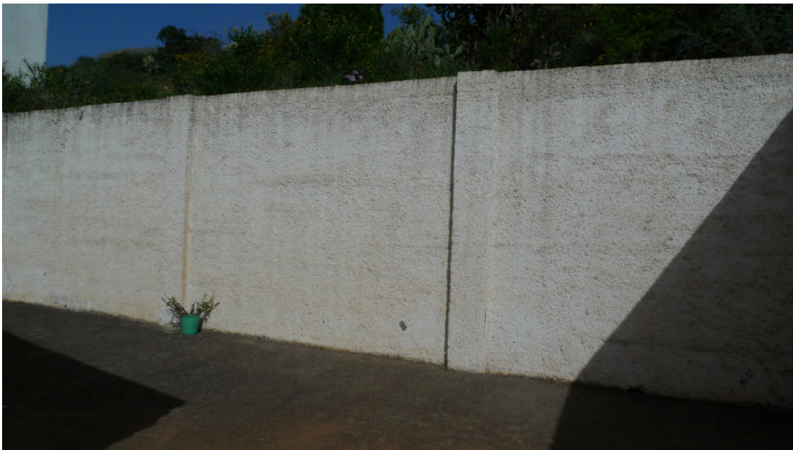
Fotografía 09.- Exterior cerramiento existente (13 de marzo de 2016)
