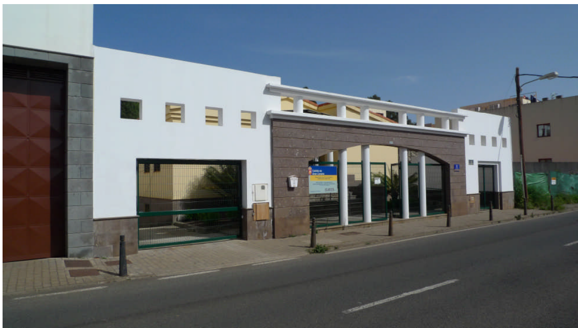
Fotografía 11.- Fachada principal del edificio acceso rodado (13 de marzo de 2016)
