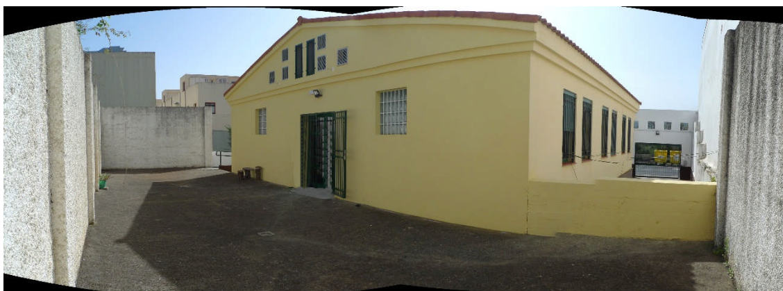
Fotografía 08.- Fachada posterior edificio existente y lateral rampa aparcamiento (13 de marzo de 2016)
