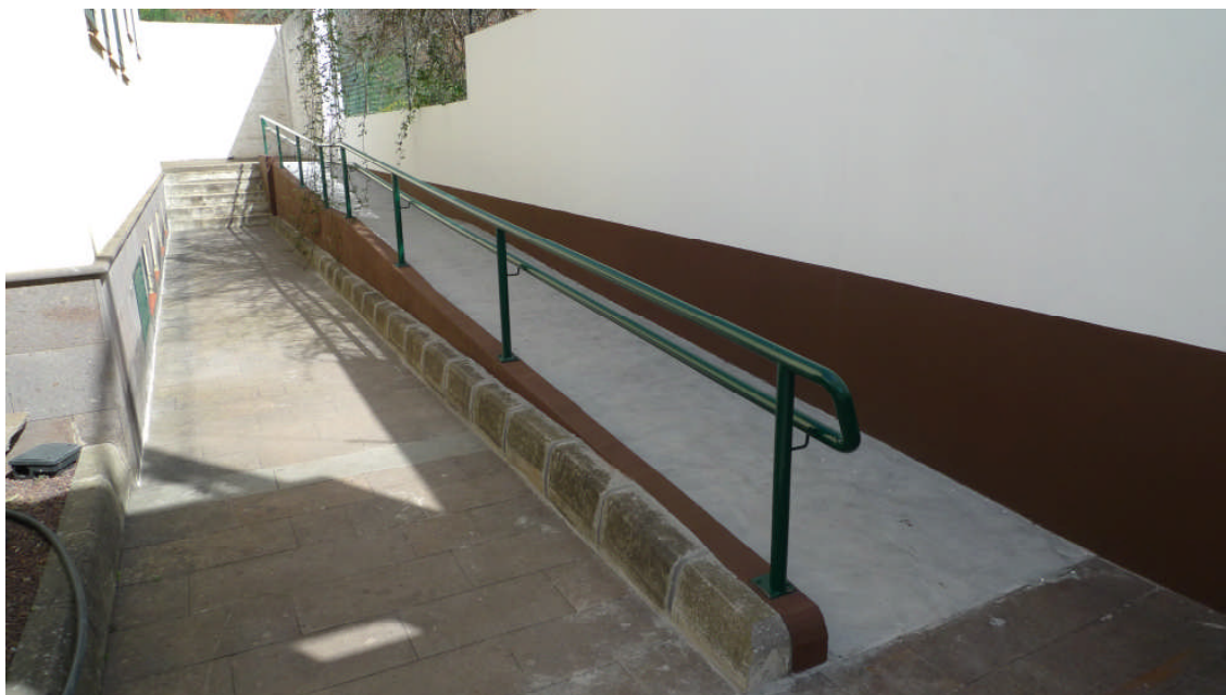
Fotografía 05.- Exterior de rampa de acceso lateral (31 de marzo de 2017)
