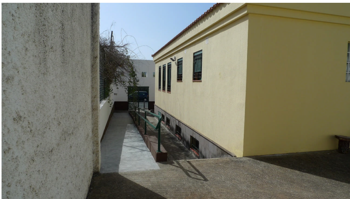
Fotografía 06.- Exterior de rampa de acceso lateral y edificio existente (13 de marzo de 2016)
