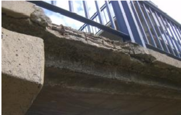
Fotografía extraída del Informe del estado de la pasarela
