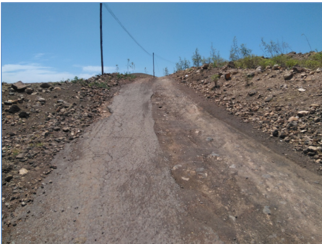
FOTO 5: Final del tramo 1.
