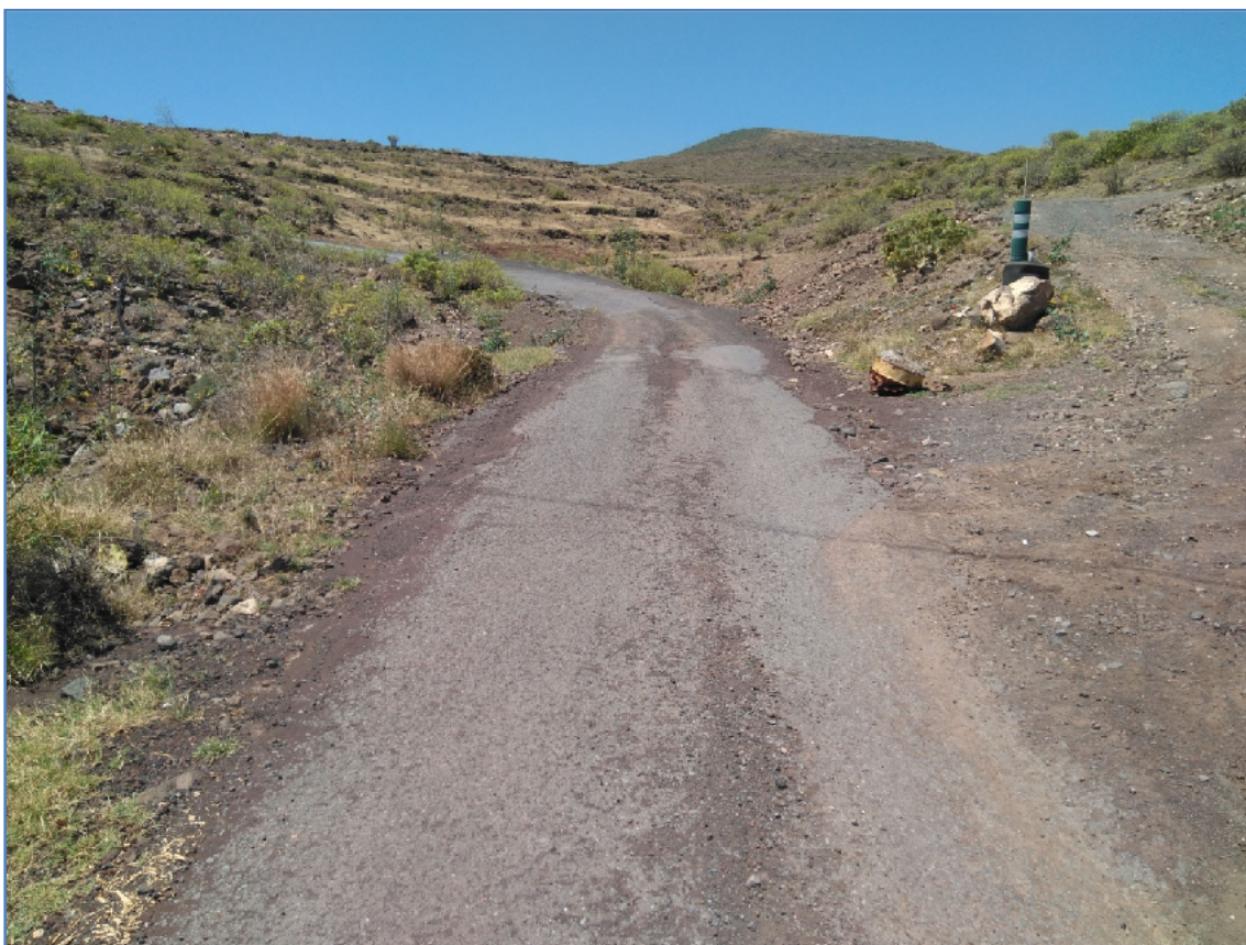
FOTO 2: Tramo 1, obra de paso del barranco en el inicio del giro a la izquierda.
