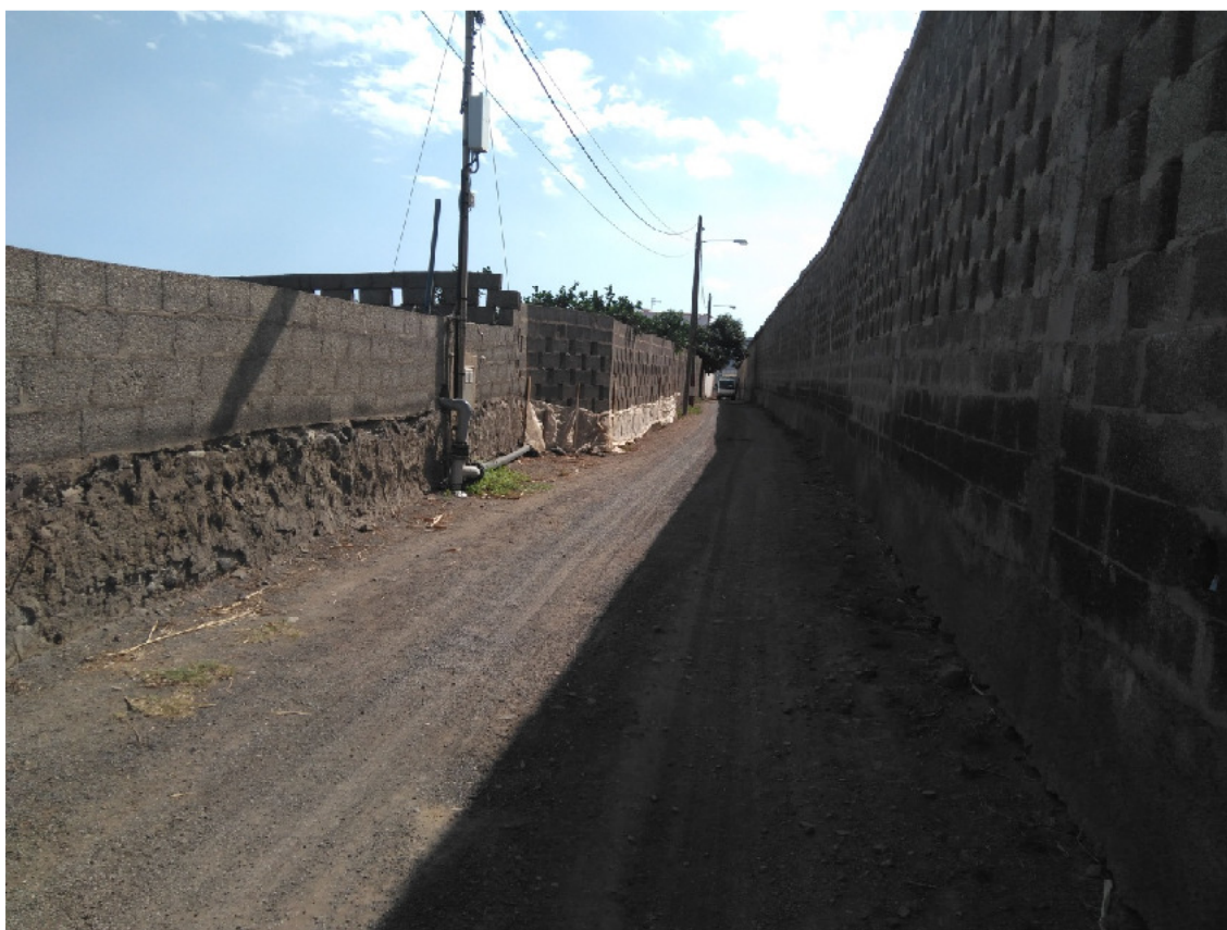
FOTO 16: Final del Tramo 4
