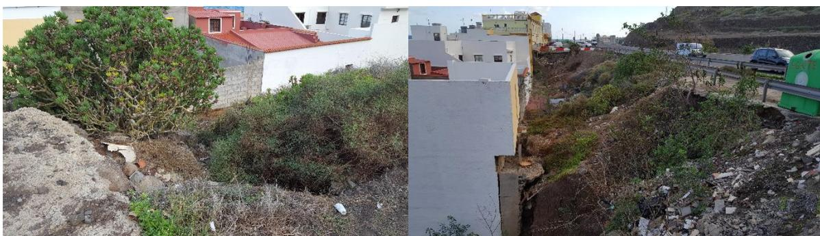
Terraplén por el lado del derrumbe con las marcas de las escorrentías
