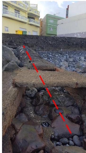
Posible trazado de la obra de drenaje transversal y del canal
