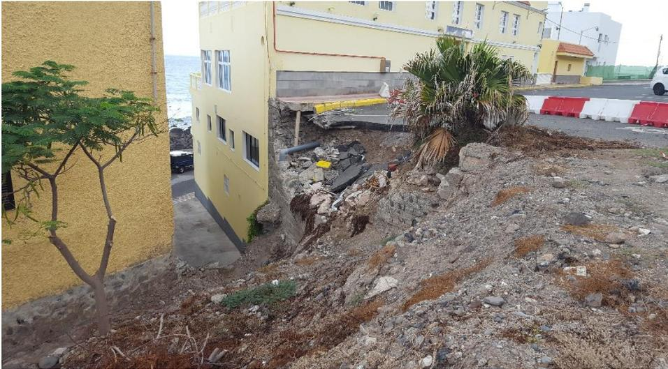
Foto del derrumbe del muro
