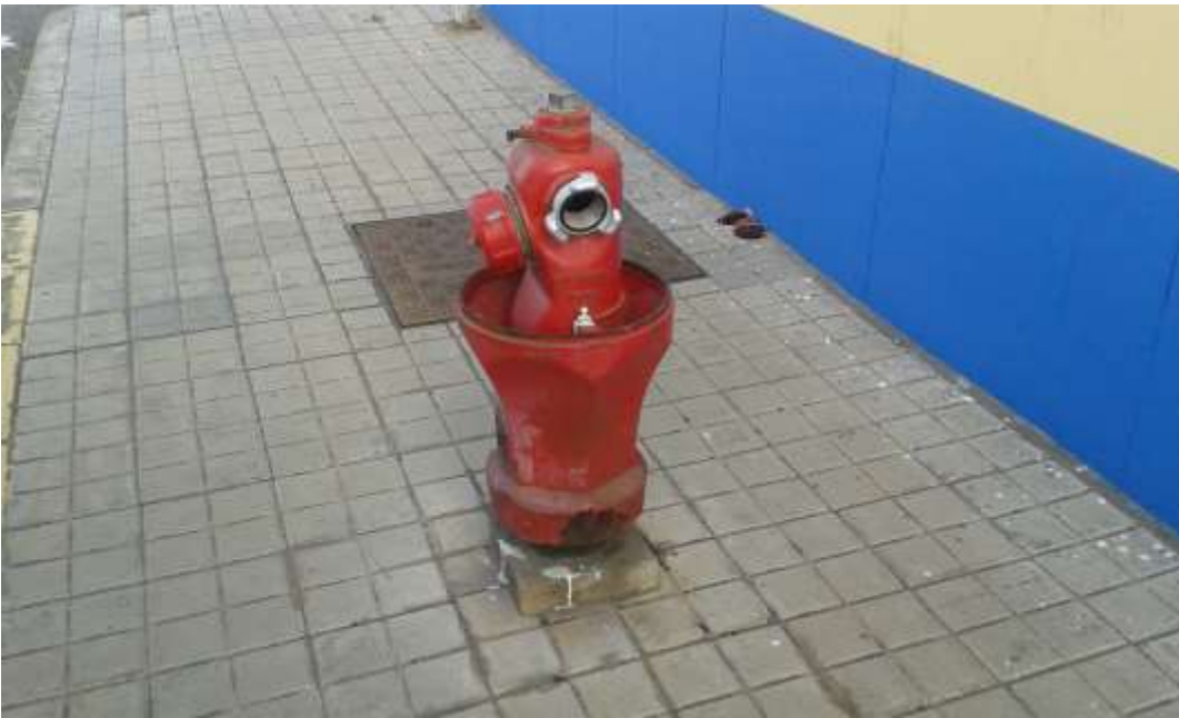
Imagen 2 del hidrante ubicado en fachada
