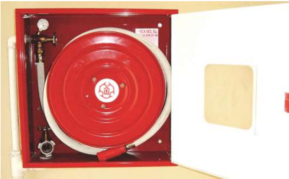
BIE de 25 mm con racor para BIE de 45 mm.
