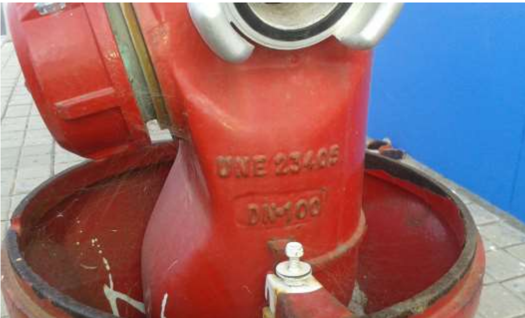
Imagen 3 del hidrante ubicado en fachada
