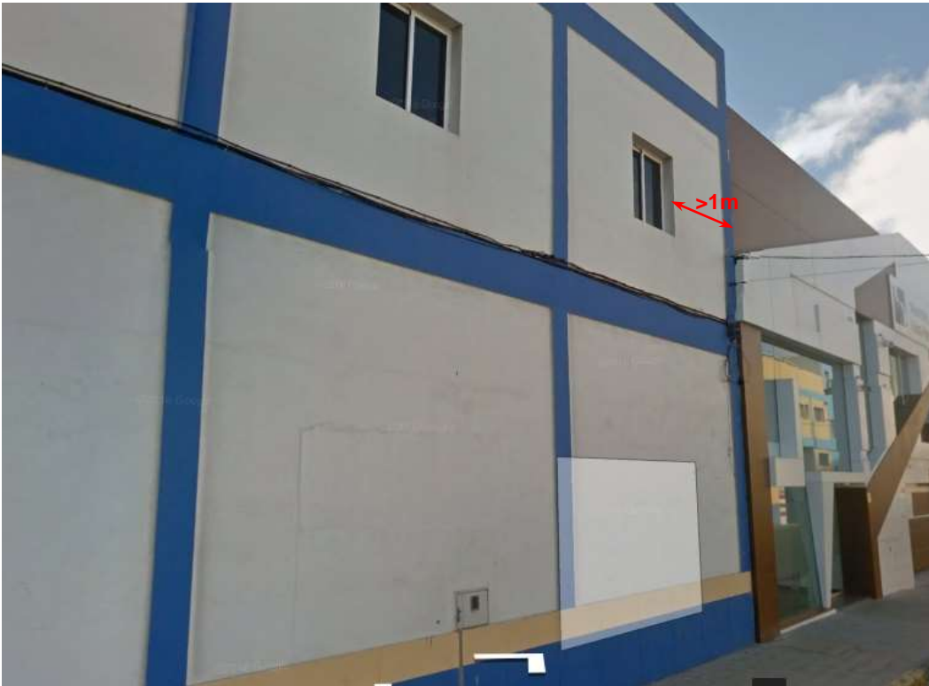
Imagen de la fachada del establecimiento.
