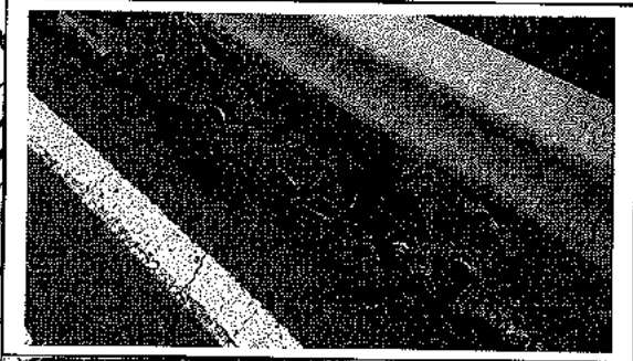
Detalle del estado del borde del asfalto
