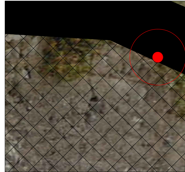
DETALLE DE LA MALLA DE TRIPLE TORSIÓN QUE VA ANCLADA A LA VIGA DE HORMIGÓN ARMADO DE 30X40cm Y QUE POSTERIORMENTE VA RECUBIERTA CON HORMIGÓN PROYECTADO PARA REFORZAR EL MURO DE CAL
