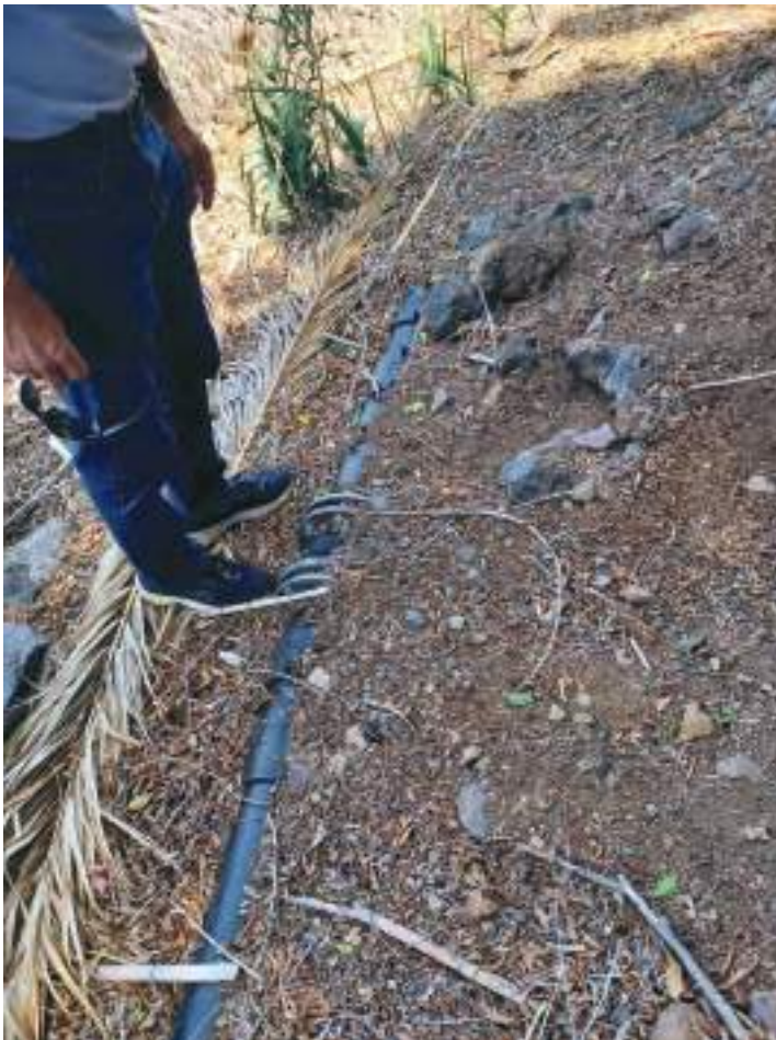
Foto nº 6: detalle de reparaciones realizadas en la red
