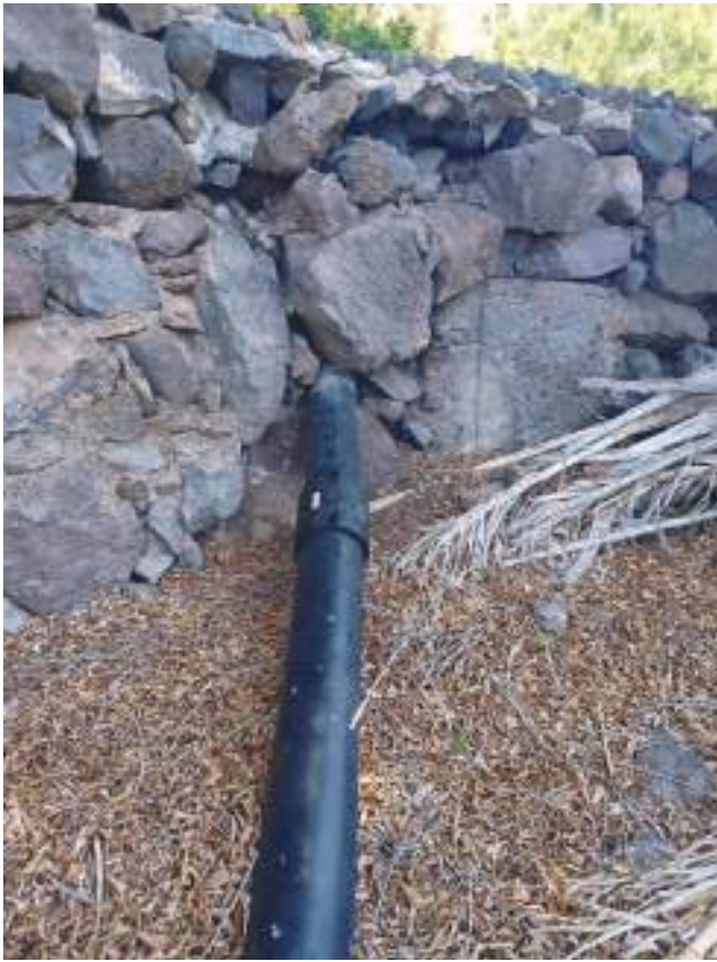
Foto nº 9: detalle de paso en muro
