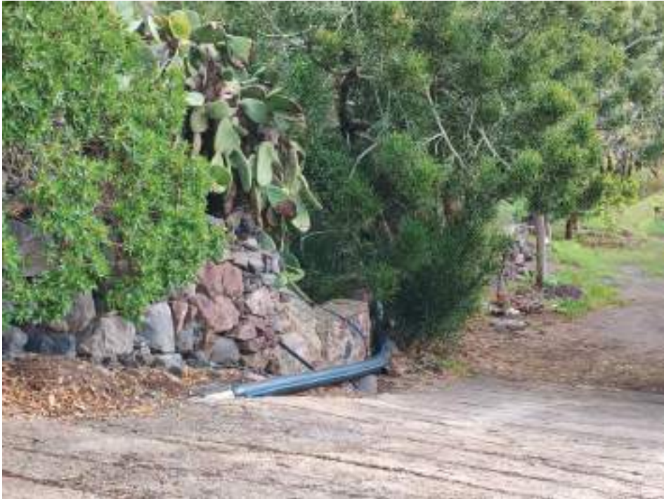
Foto nº 7: segundo cruce de hormigón
