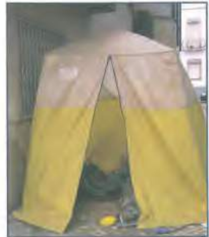
Caseta para proteger la soldadura de lluvia o viento.
