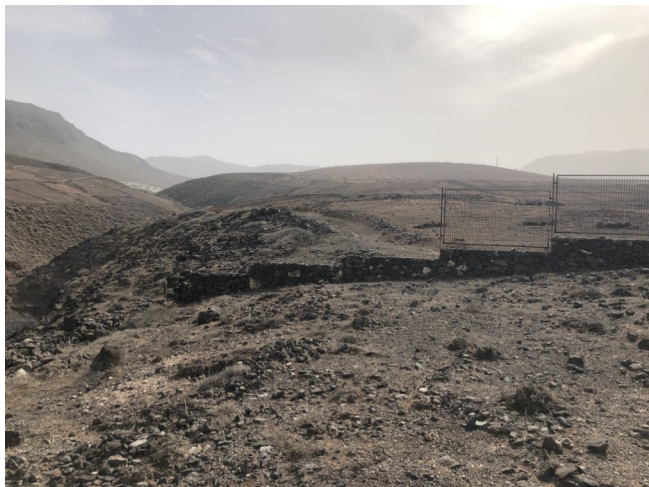
Imágenes del estado actual del cerramiento
