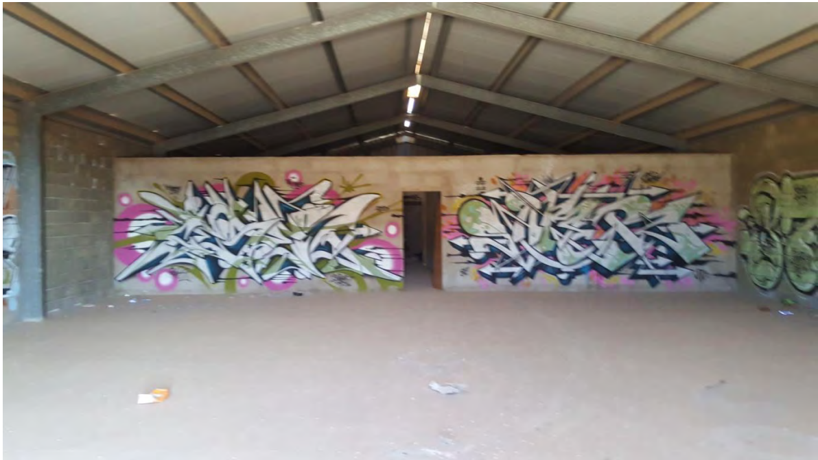
Foto 4. Interior edificio administrativo. Estado actual
