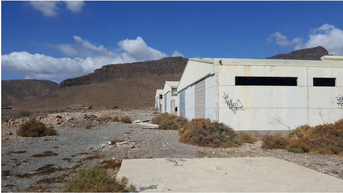
Foto 3. Exterior edificio toma de muestras. Estado actual
