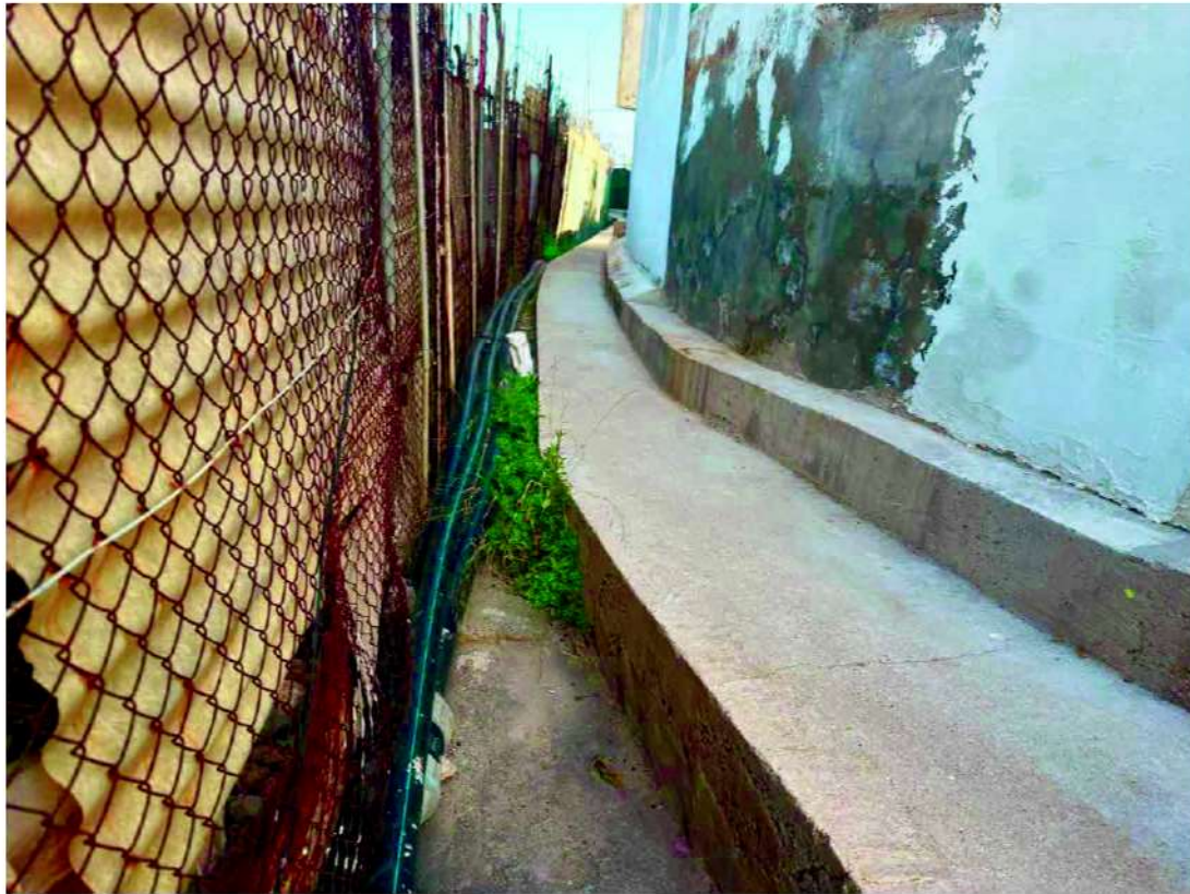
Imagen 4. Tramo de la acequia tapada donde irá la tubería
