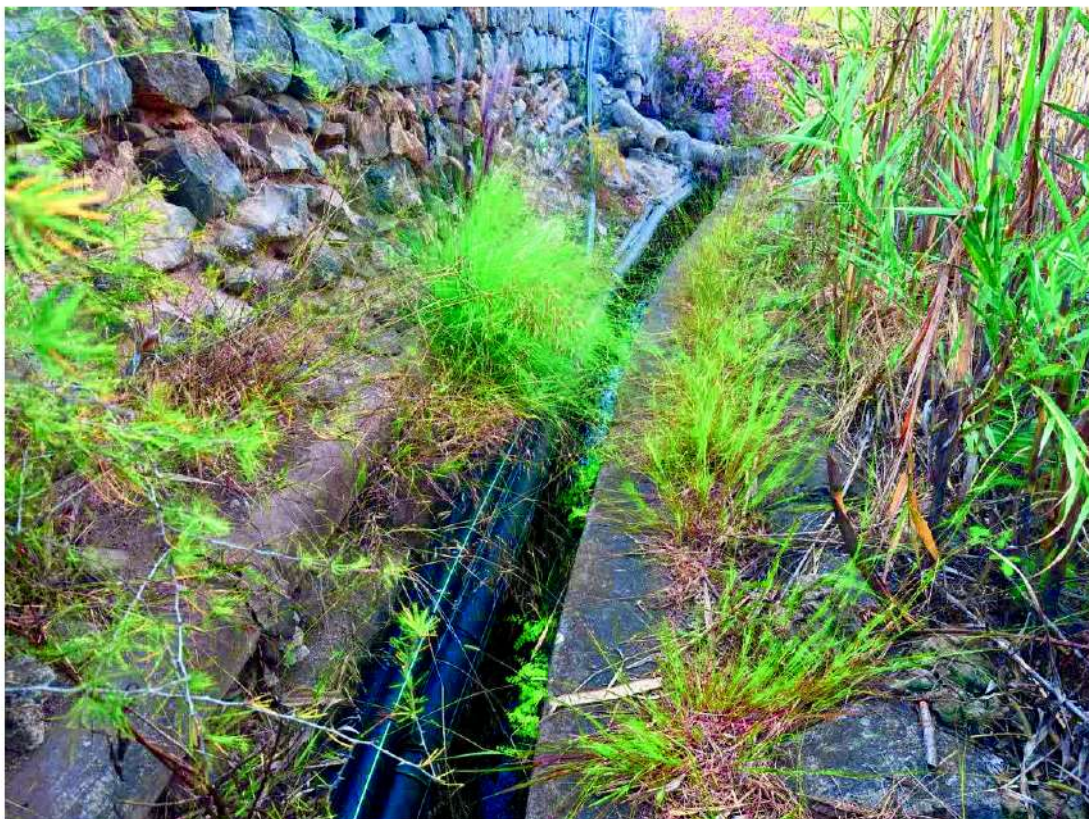
Imagen 3. Otro tramo de la acequia donde irá la tubería.
