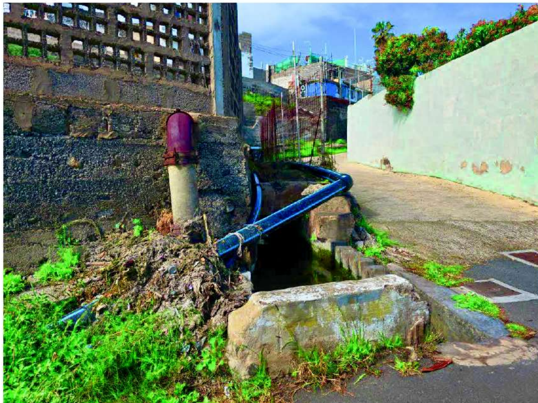
Imagen 5. Zona acequia en cruce desde Pasaje Adargoma a carretera Camino del Guincho
