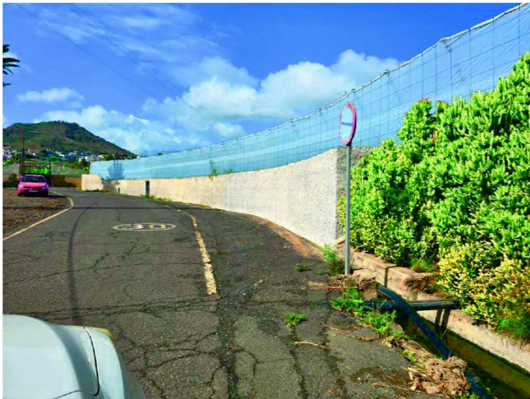
Imagen 8. Otra imagen tramo de acequia en margen de carretera Camino del Guincho.
