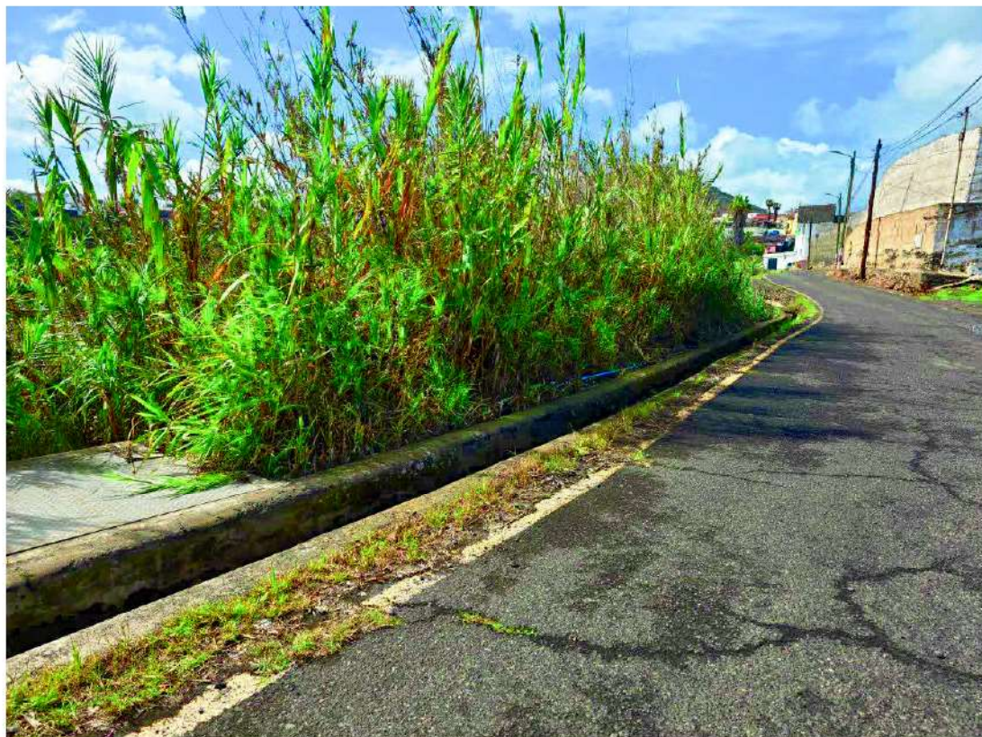
Imagen 7. Otra imagen tramo de acequia en margen de carretera Camino del Guincho.
