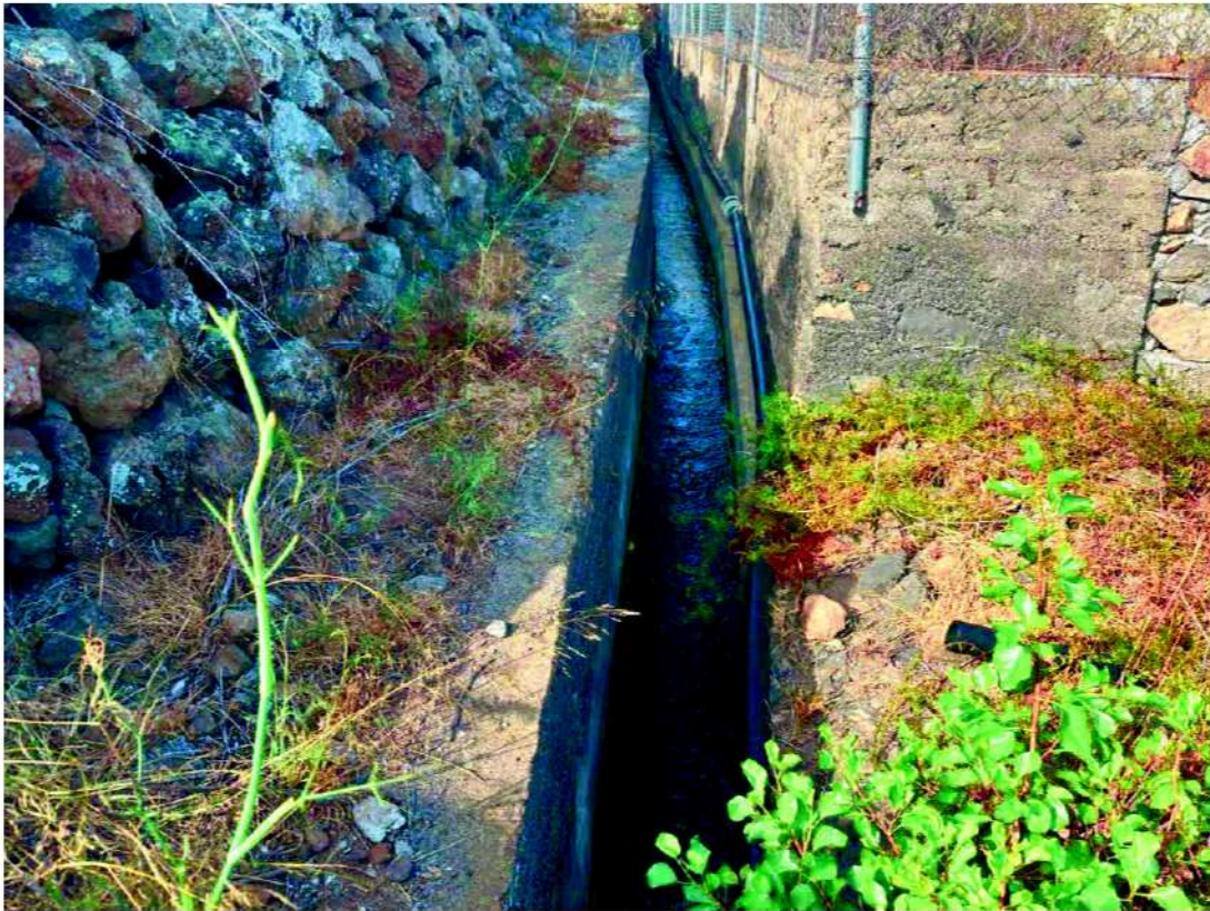
Imagen 2. Tramo de la acequia donde irá la tubería
