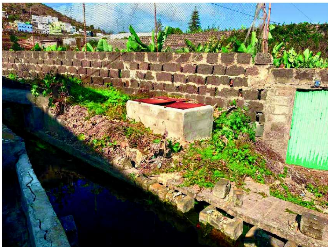
Imagen 1. Vista del inicio de la instalación de la tubería en zona conocida como El Molino; Zona de conexión con tramo pendiente de ejecutar y ubicación de arqueta
