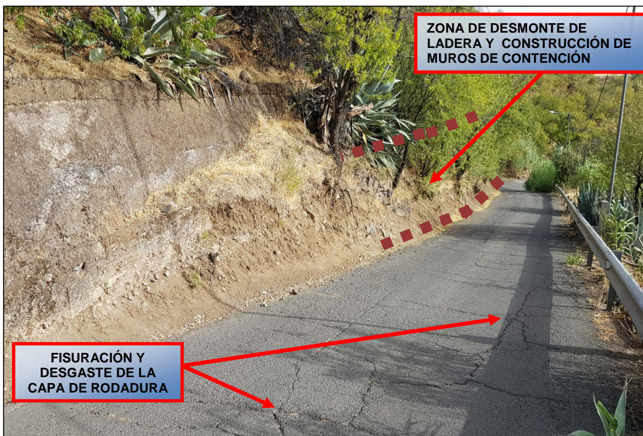
Fotografía Nº 8 (Vista panorámica del acceso al Barrio de El Majuelo a repavimentar - Tramo nº1)
