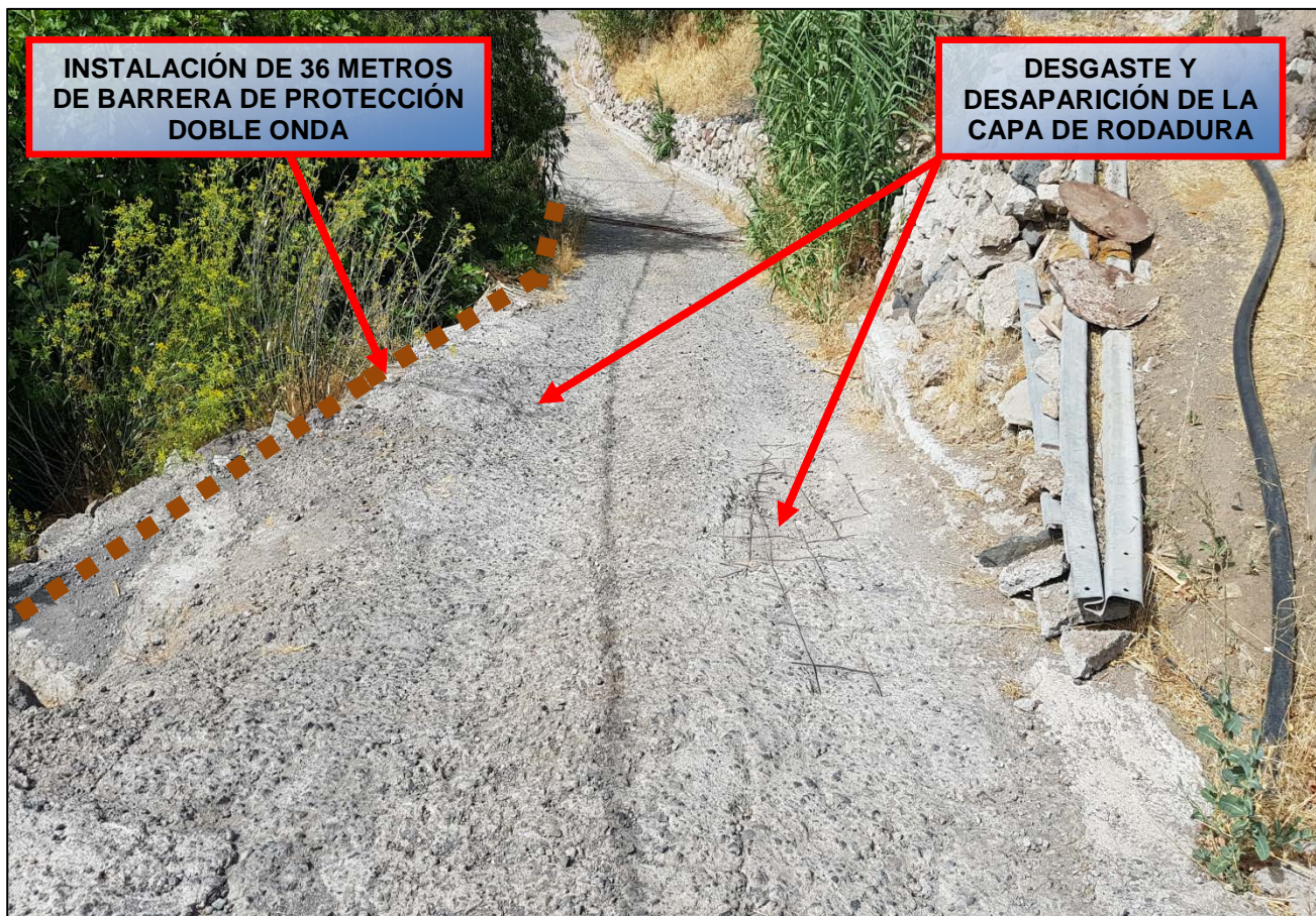
Fotografía Nº 15 (Vista panorámica del acceso al Barrio de El Majuelo a repavimentar - Tramo nº2)
