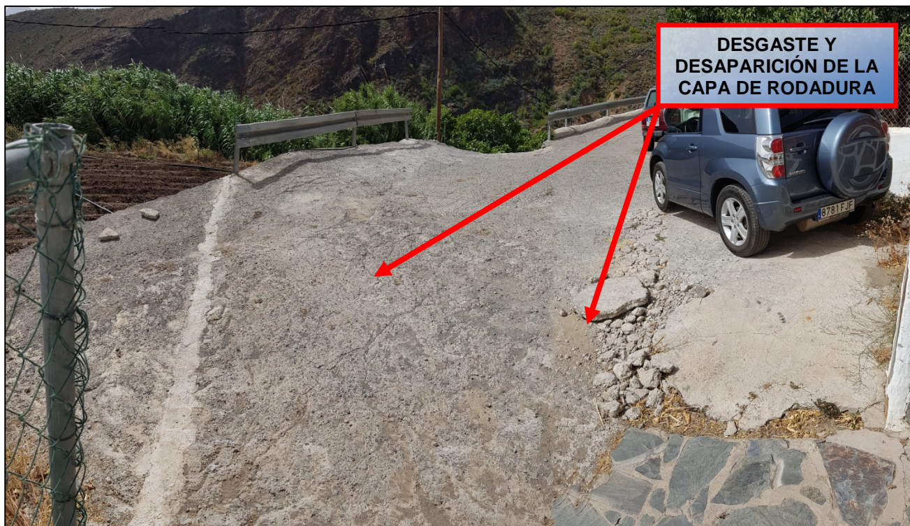
Fotografía Nº 13 (Vista panorámica del acceso al Barrio de El Majuelo a repavimentar - Tramo nº2)
