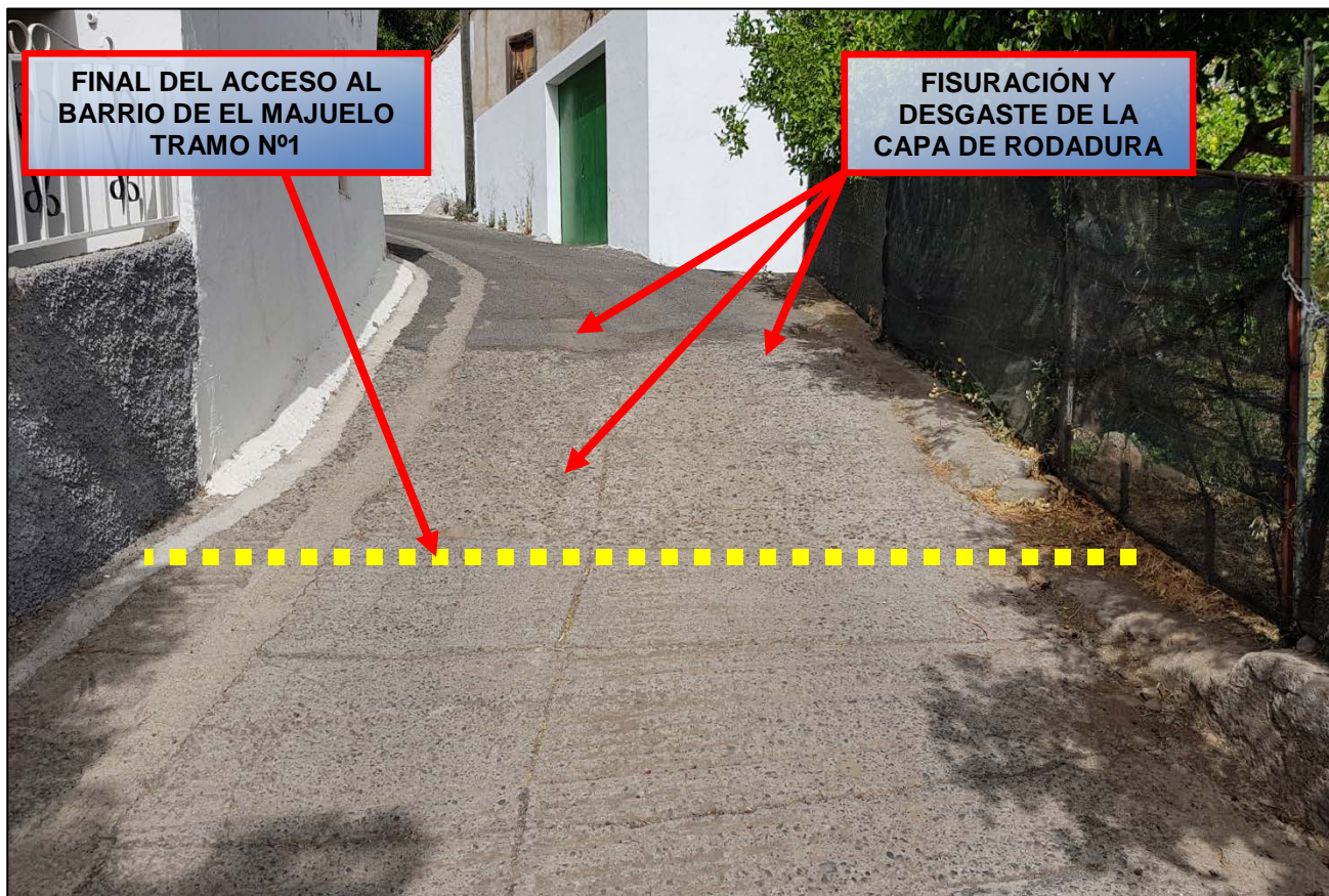
Fotografía Nº 11 (Vista panorámica, final del acceso al Barrio de El Majuelo a repavimentar - Tramo nº1)
