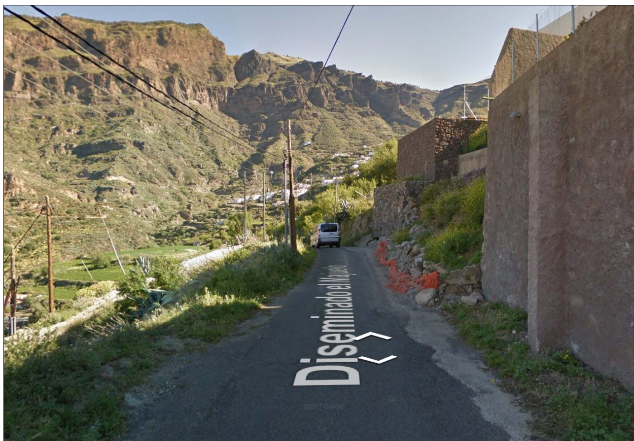
Fotografía Nº 2 (Vista panorámica del acceso al Barrio de El Majuelo a repavimentar - Tramo nº1)
