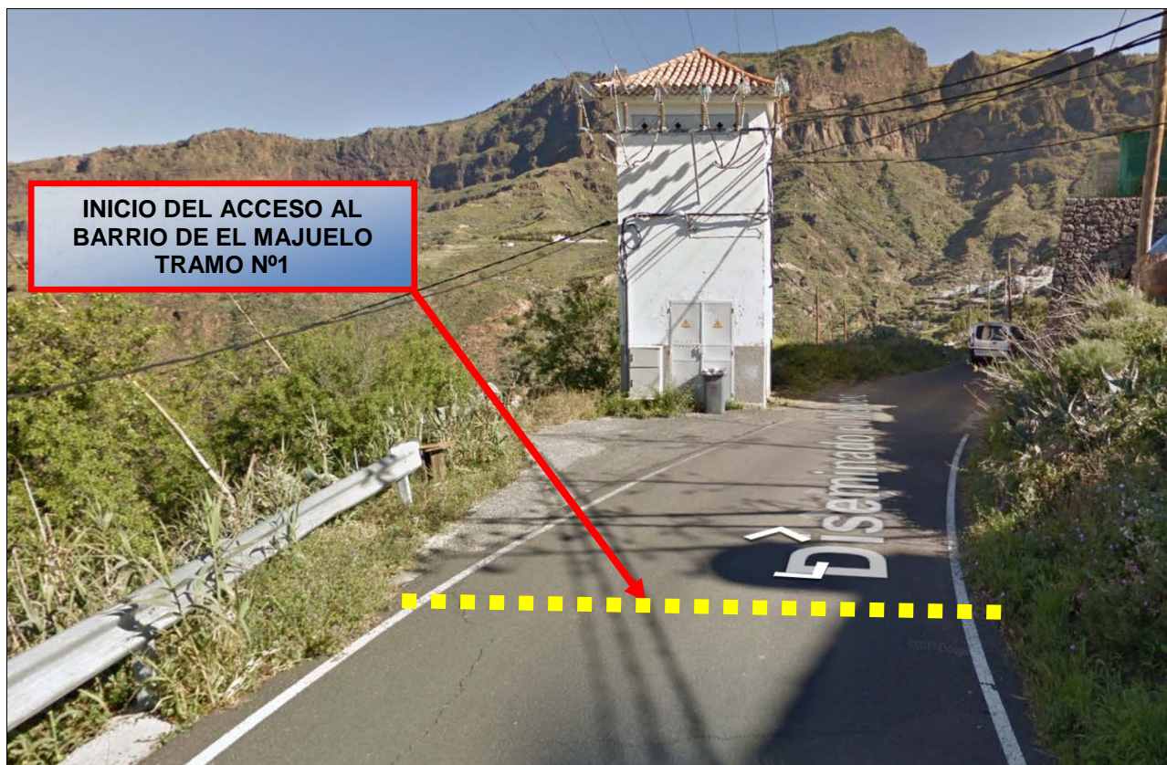
Fotografía Nº 1 (Vista panorámica, Inicio del acceso al Barrio de El Majuelo a repavimentar - Tramo nº1)
