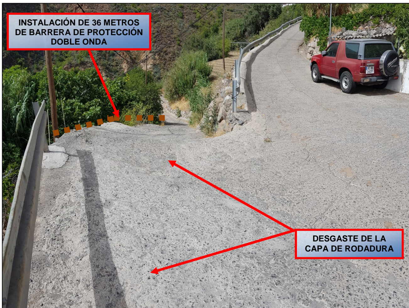
Fotografía Nº 14 (Vista panorámica del acceso al Barrio de El Majuelo a repavimentar - Tramo nº2)
