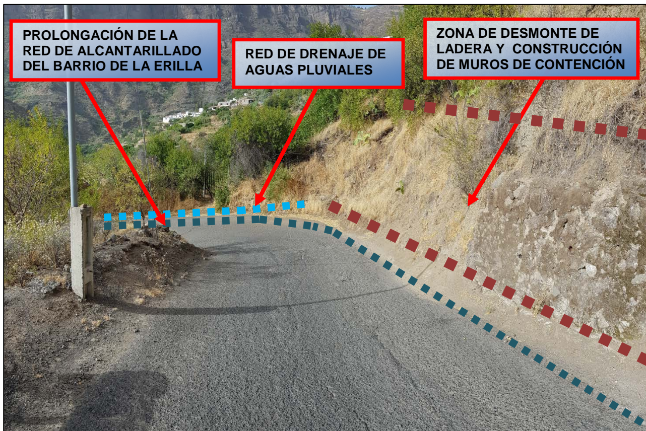
Fotografía Nº 5 (Vista panorámica del acceso al Barrio de El Majuelo a repavimentar - Tramo nº1)
