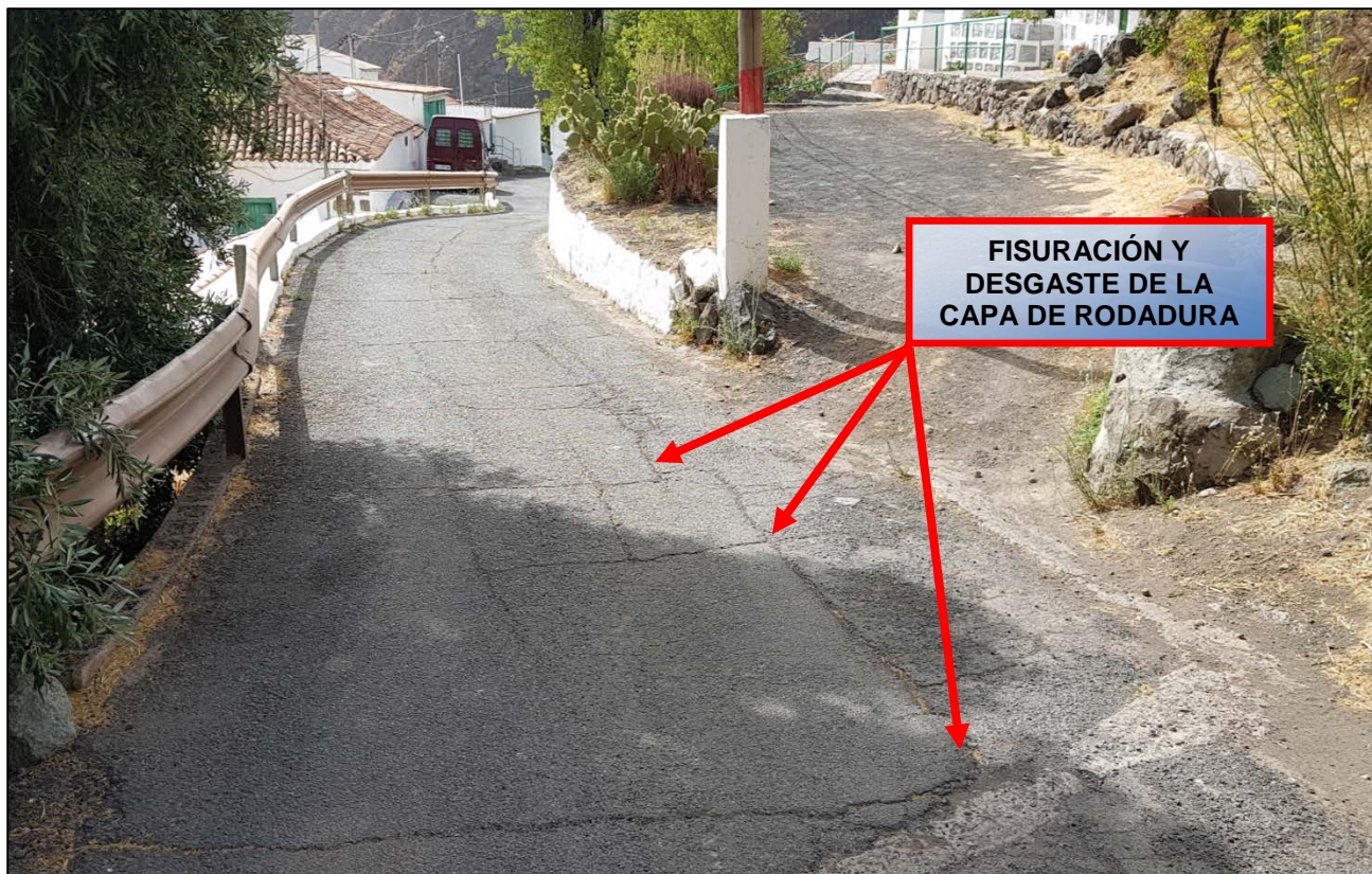
Fotografía Nº 10 (Vista panorámica del acceso al Barrio de El Majuelo a repavimentar - Tramo nº1)
