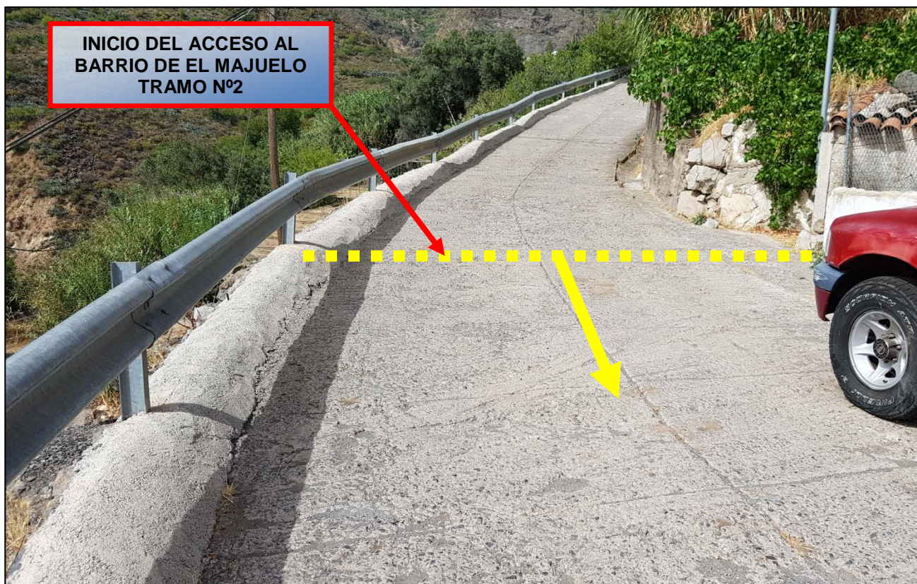
Fotografía Nº 12 (Vista panorámica, inicio del acceso al Barrio de El Majuelo a repavimentar - Tramo nº2)
