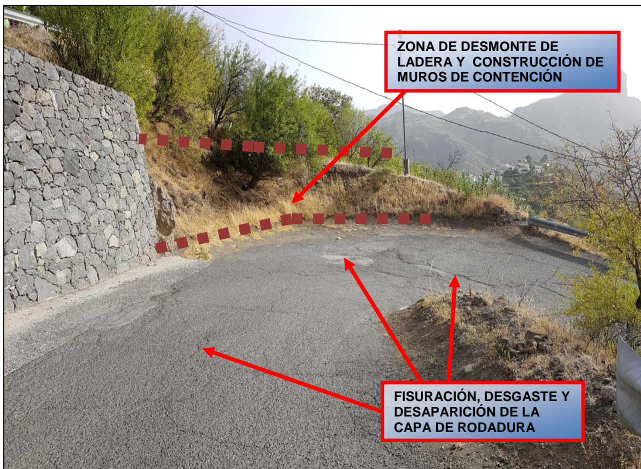
Fotografía Nº 6 (Vista panorámica del acceso al Barrio de El Majuelo a repavimentar - Tramo nº1)
