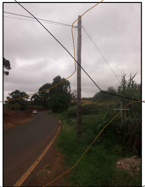
FOTO 1 (POSTES DE TELEFONÍA)
