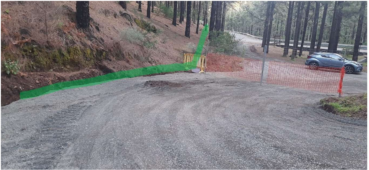
Bajada tubería por m.i. pista forestal hasta m.i. GC-150
