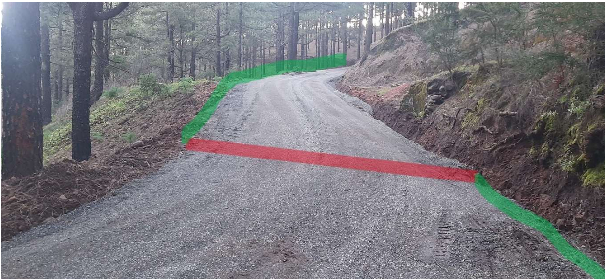
Bajada tubería por m.d . pista forestal y detalle cruce (pasatubo).
