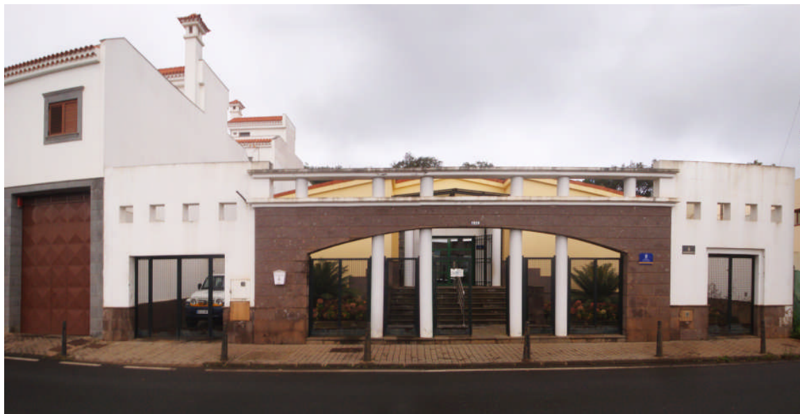
Imagen 2. Vista exterior del edificio
