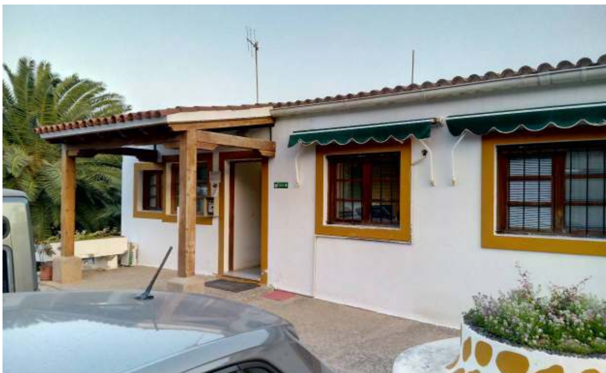
Vista Exterior Administración Alta. Fachada Sur, Accesos
