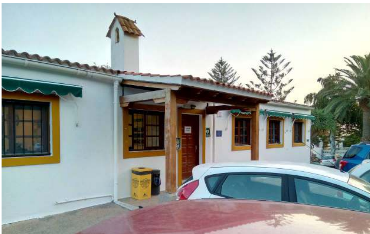
Vista Exterior Administración Alta. Fachada Sur, Accesos
