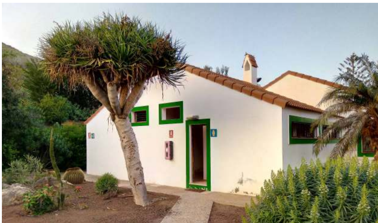
Vista Exterior Vestuarios. Acceso Masculino
