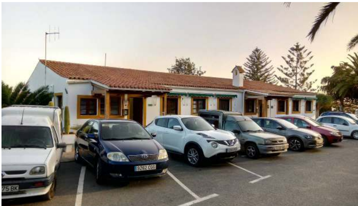
Vista Exterior Administración Alta. Fachada Sur, Accesos
