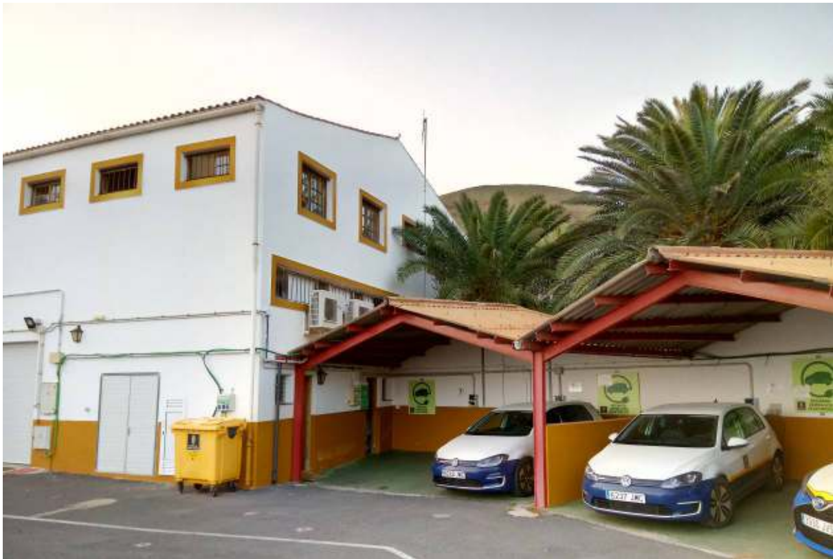
Vista Exterior Administración Alta. Fachada Norte
