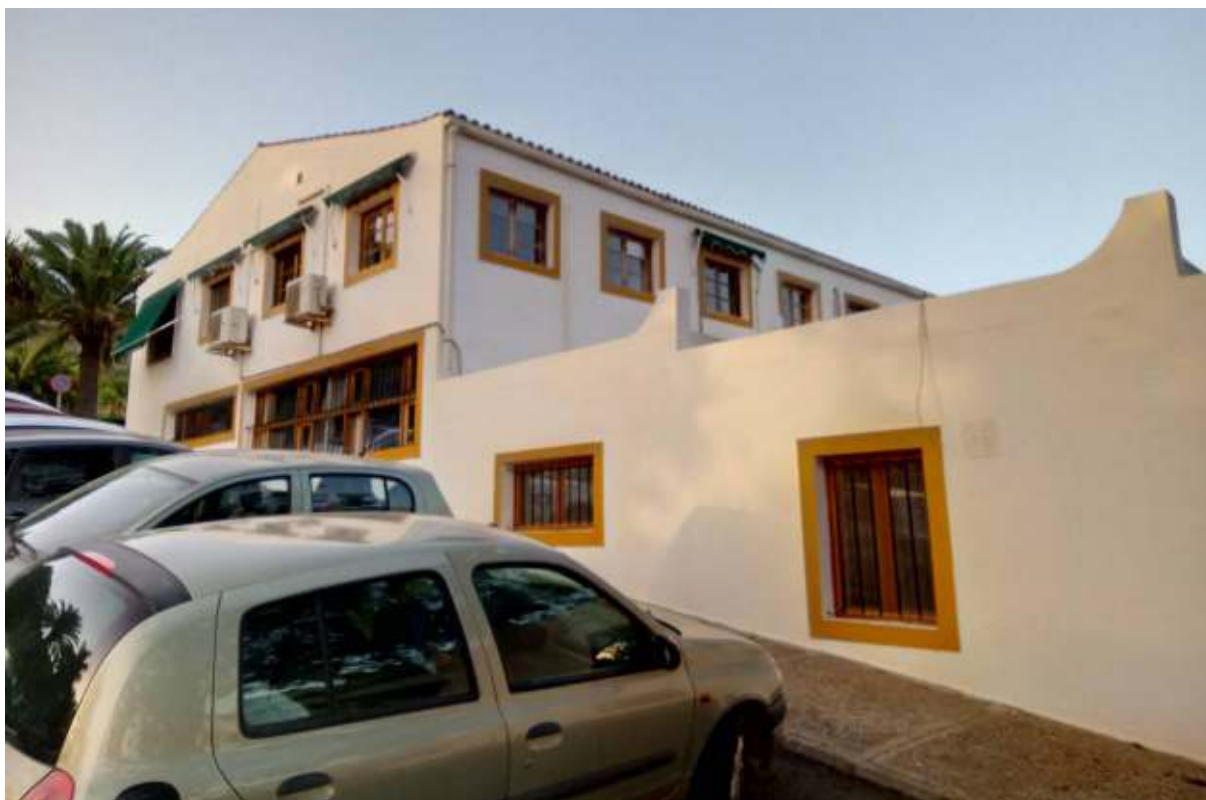
Vista Exterior Administración Alta. Fachada Este
