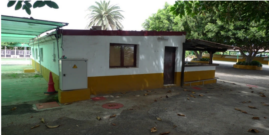
Imagen 4. Vistas exterior de la edificación existente
