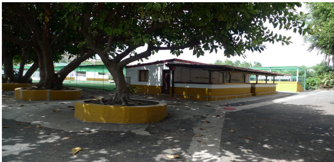
Imagen 3. Vista exterior del edificio
