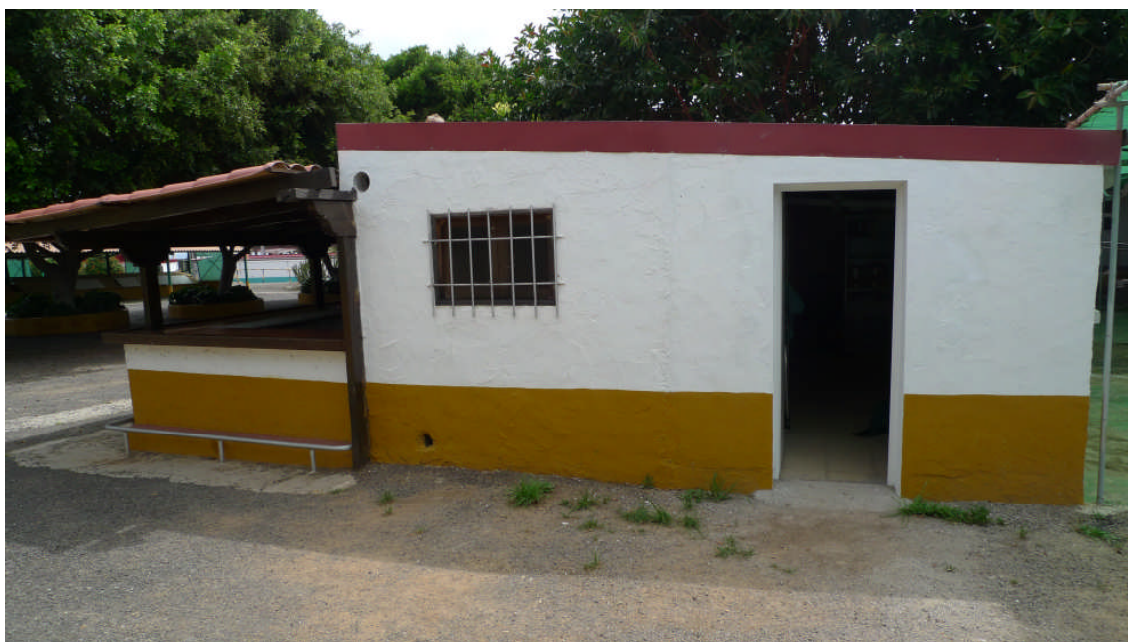
Fotografía 09.- Fachada lateral del edificio existente (13 de marzo de 2016)
