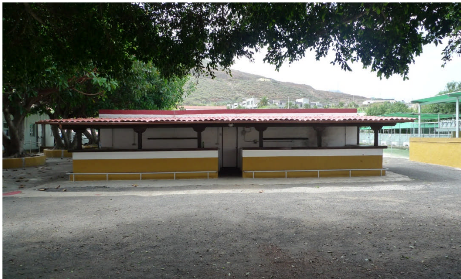
Imagen 5. Vistas exterior de la edificación existente
