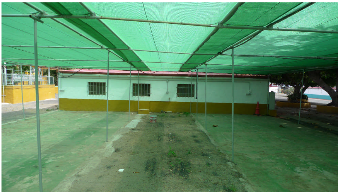
Fotografía 08.- Fachada trasera del edificio existente (13 de marzo de 2016)
