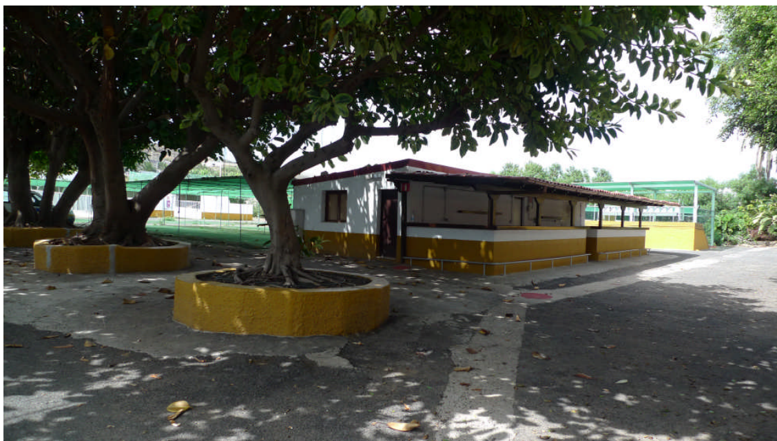
Fotografía 06.- Exterior del edificio existente (31 de marzo de 2017)
