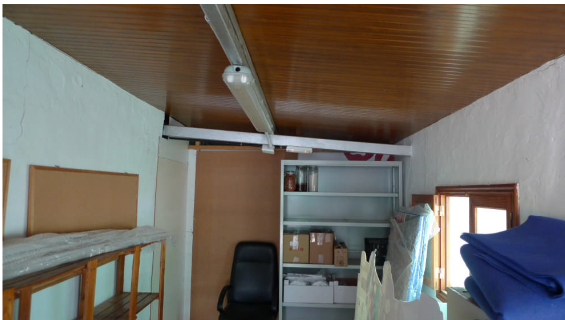
Fotografía 10.- Interior del edificio existente (13 de marzo de 2016)
