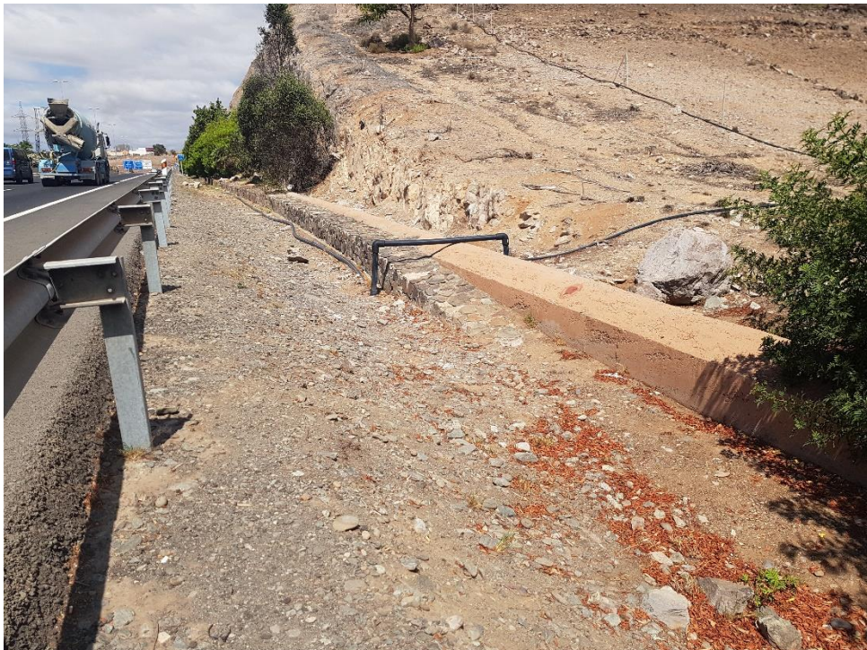
Foto 22: Aspecto P.K. 44+900, margen derecho. Zona 4 T. Cuneta y recubrimiento tubería existente.
