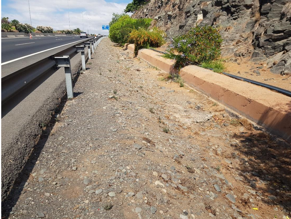
Foto 21: Aspecto P.K. 44+650, margen derecho. Zona 6 T. Cuneta y recubrimiento tubería existente.
