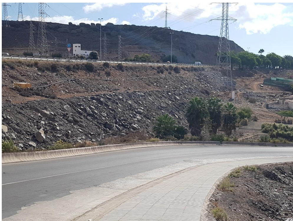
Foto 1: Aspecto terraplén P.K. 45+400 a pk 45+200, margen izquierdo. Zona 1 M
