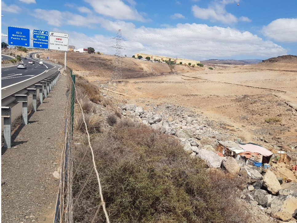
Foto 25: Aspecto P.K. 45+450, margen derecho. Zona 1 T.
