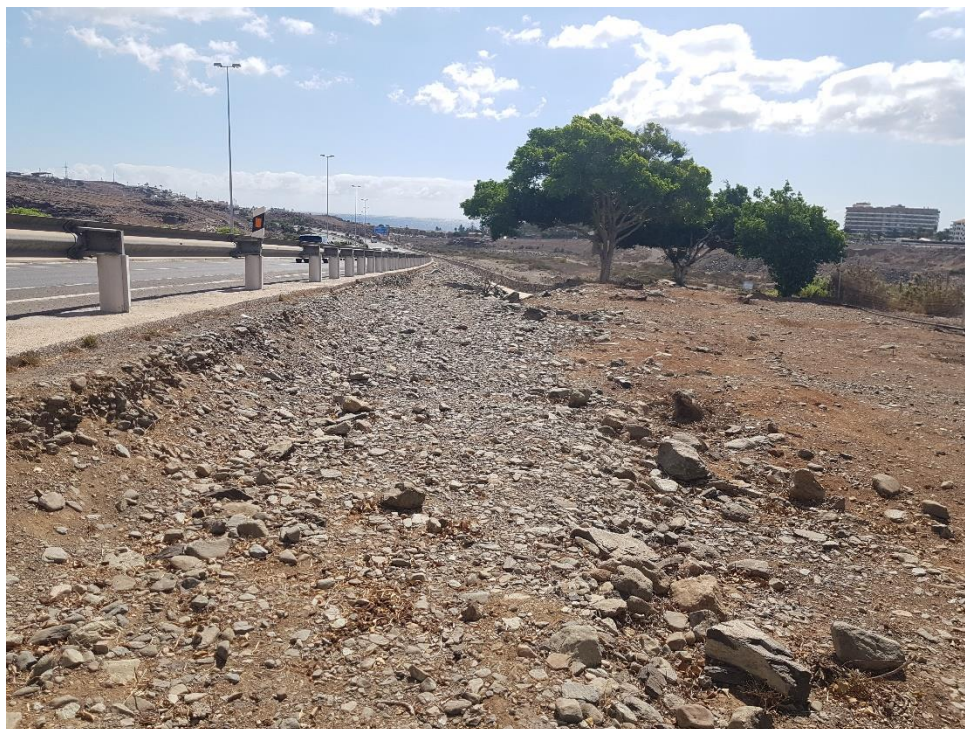
Foto 13: Aspecto P.K. 44+250, margen izquierdo. Zona 10 M
