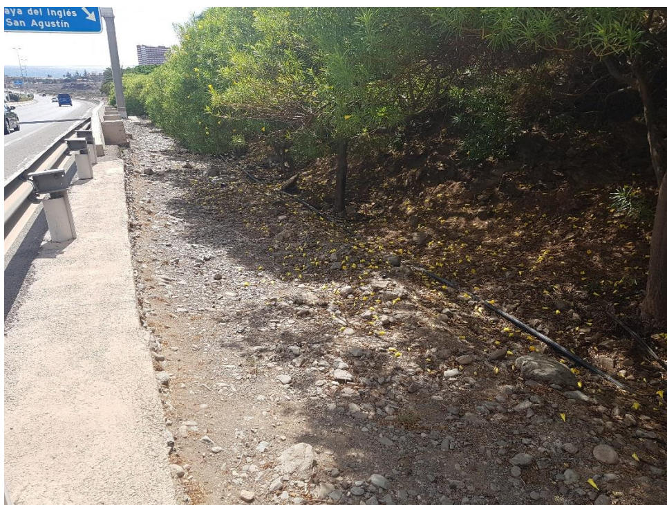
Foto 12: Aspecto P.K. 44+350, margen izquierdo. Zona 9 M
