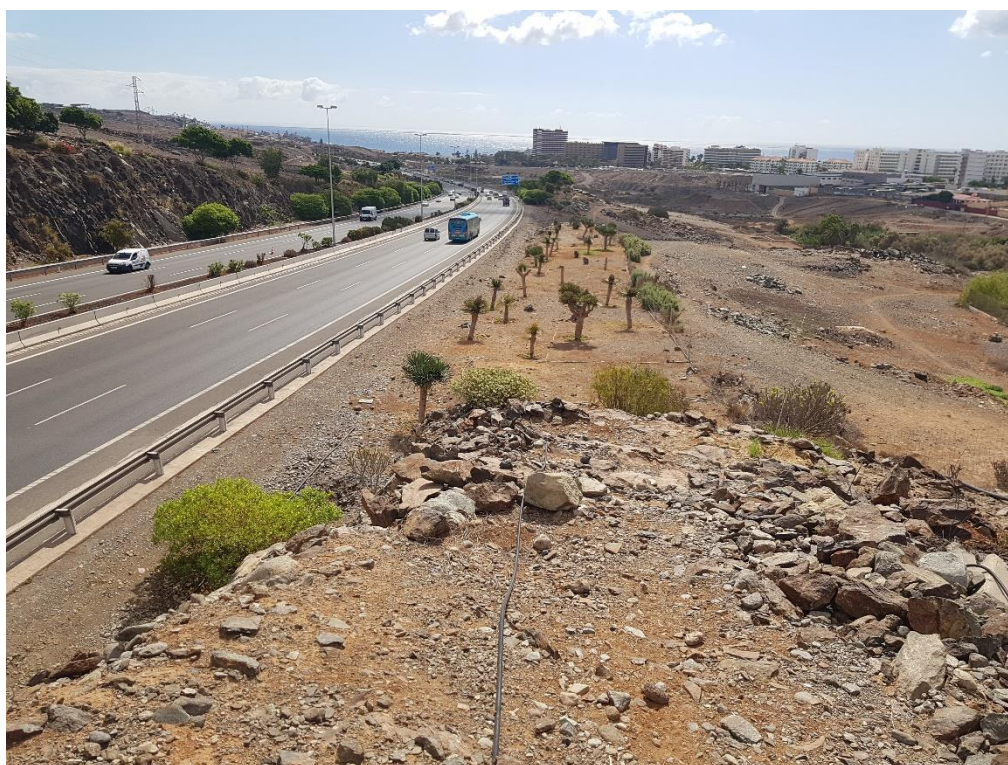
Foto 10: Aspecto P.K. 44+600, margen izquierdo. Zona 7 M
