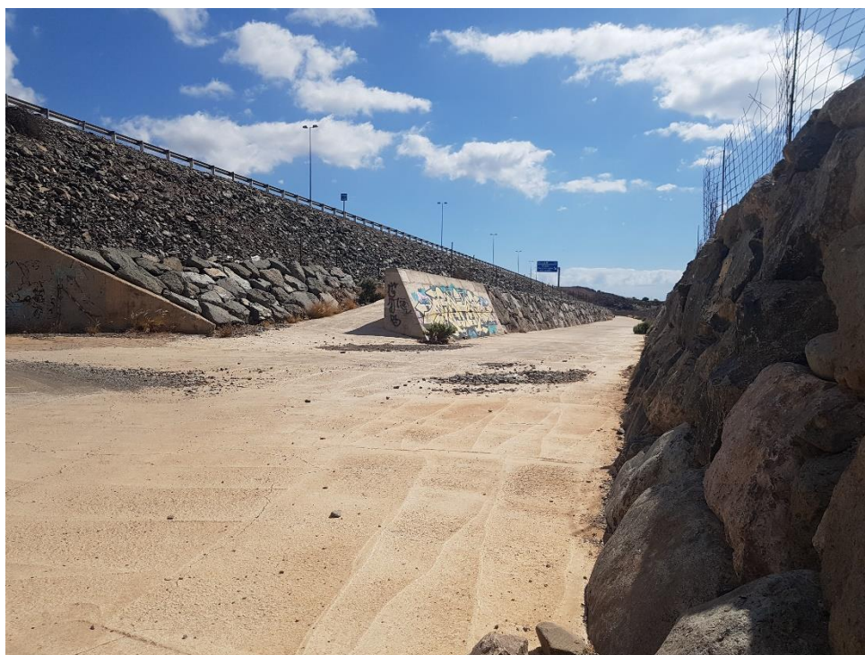
Foto 15: Aspecto P.K. 44+050, margen izquierdo. Zona 11 M
