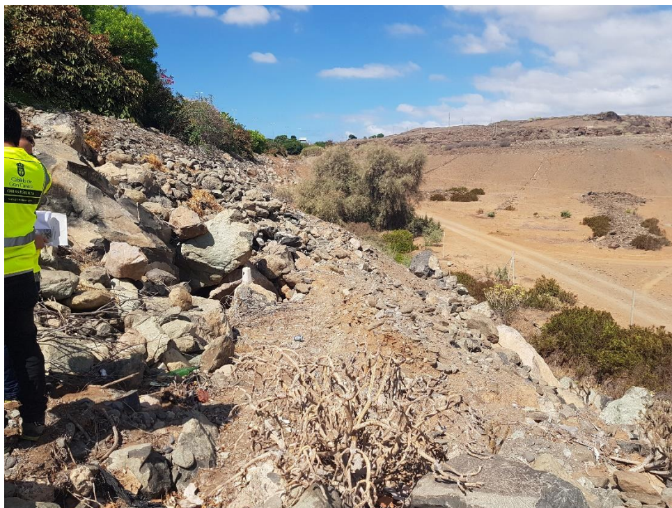
Foto 17: Aspecto P.K. 43+625, margen derecho. Zona 7 T.
