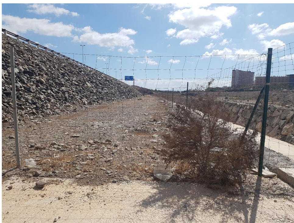
Foto 16: Aspecto P.K. 44+050, margen izquierdo. Zona 11 M
