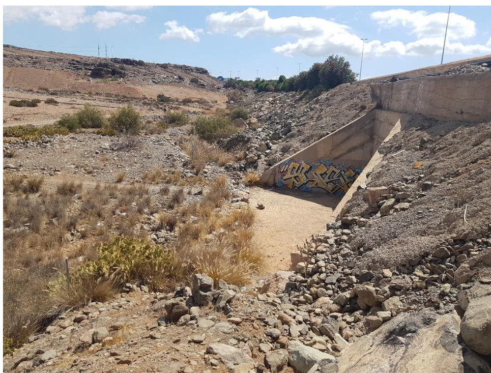
Foto 18: Aspecto P.K. 43+625, margen derecho. Zonas 7, 8, 9 y 10 T.
