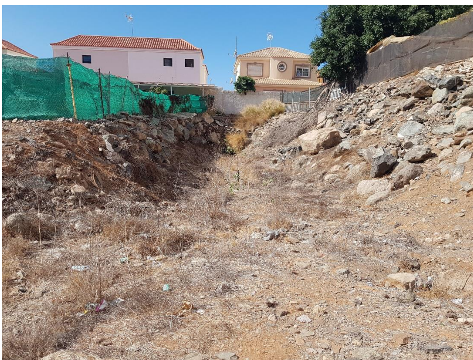
Foto 7 y 8: Aspecto P.K. 44+850, margen izquierdo. ODT
