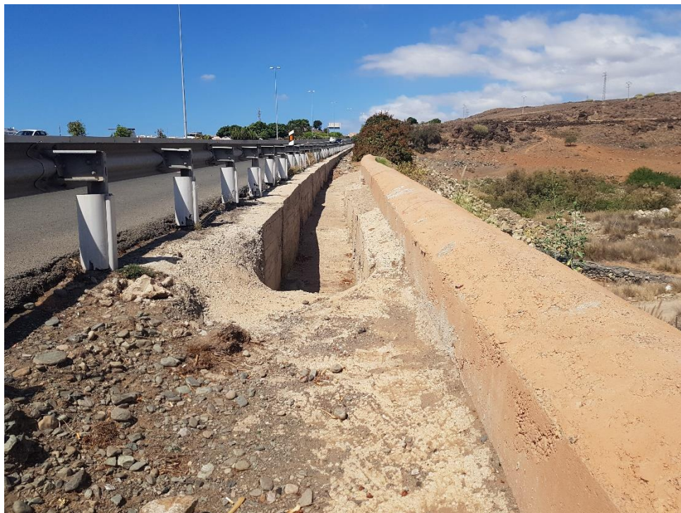
Foto 20: Aspecto P.K. 43+800, margen derecho. Zona 7 T. Cuneta y recubrimiento tubería existente.
