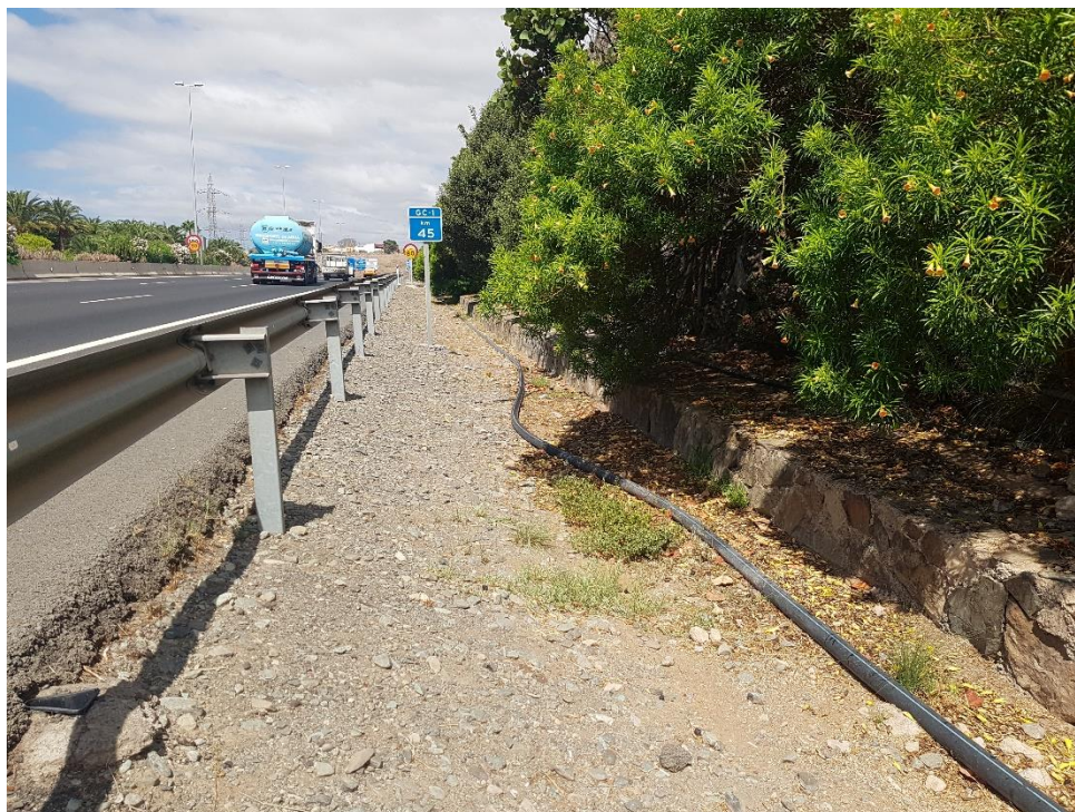
Foto 23: Aspecto P.K. 45+000, margen derecho. Zona 3 T. Cuneta y recubrimiento tubería existente.
