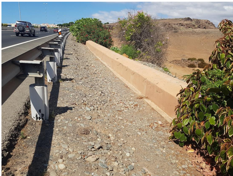
Foto 19: Aspecto P.K. 43+650, margen derecho. Zona 7 T. Cuneta y recubrimiento tubería existente.
