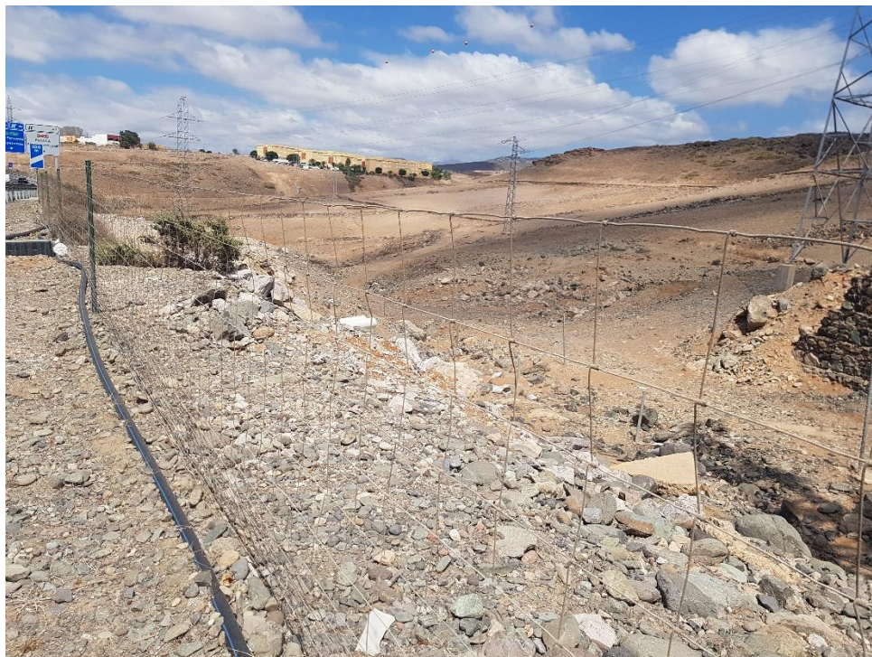
Foto 24: Aspecto P.K. 45+250, margen derecho. Zona 2 T.
