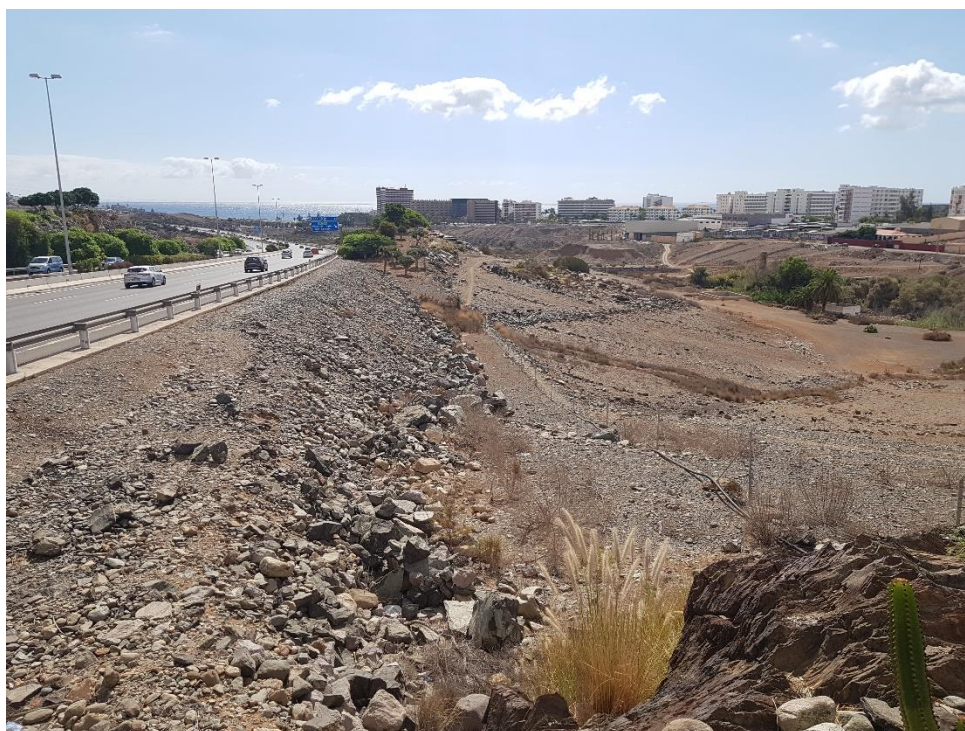
Foto 11: Aspecto P.K. 44+450, margen izquierdo. Zona 8 M
