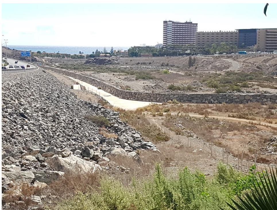
Foto 14: Aspecto P.K. 44+200, margen izquierdo. Zona 11 M
