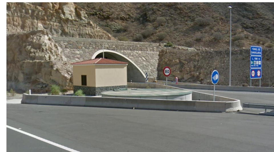
Imagen 2-1.-Depósito regulador en el Barranco de Candelaria
