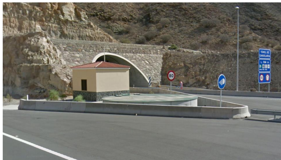
Imagen 1-1.-Depósito de abastecimiento de los Túneles de Tauro y Candelaria
