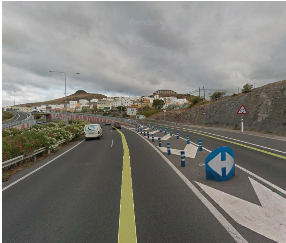
Figura 15. Divergencia calzada GC-3 sentido Arucas - Tamaraceite.
