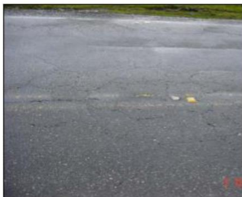
Detalle de la Figuración por Bloque (FB)
