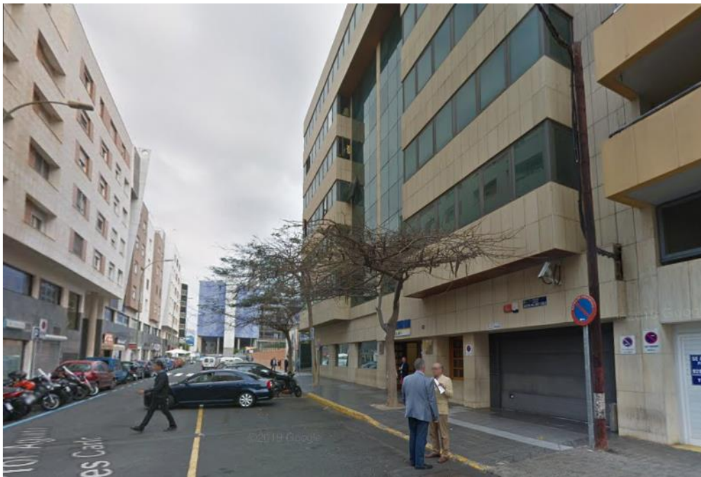
Vista exterior del Edificio Insular I, donde se aprecia el tipo de fachada con carpintería continua en su perímetro.
