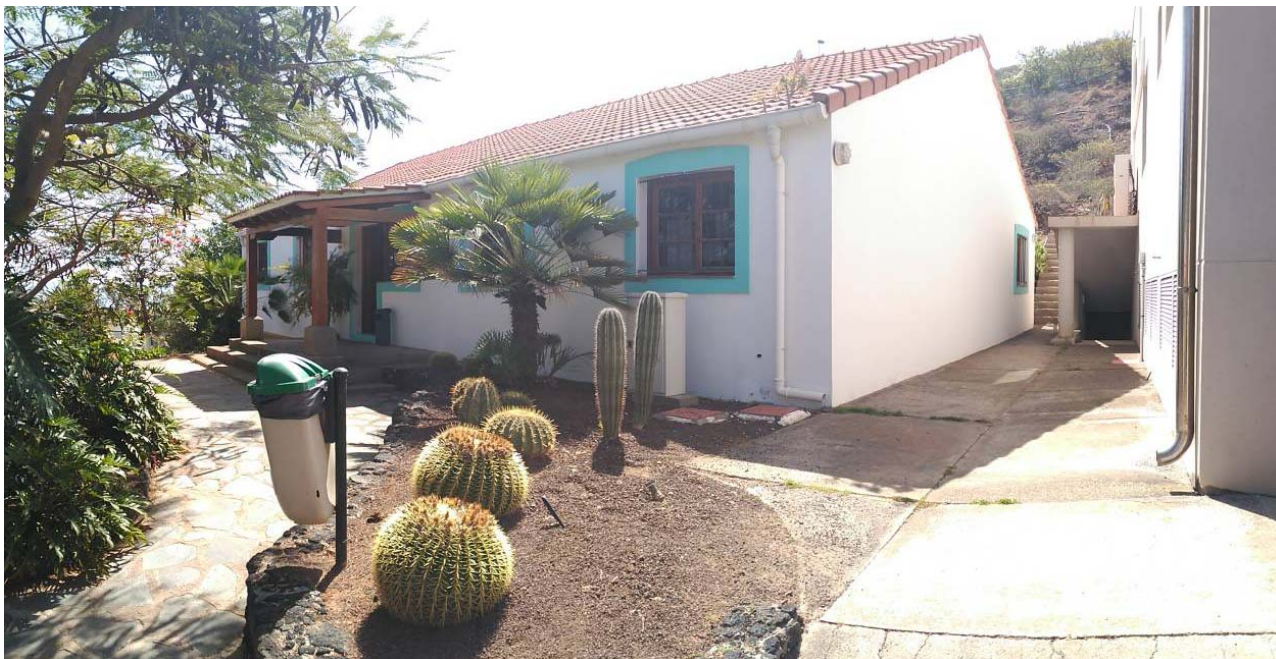
Vista general exterior Fachada
