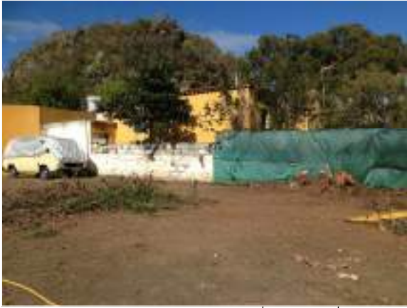
Fig 2. Muro de la vivienda del guarda, sustituir.
