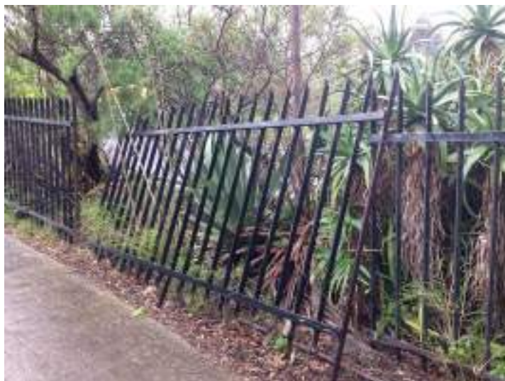
Ilustración 8. Situación actual vallado perimetral.
