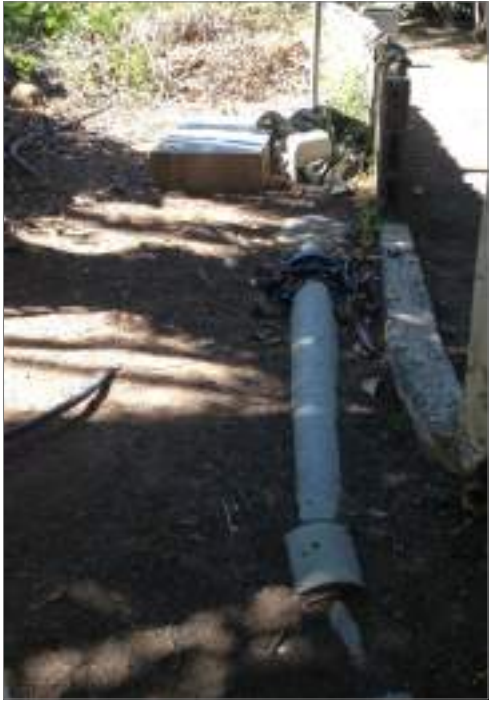
Fig 2. Canalización abasto de agua procedente del estanque "La Capellania" junto a la arqueta de contadores.
