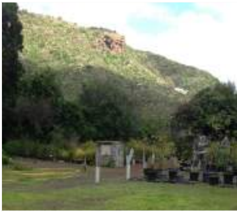
Fig 3. Cuadro eléctrico , cambio de ubicación.
