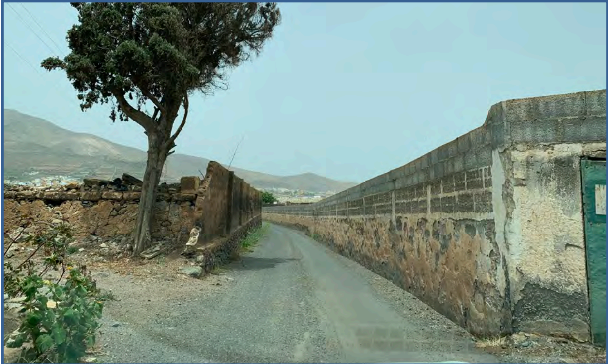
Estado Actual del Camino del Capellán. Fuente: Elaboración propia.
