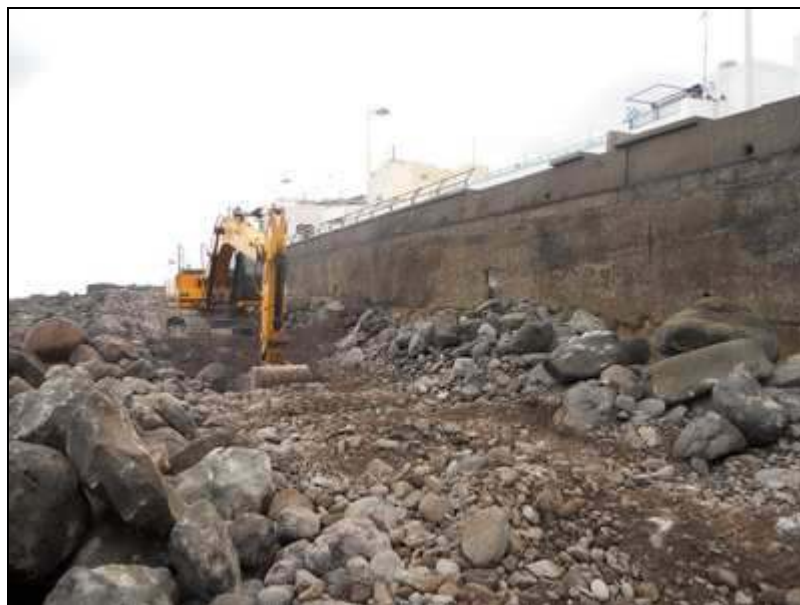
Figura 11. Imagen tomada durante la ejecución de la calicata 2
