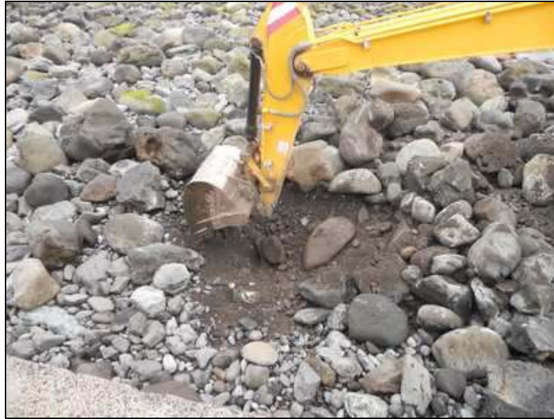
Figura 4. Imagen tomada durante la ejecución de la calicata 1
