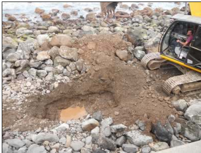
Figura 13. Imagen tomada durante la ejecución de la calicata 2
