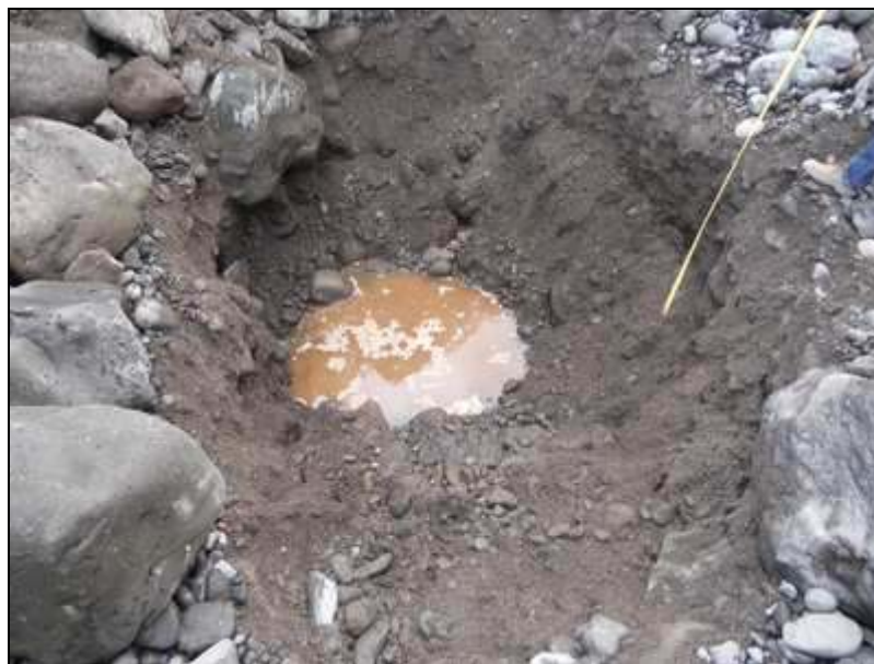
Figura 1. Imagen tomada durante la ejecución de la calicata 1
