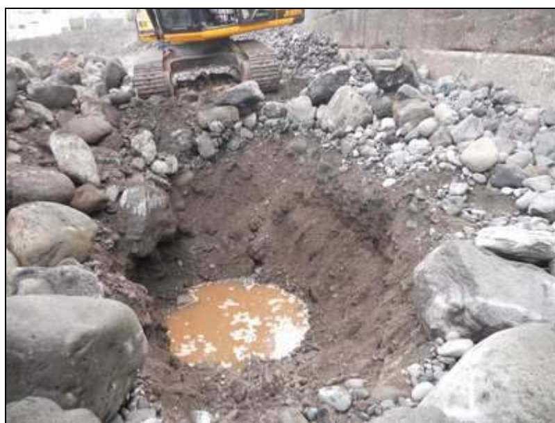
Figura 2. Imagen tomada durante la ejecución de la calicata 1
