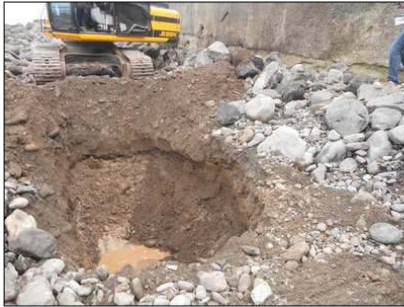
Figura 12. Imagen tomada durante la ejecución de la calicata 2
