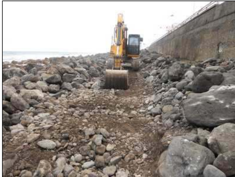
Figura 10. Imagen tomada durante la ejecución de la calicata 2
