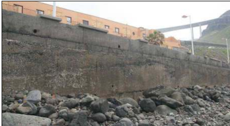
Figura 2.10. Imagen actual del paseo en uno de los tramos en los que el cimientto del muro ha quedado visible.
