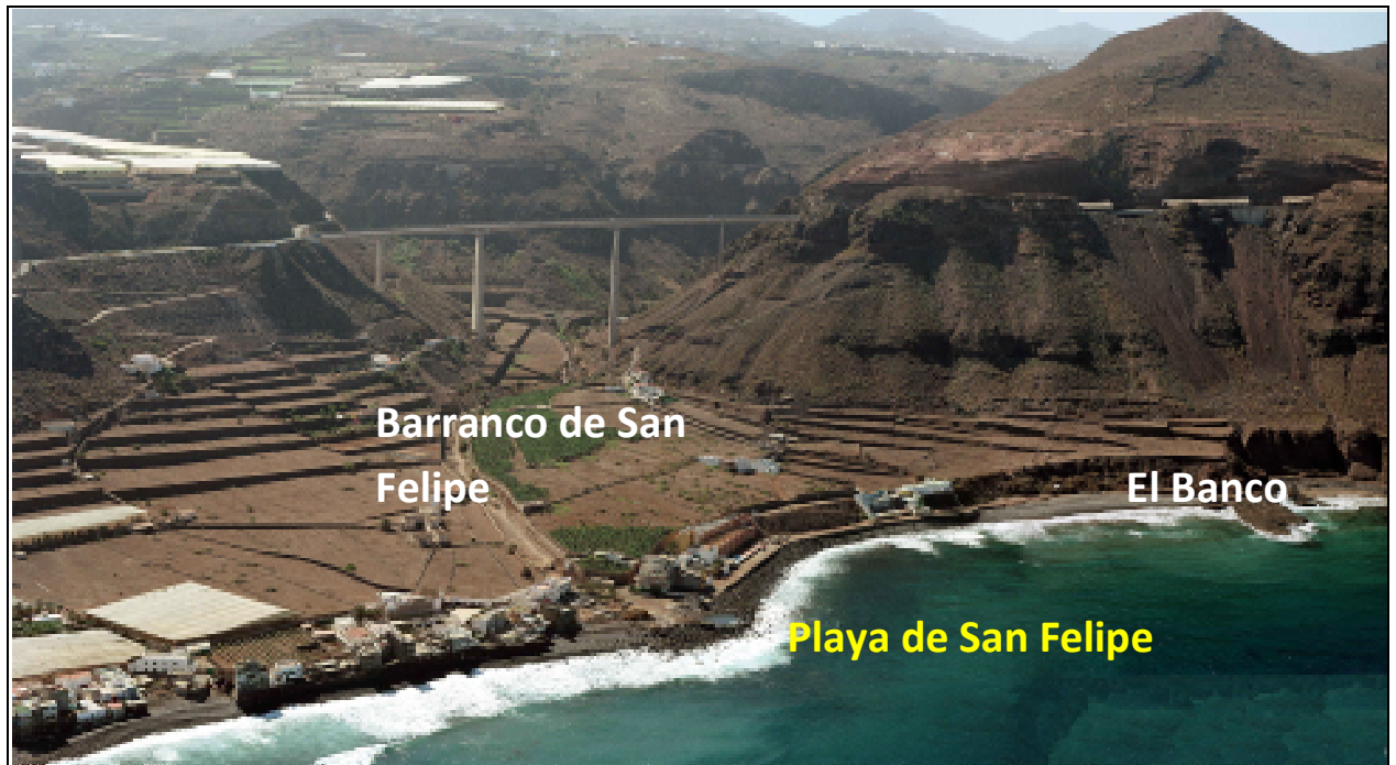
Figura 4. Fotografía aérea del área de intervención
