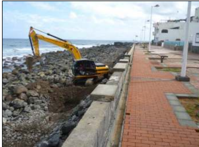
Figura 9. Imagen de la máquina retroexcavadora durante la campaña de realización de calicatas
