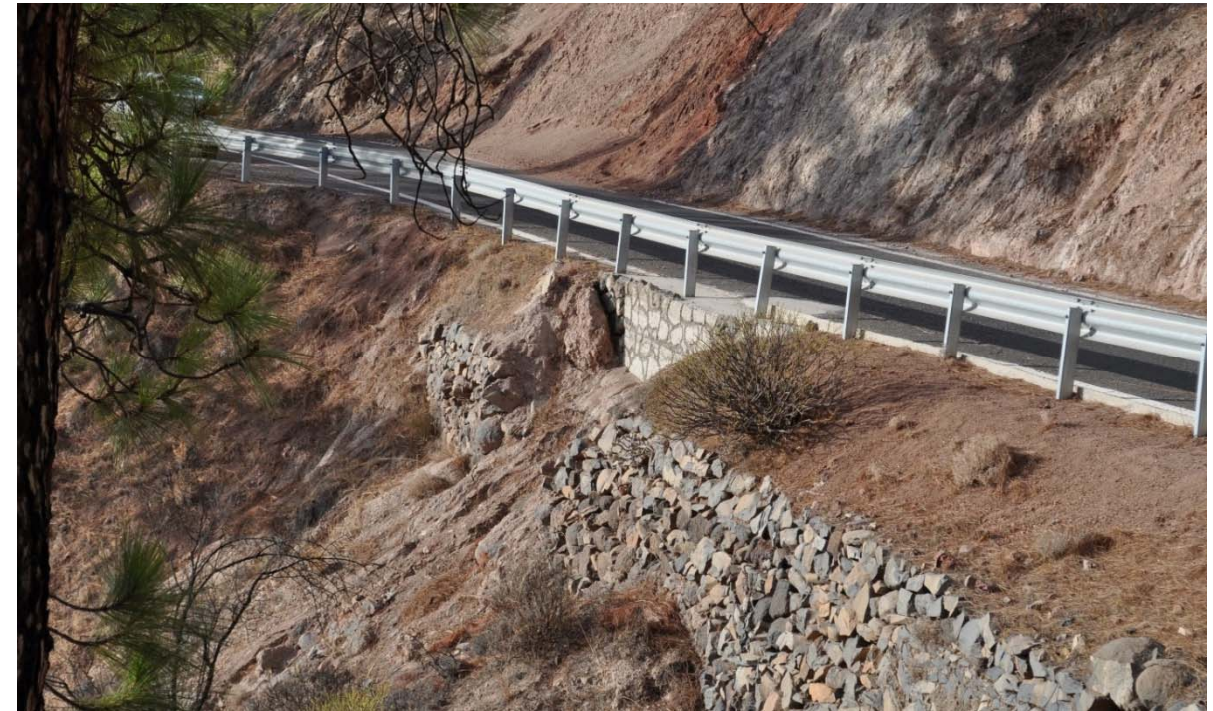
Ilustración 3: Muro existente restituido tras su derrumbe.
