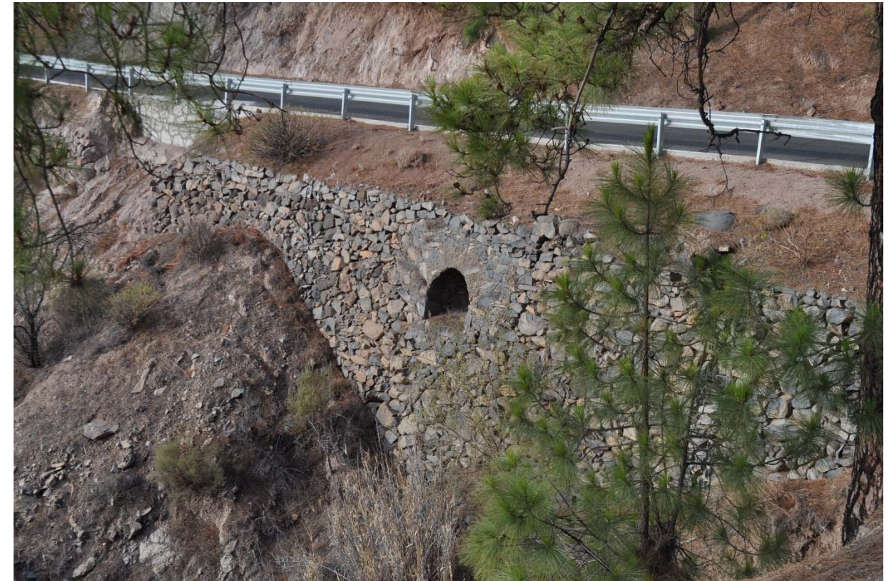
Ilustración 6: Obra de Drenaje Transversal ciega en Margen Izquierdo.
