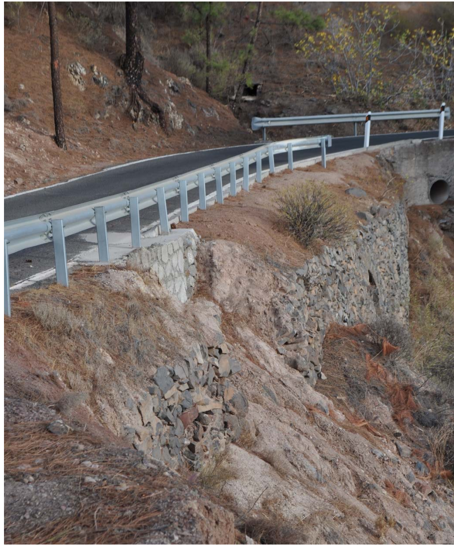
Ilustración 2: Bionda en margen izquierdo tras la curva y en margen derecho en la curva.
