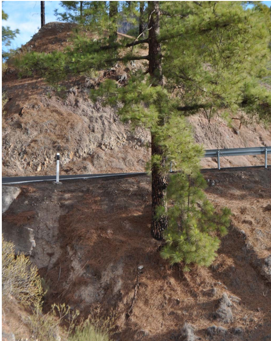
Ilustración 5. Pino existente en el interior de la curva.
