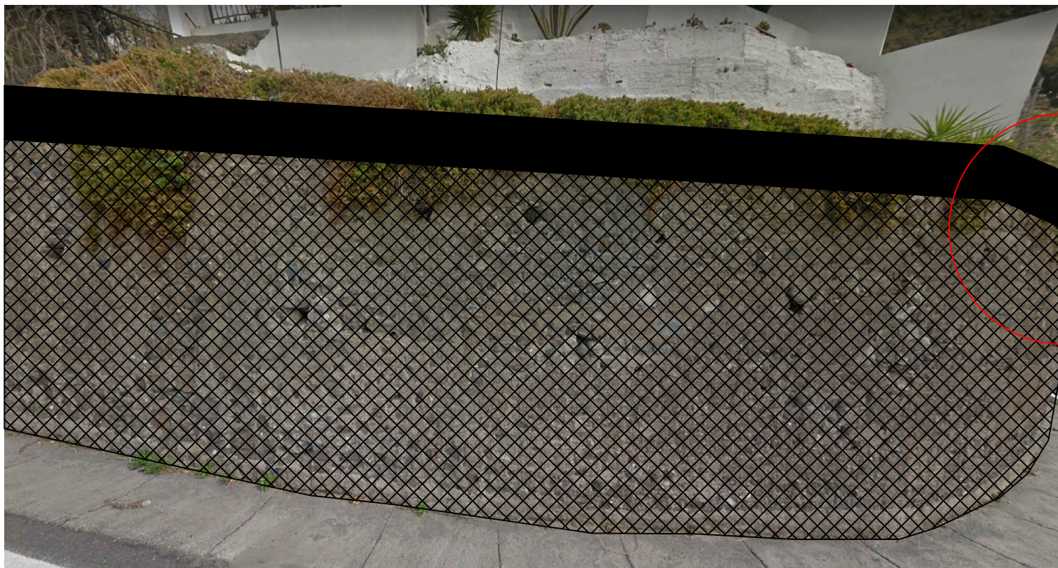
VISTA 2: SIMULACIÓN ESTADO FUTURO. MURO DE MAMPOSTERÍA DE NUEVA EJECUCIÓN Y REHABILITACIÓN DEL EXISTENTE
