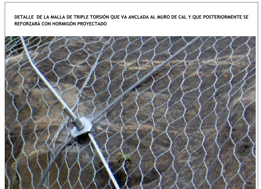
DETALLE DE LA MALLA DE TRIPLE TORSIÓN QUE VA ANCLADA A LA VIGA DE HORMIGÓN ARMADO DE 30X40cm Y QUE POSTERIORMENTE VA RECUBIERTA CON HORMIGÓN PROYECTADO PARA REFORZAR EL MURO DE CAL
