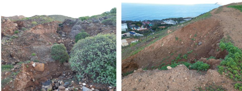
Figura 16. Cárcavas y roturas en rellenos provocados en episodios lluviosos.
