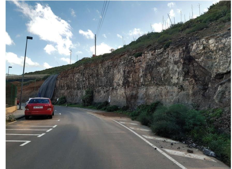
Figura 14. Malla de sostenimiento en mal estado y cantos invadiendo la calzada.
