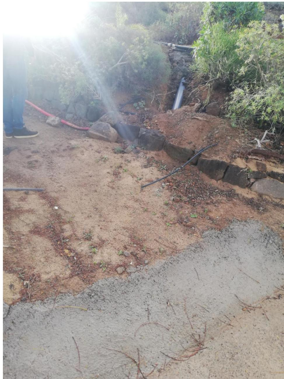
Ilustración 10a Saneamiento existente sin conexión, junto a las oficinas de la Granja Agrícola
