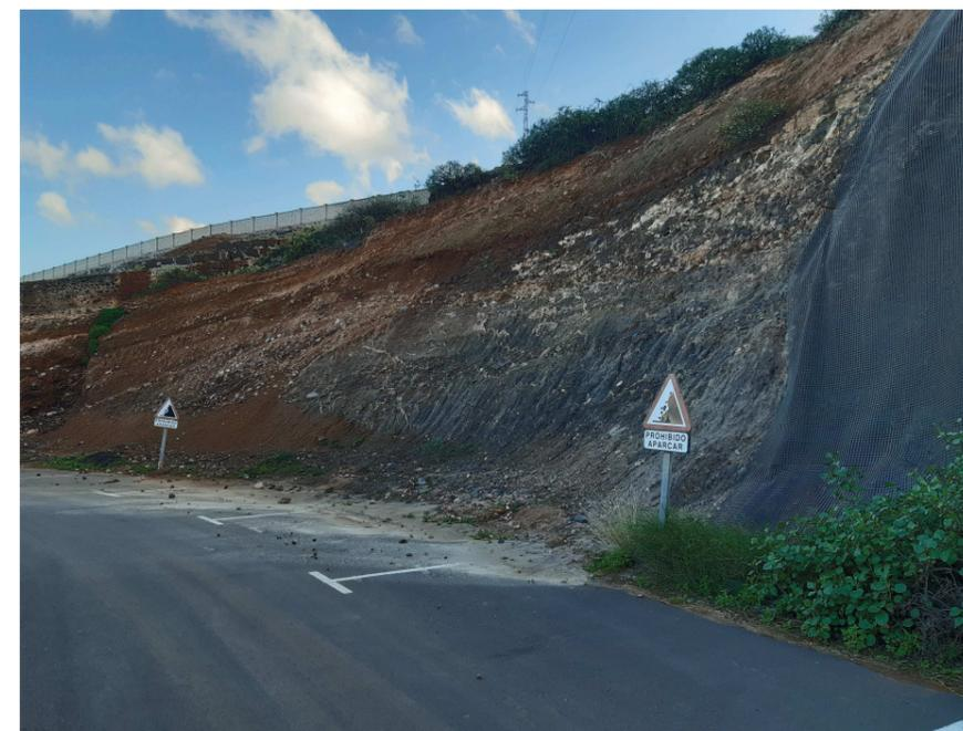
Figura 4. Vista general del talud de la curva de veterinaria. Se observe al pie las areniscas grises a la que se le superponen la colada tefrítica. Por encima se depositan los materiales del coluvión.
