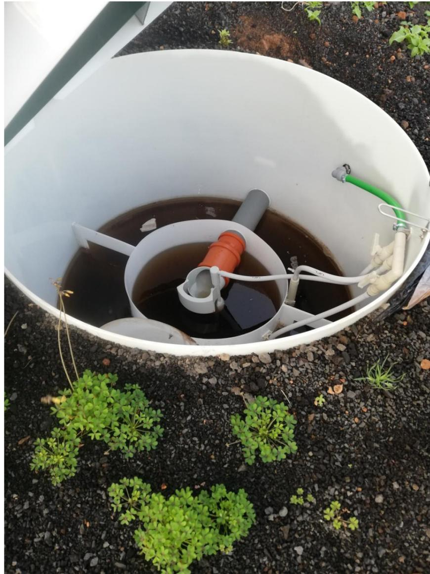
Ilustración 7.- Saneamiento existente a la salida de la Escuela, sin conexión actual a la red de saneamiento.
