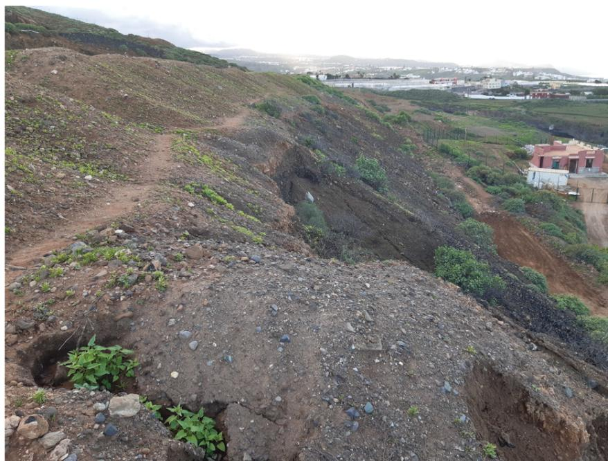
Figura 10. Rellenos y derrames con erosión a modo de cárcavas.
