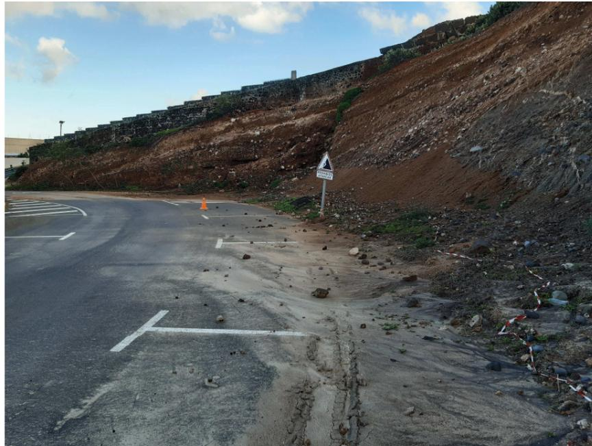
Figura 13. La señal de tráfico apunta a la zona en el que se produjo la rotura del talud. Al fondo se ve el muro que limita el parking de veterinaria. En primer plano, la sedimentación que entierra a la cuneta existente.
