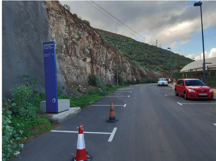
Figura 5. Colada tefrítica con malla de sostenimiento en mal estado.
