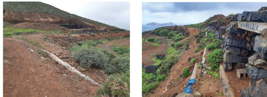
Figura 11. Acequias que surgen de la balsa. Se puede observar la tubería en servicio paralela a la acequia en desuso. Se aprecia la colada con disyunción esferoidal, sobre la que se depositan los materiales finos del coluvión. Por encima de la tubería se aprecia un muro de mampostería que sujeta rellenos al pie del cono de piroclastos, en último plano.
