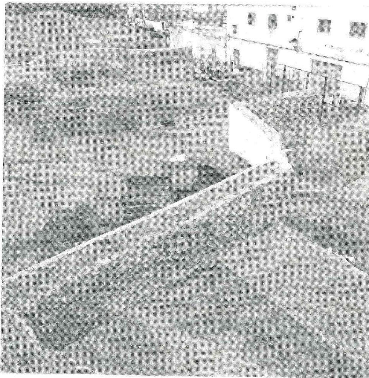
Detalle de los muros hormigonados y cortes de excavación.
