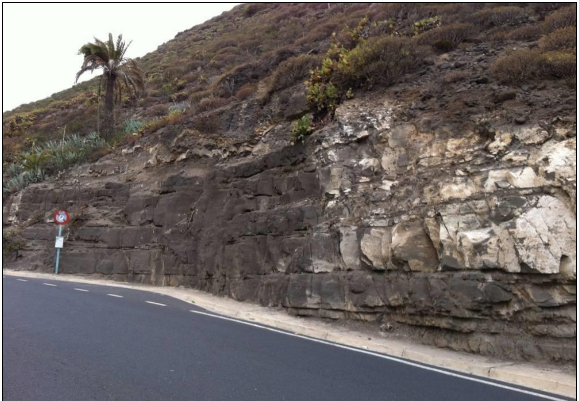
Imagen 13: Vista general del tramo 6, PK 0+510 a 0+540.
