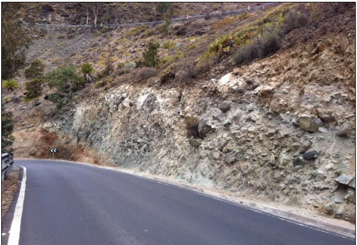
Imagen 26: Vista general del tramo 11, PK 1+235 a 1+360.
