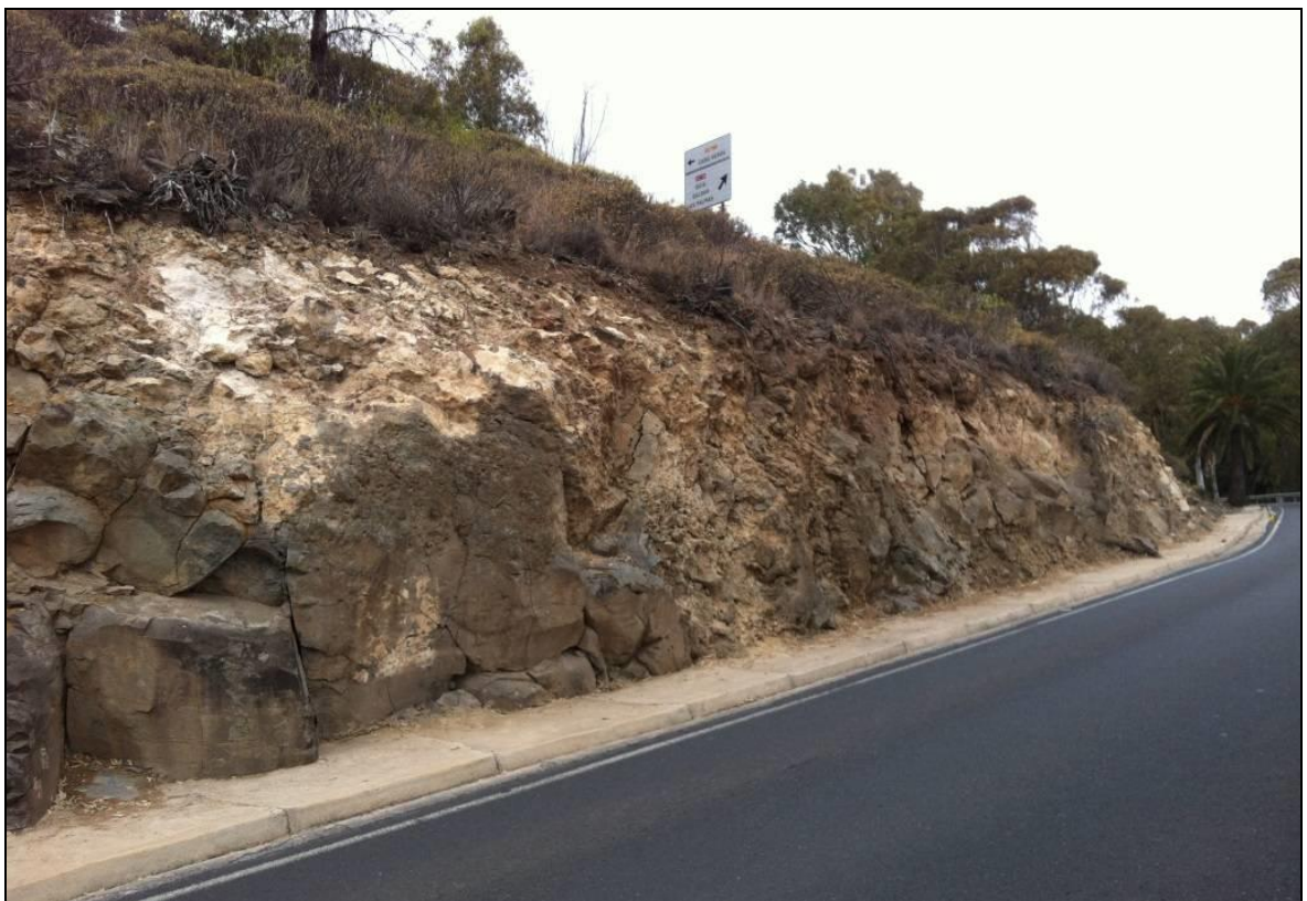
Imagen 30: Detalle del tramo 12, PK 1+555 a 1+610.
