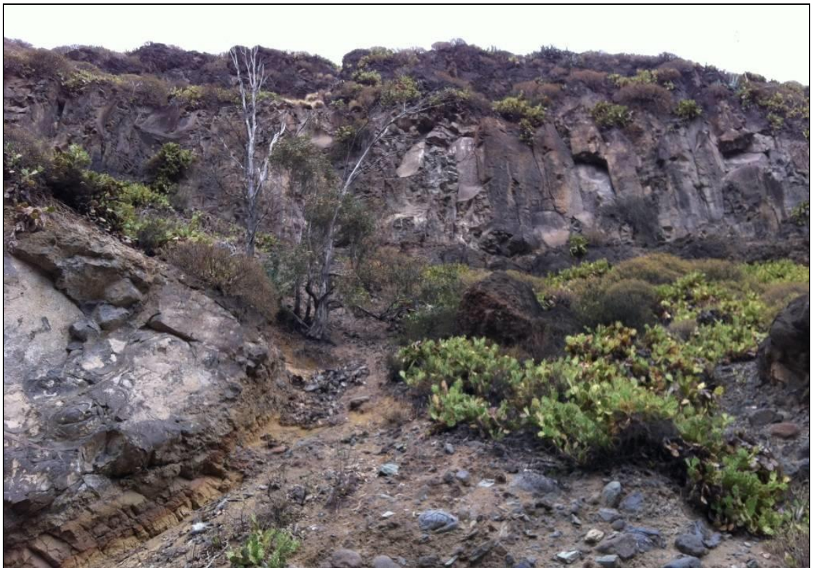
Imagen 20: Detalle de la coronación de la parte final del tramo 7, PK 0+545 a 0+750.
