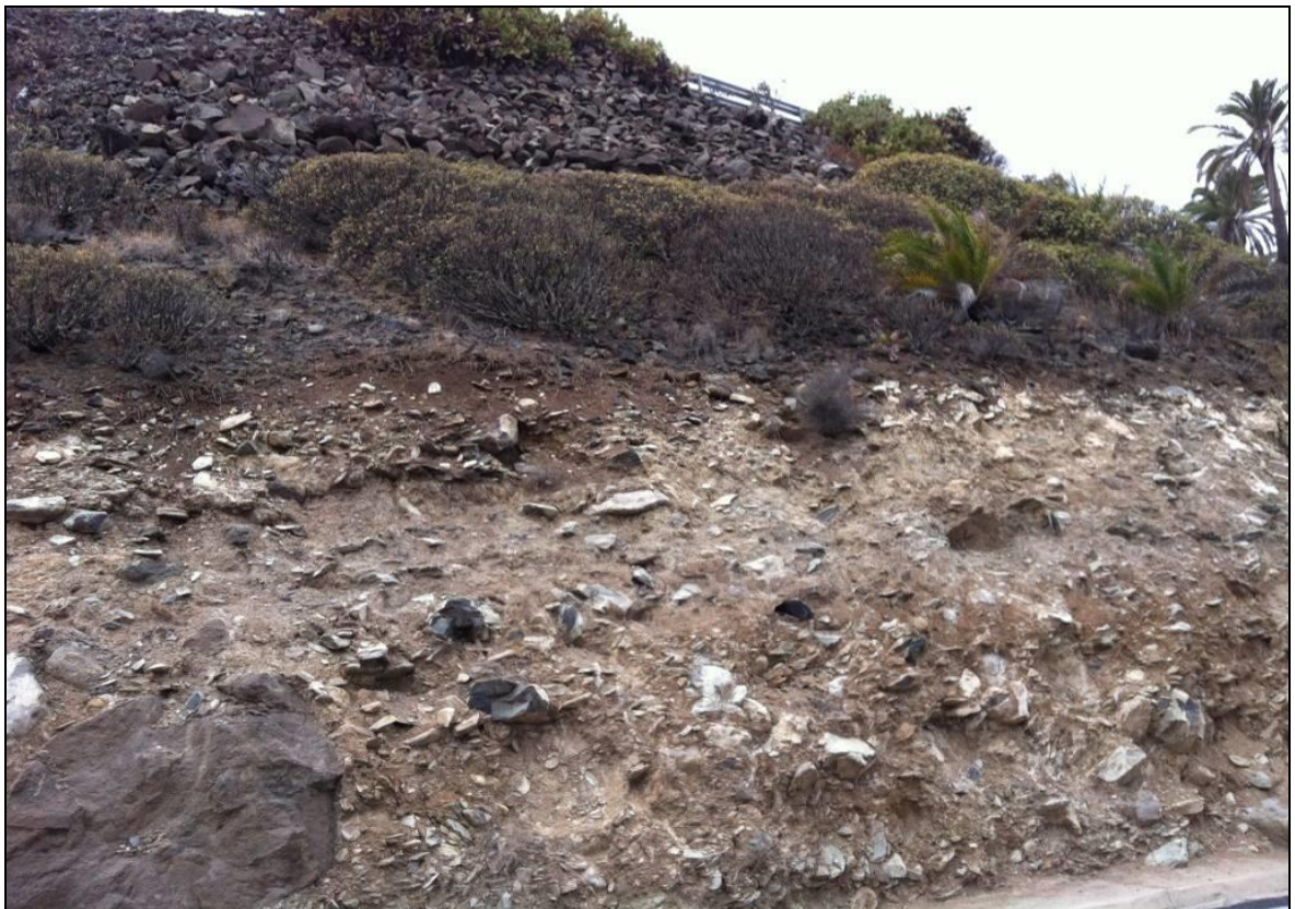
Imagen 24: Detalle del tramo 10, PK 1+050 a 1+155.
