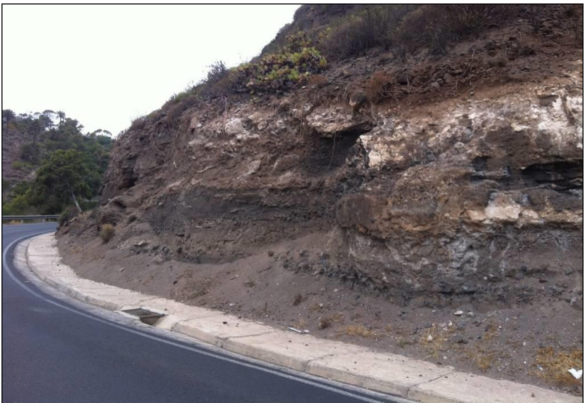
Imagen 18: Detalle del tramo 7, PK 0+545 a 0+750.
