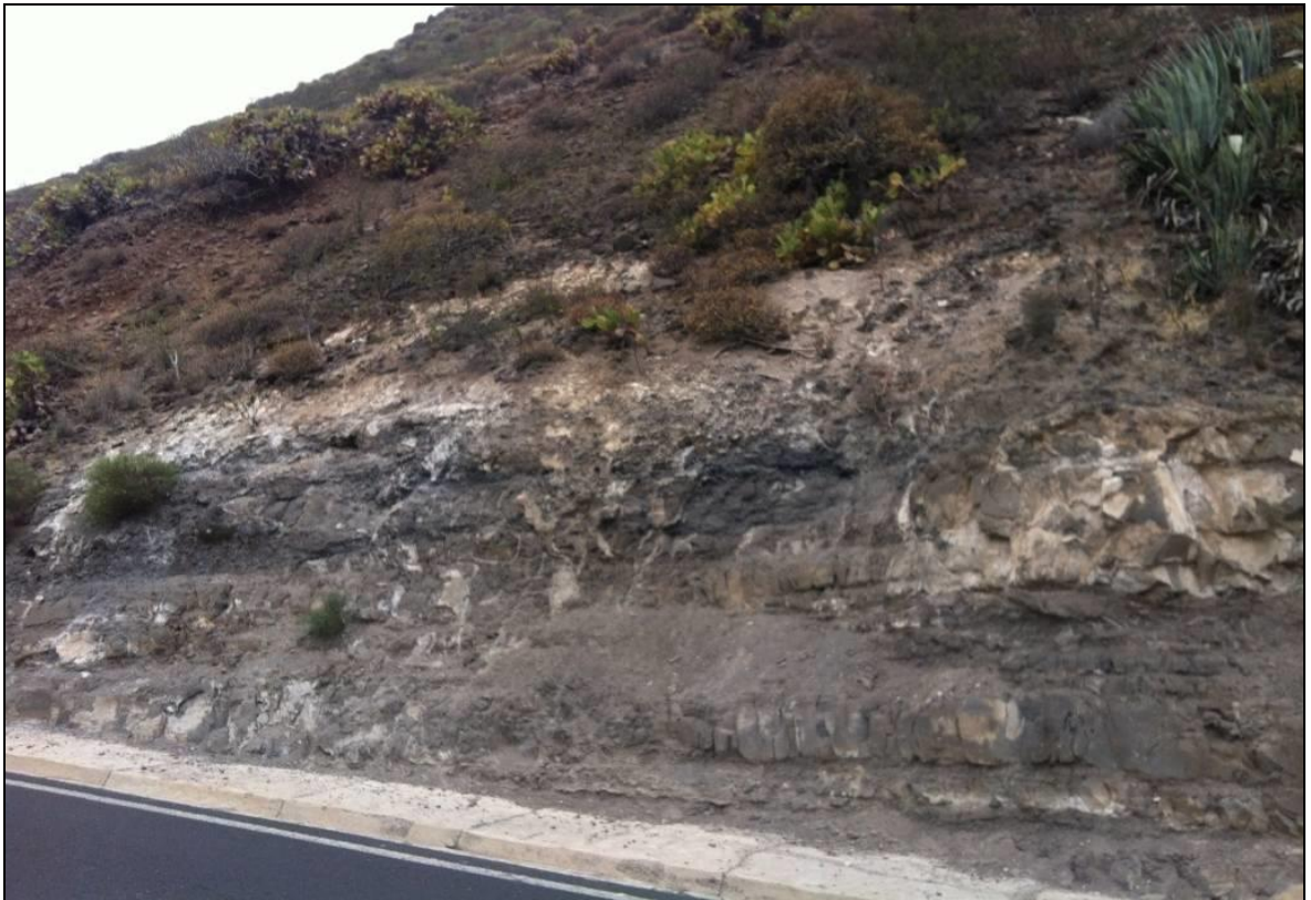
Imagen 15: Detalle del tramo 7, PK 0+545 a 0+750.
