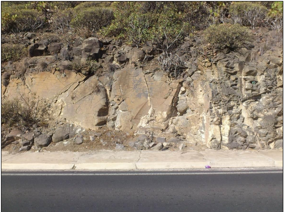
Imagen 13: Muestra en color blanco de material carbonatado precipitado en las fisuras.
