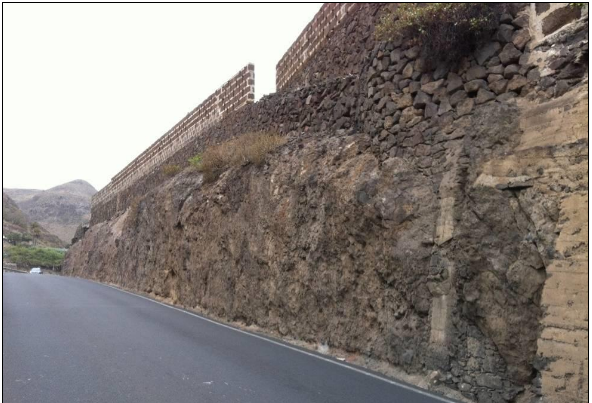
Imagen 1: Vista general del tramo 1, PK 0+090 a 0+170.
