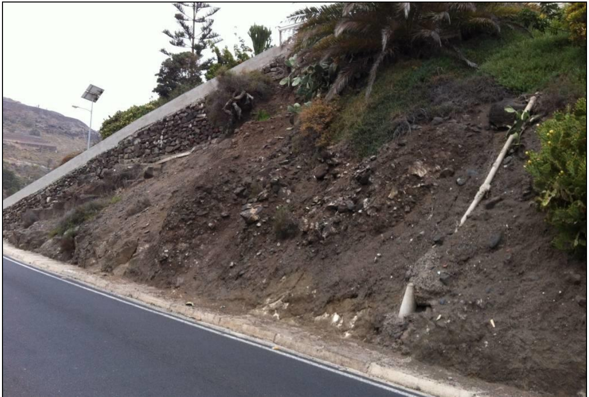
Imagen 5: Vista general del tramo 3, PK 0+330 a 0+350.
