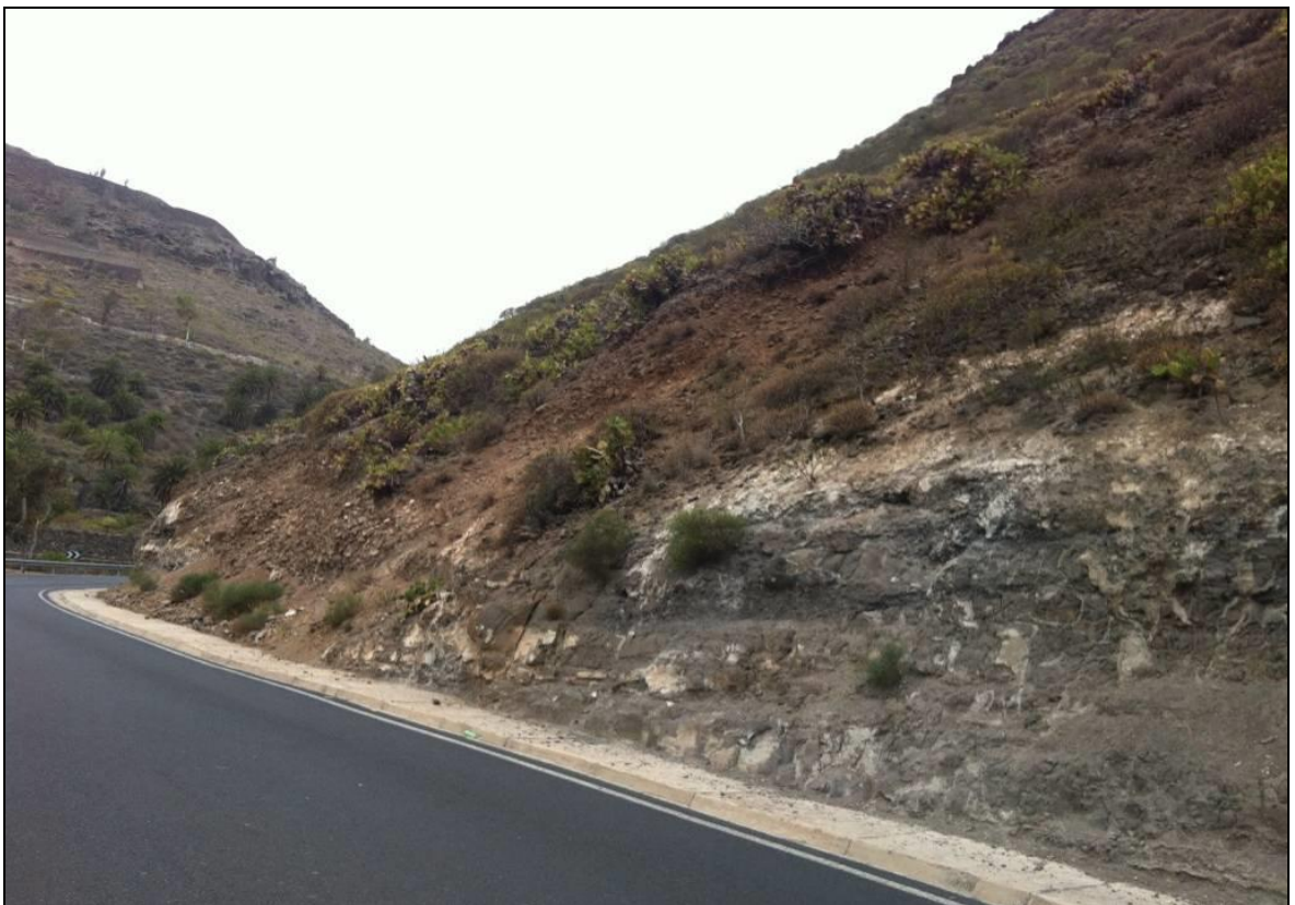
Imagen 16: Detalle del tramo 7, PK 0+545 a 0+750.
