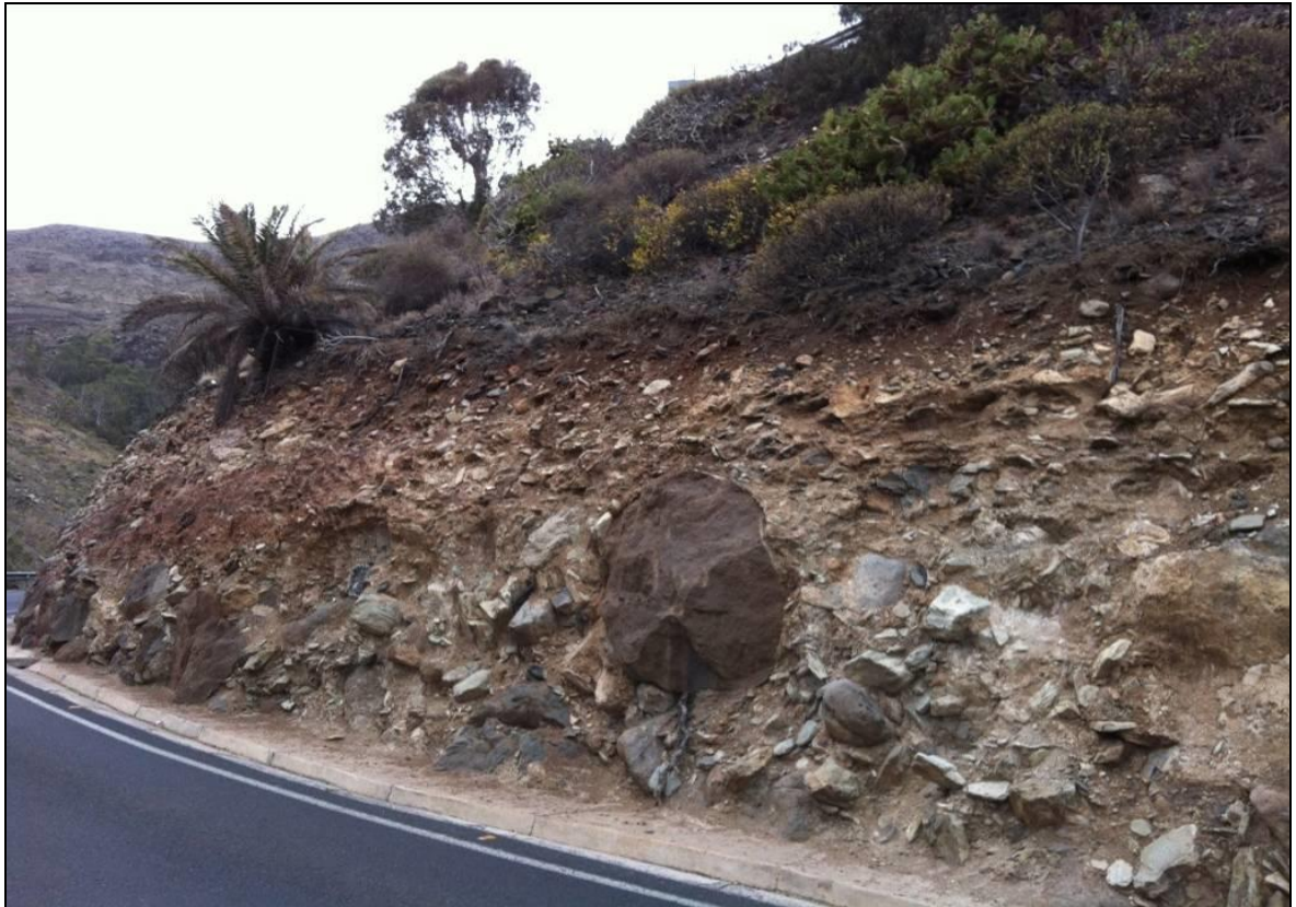
Imagen 25: Vista general del tramo 11, PK 1+235 a 1+360.
