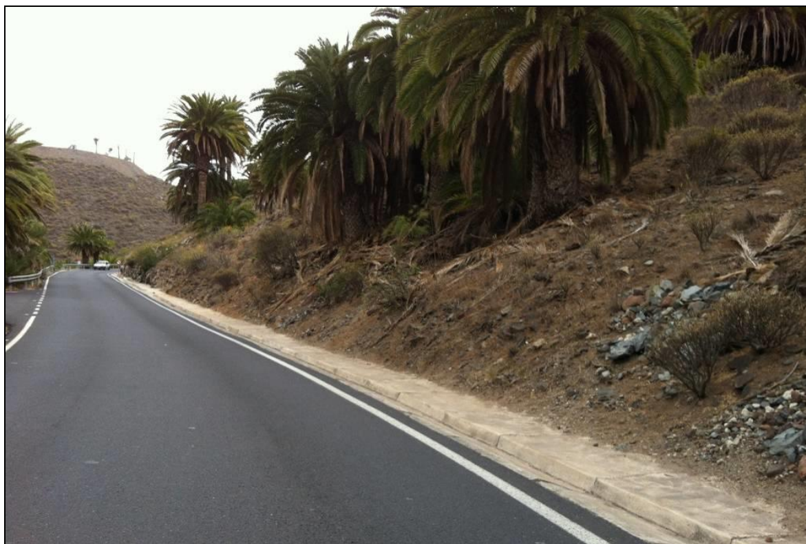
Imagen 22: Vista general del tramo 9, PK 0+880 a 0+940.
