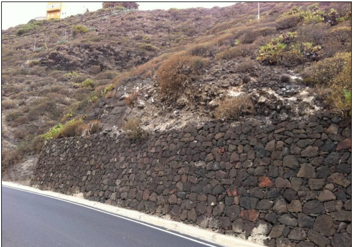
Imagen 12: Detalle del tramo 5, PK 0+460 a 0+490.
