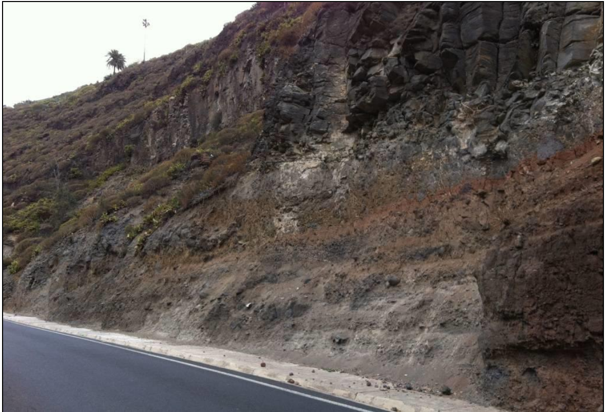
Imagen 19: Vista general del tramo 7, PK 0+545 a 0+750.
