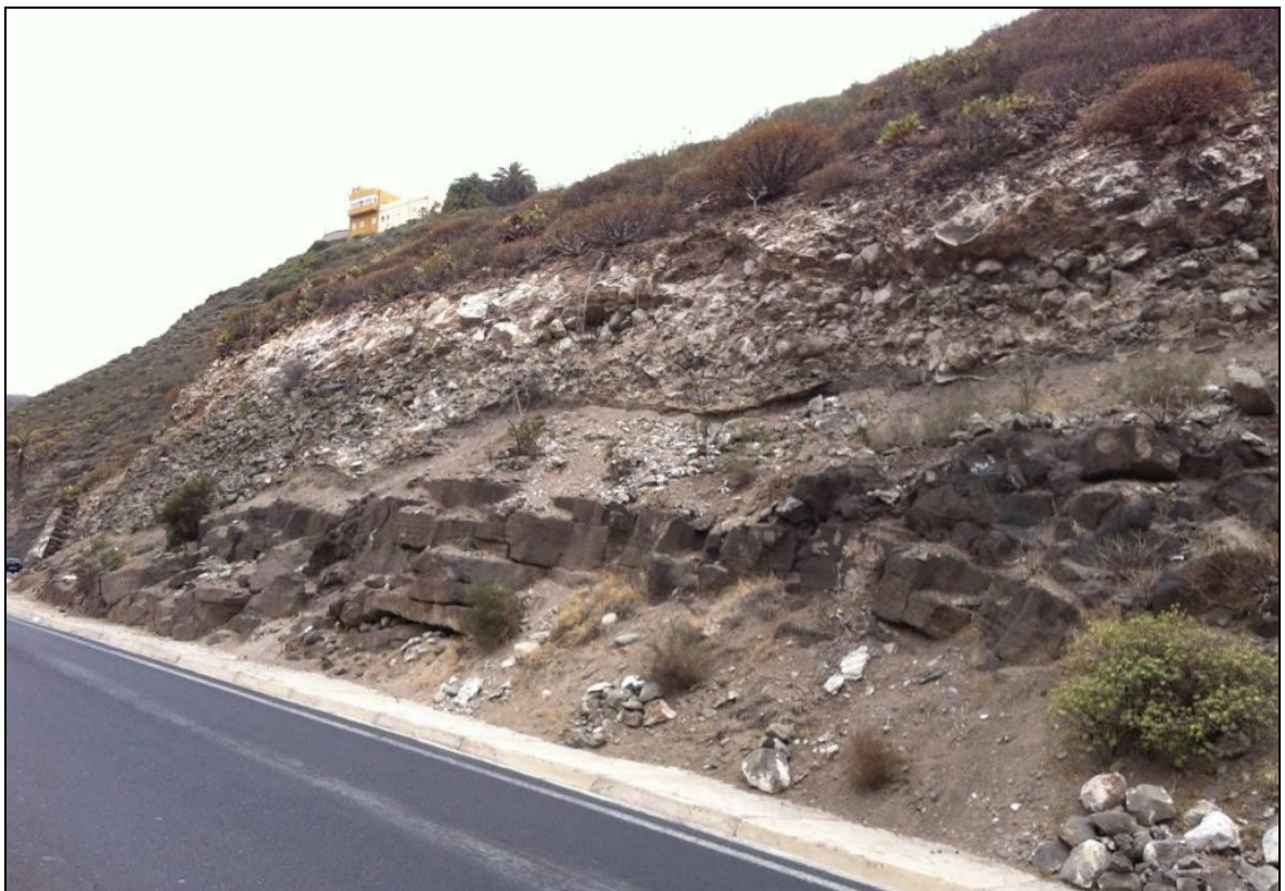
Imagen 8: Detalle del tramo 4, PK 0+385 a 0+460.
