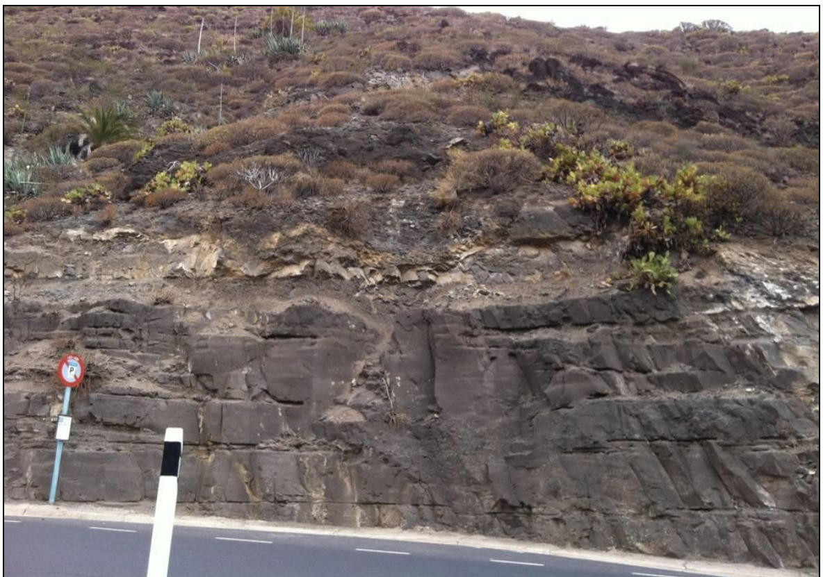
Imagen 14: Detalle del tramo 6, PK 0+510 a 0+540.
