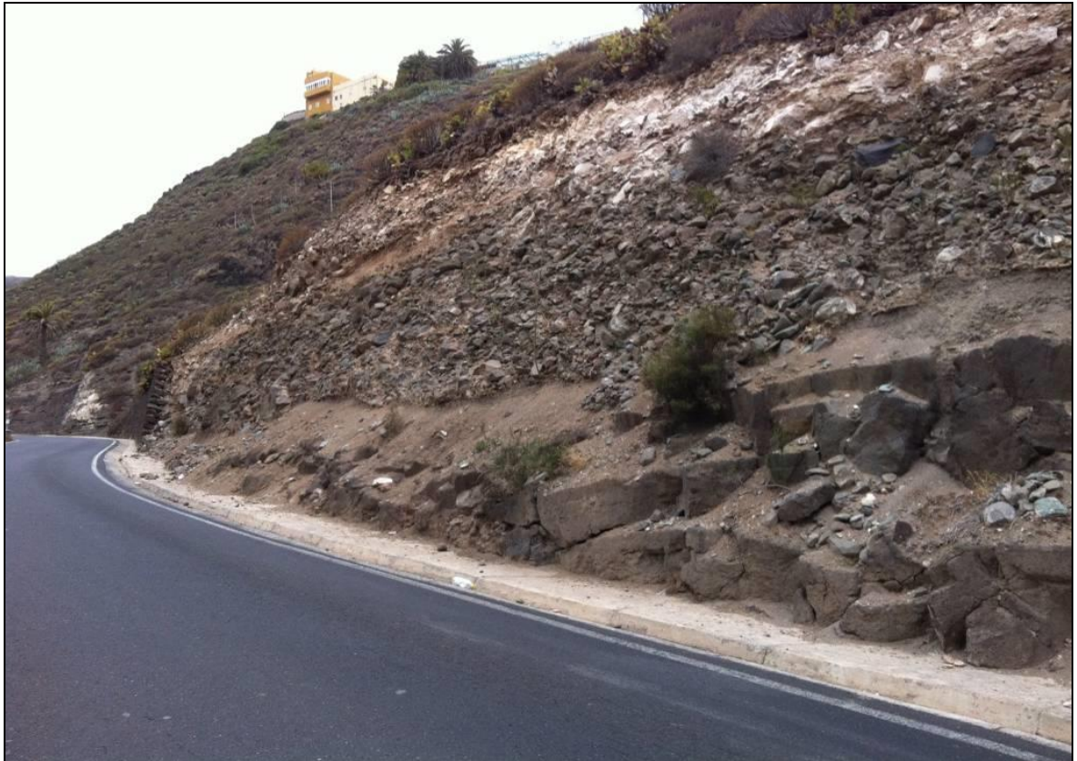
Imagen 9: Detalle del tramo 4, PK 0+385 a 0+460.
