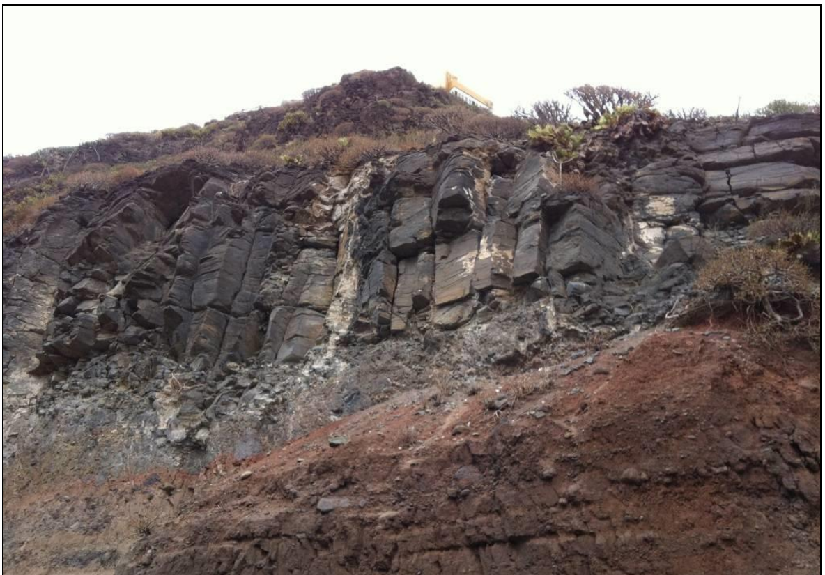
Imagen 20: Detalle de la coronación de la parte inicial del tramo 7, PK 0+545 a 0+750.
