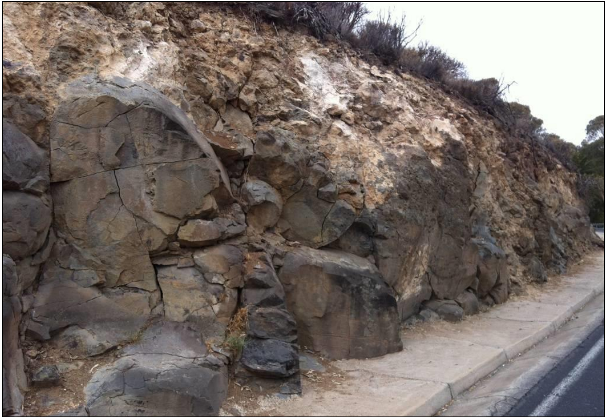
Imagen 29: Vista general del tramo 12, PK 1+555 a 1+610.
