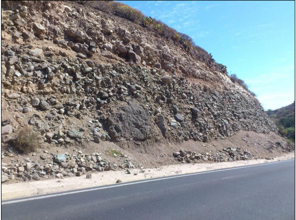
Imagen 16: Muestra en la base del talud de los numerosos desprendimientos.
