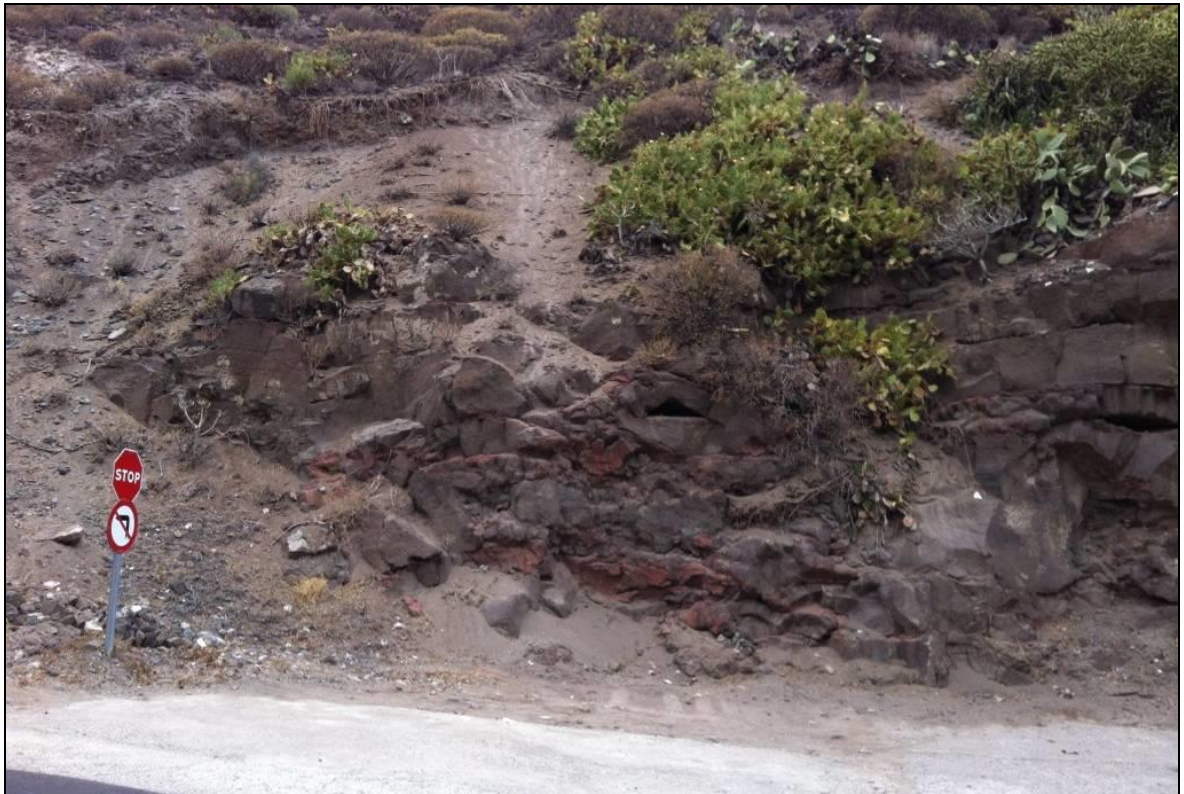
Imagen 7: Detalle del tramo 4, PK 0+385 a 0+460.
