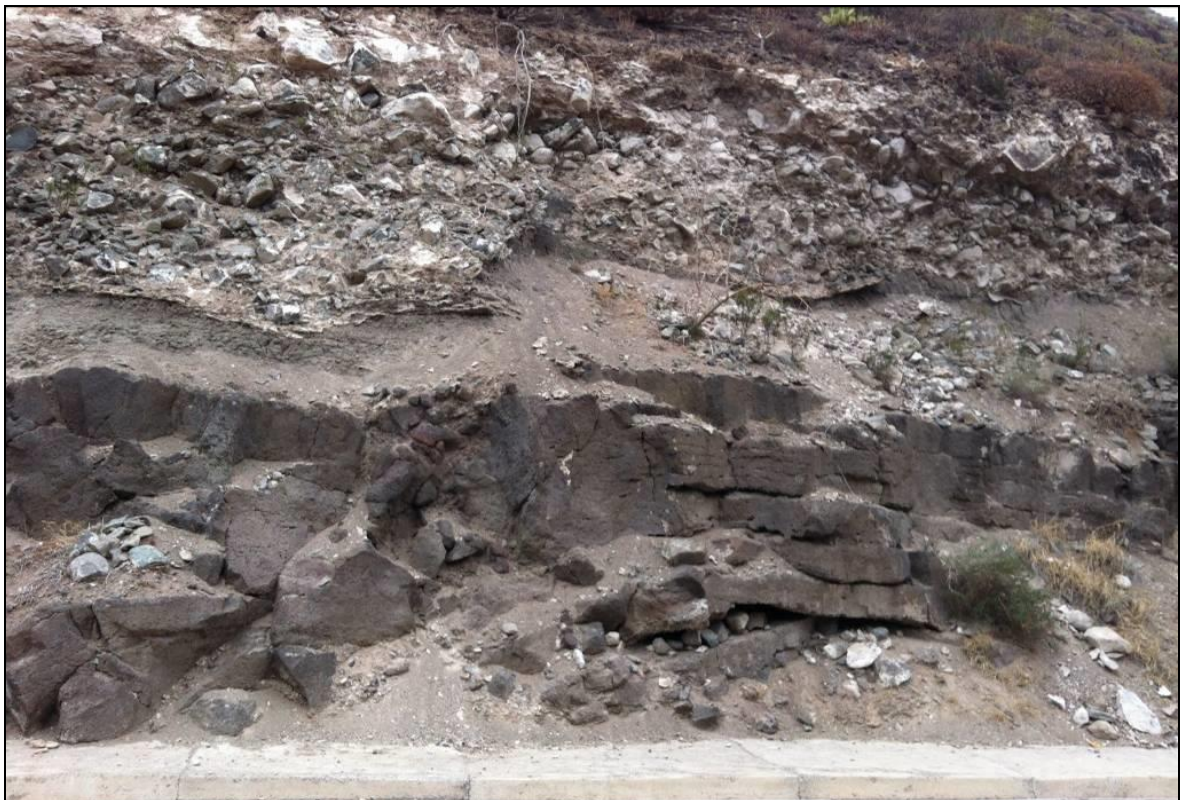
Imagen 10: Detalle del tramo 4, PK 0+385 a 0+460.
