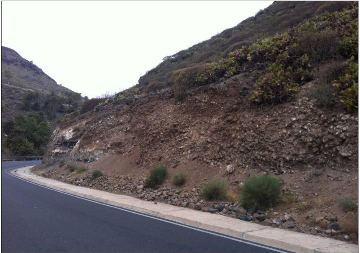
Imagen 17: Detalle del tramo 7, PK 0+545 a 0+750.
