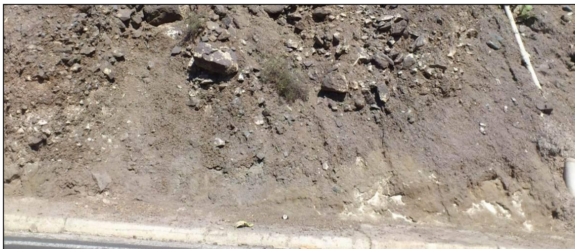
Imagen 11: Coluviones y derrubios de ladera.
