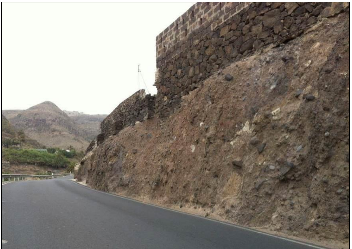
Imagen 2: Detalle de la parte final del tramo 1, PK 0+090 a 0+170.
