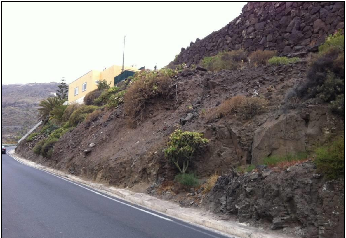
Imagen 4: Vista general del tramo 2, PK 0+230 a 0+305.
