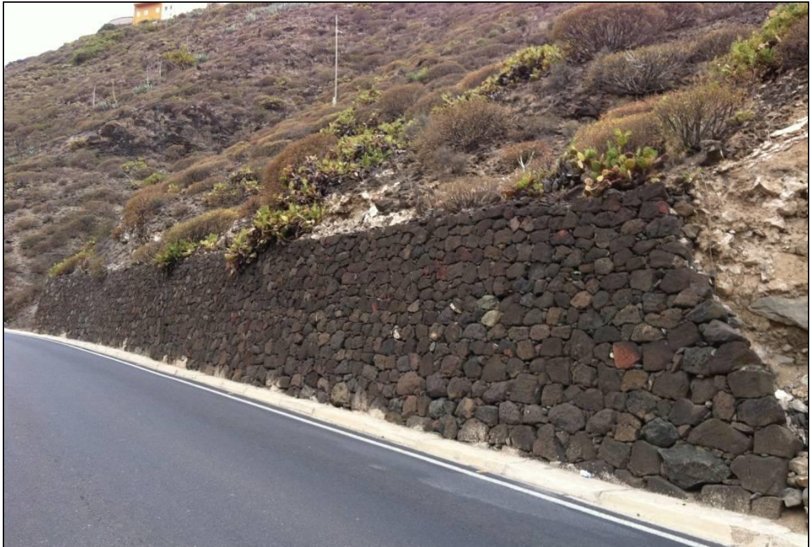
Imagen 11: Vista general del tramo 5, PK 0+460 a 0+490.
