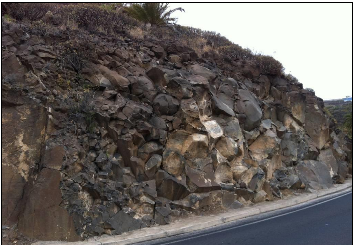
Imagen 28: Detalle del tramo 11, PK 1+235 a 1+360.
