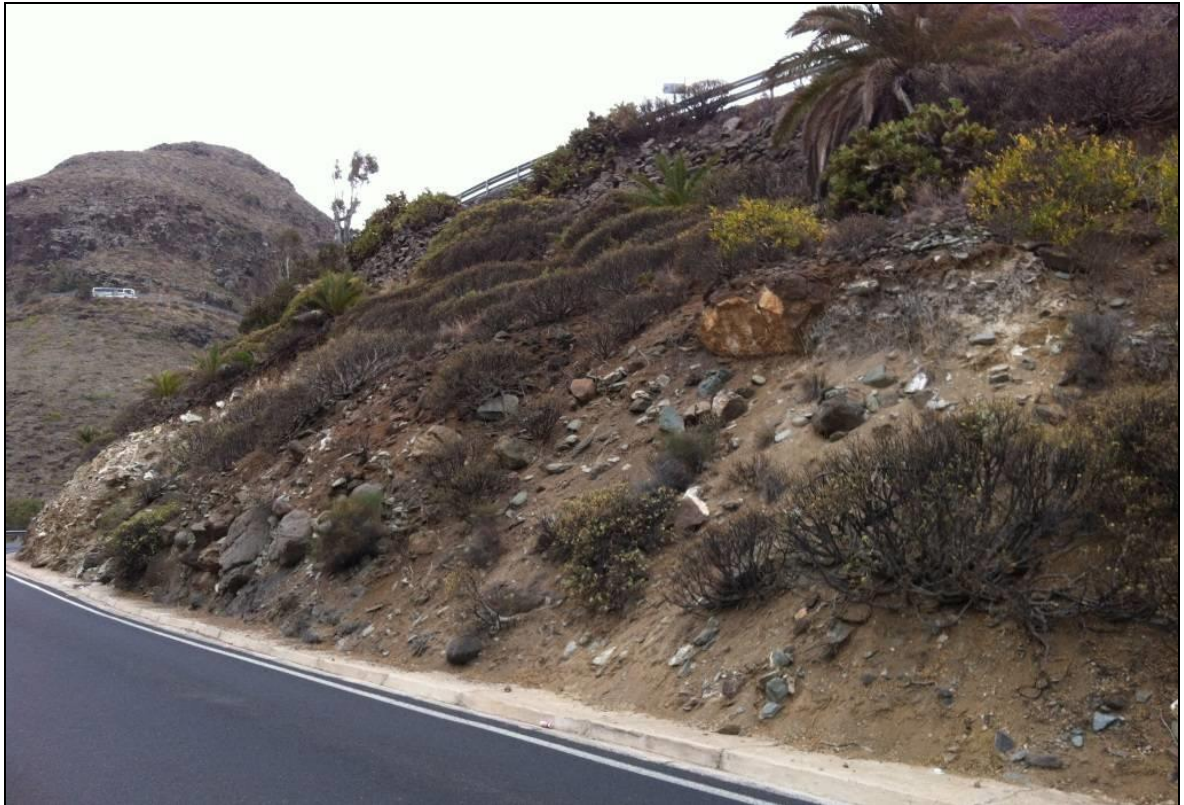
Imagen 23: Vista general del tramo 10, PK 1+050 a 1+155.
