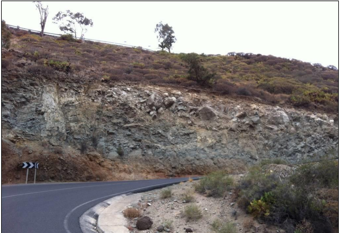
Imagen 27: Detalle del tramo 11, PK 1+235 a 1+360.
