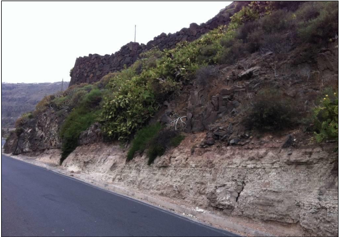
Imagen 3: Vista general del tramo 2, PK 0+230 a 0+305.
