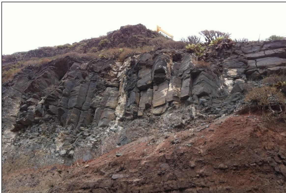
Imagen 12: Materiales susceptibles de desprendimiento.
