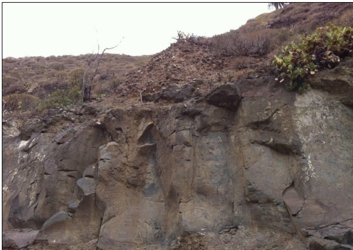
Imagen 21: Vista general del tramo 8, PK 0+785 a 0+790.
