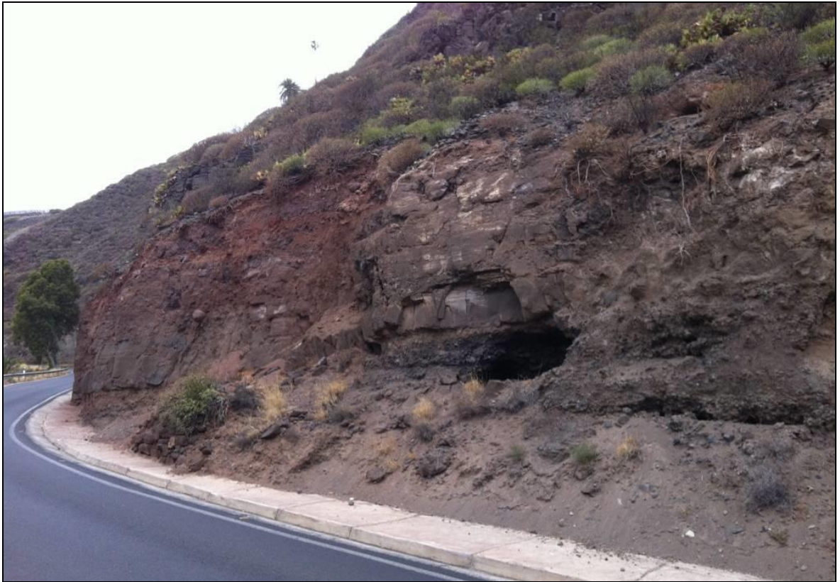
Imagen 19: Detalle cueva existente en el tramo 7, PK 0+545 a 0+750.
