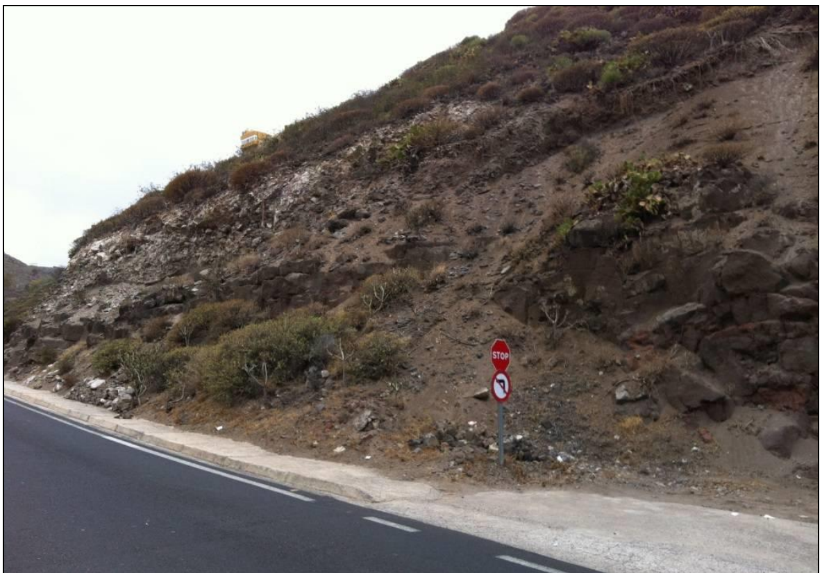
Imagen 6: Vista general del tramo 4, PK 0+385 a 0+460.
