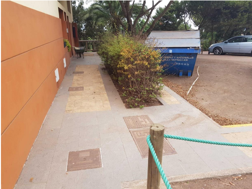
Imagen 11.- Pavimentación peatonal en la fachada del edificio del antiguo CECOPIN
