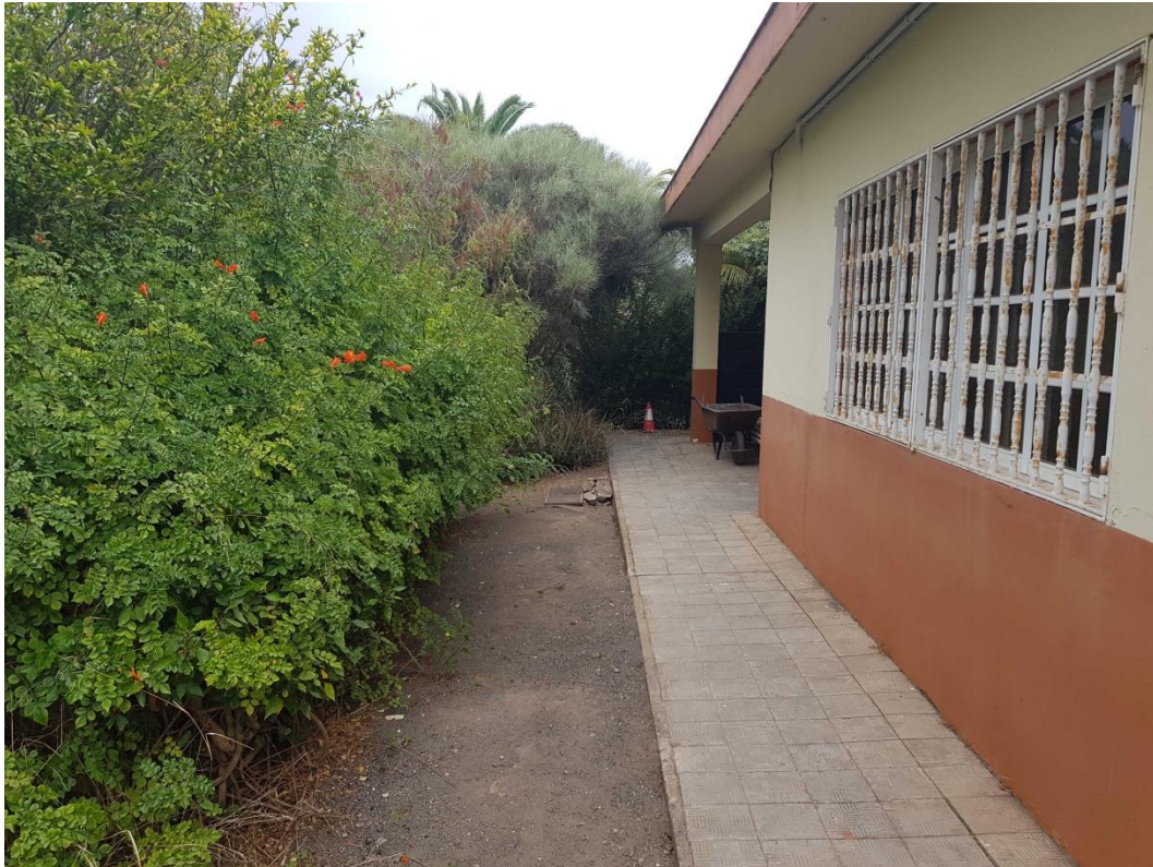
Imagen 21.- Vista estado actual pavimentación edificio norte
