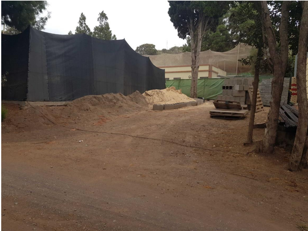
Imagen 7.- Vista acopio de materiales en los laterales de la vía
