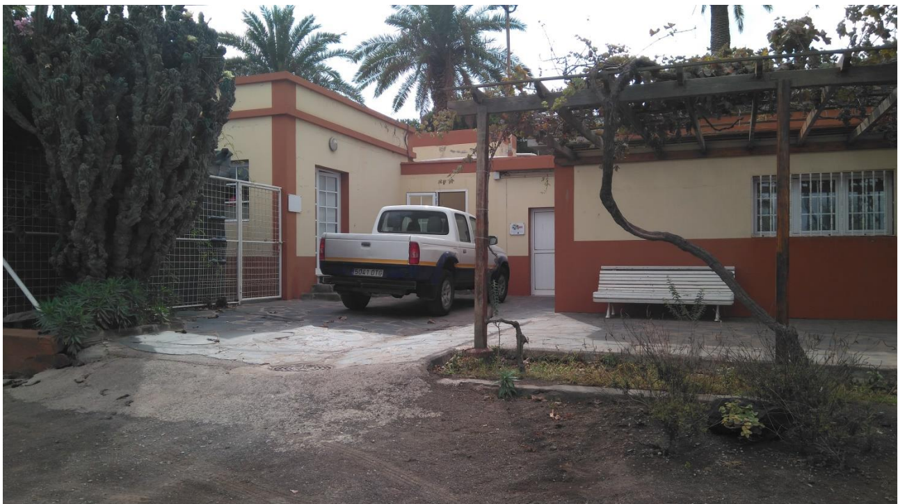
Imagen 14.-Vista acceso descarga edificios principales
