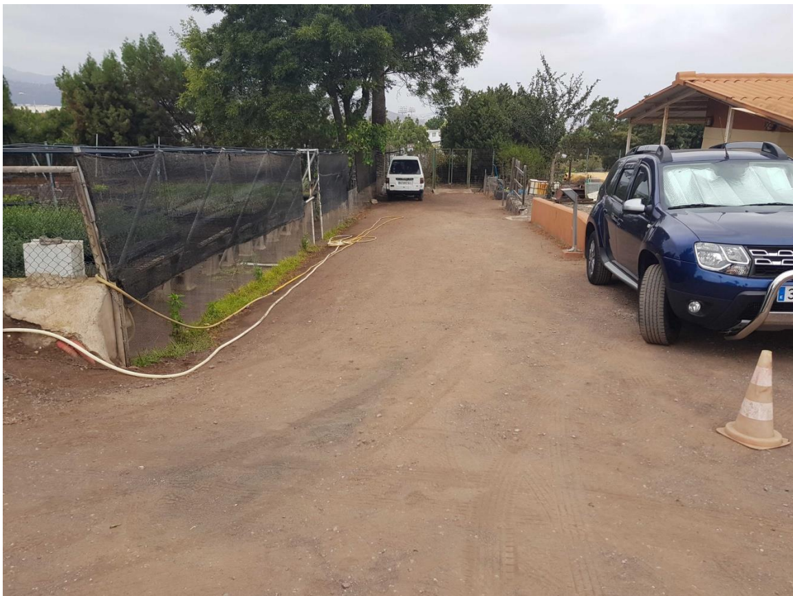
Imagen 18.- Vista acceso lateral peatonal
