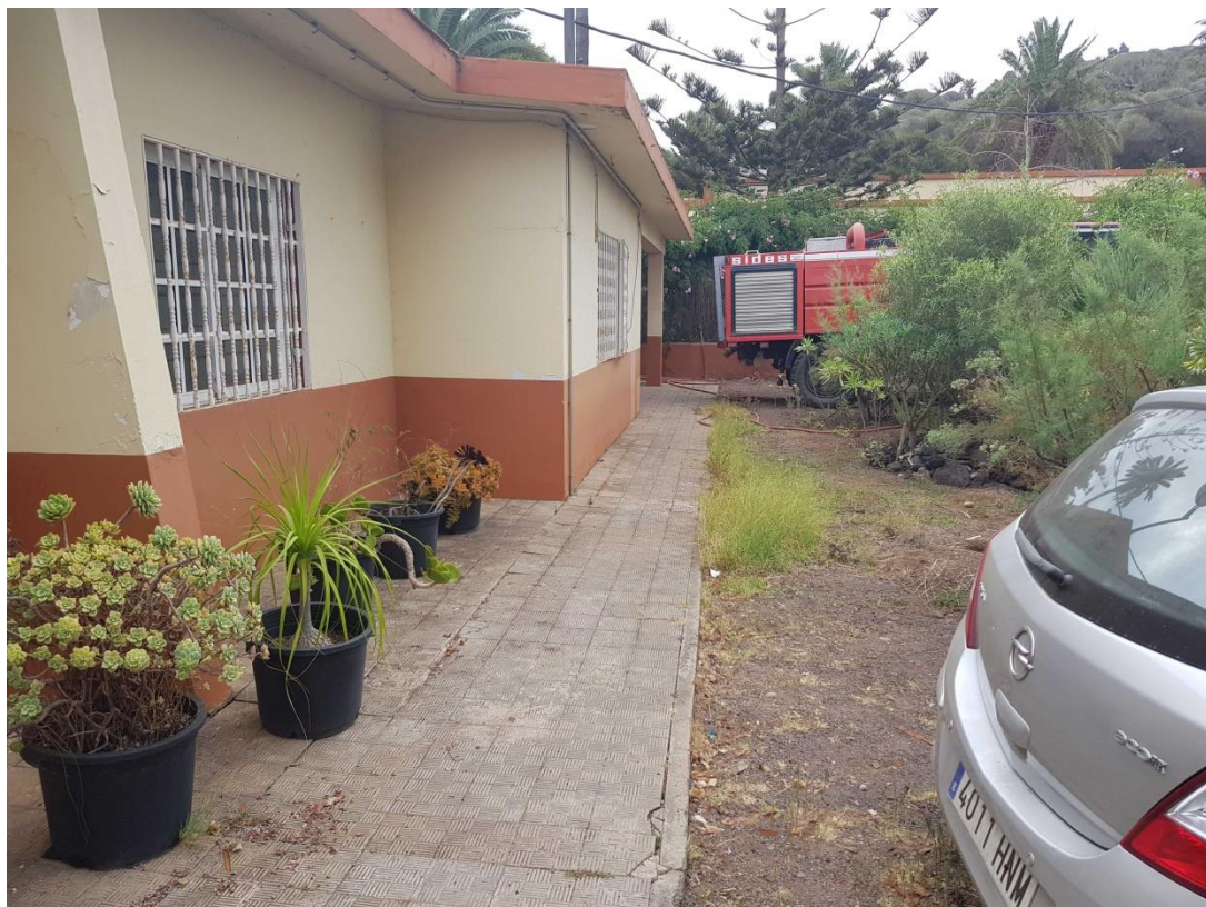
Imagen 20.- Vista estado actual pavimentación edificio norte
