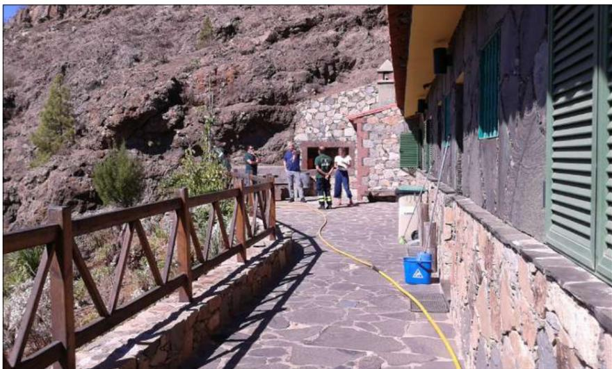
FOTO 2. Perspectiva desde la entrada a la terraza en la que se aprecia el tramo de barandilla a desmontar, el murete en el que se apoyarán 3 de los pilares de la marquesina, la cara inferior del vuelo del forjado y las luminarias de exterior que habrá que desmontar y recolocar.
