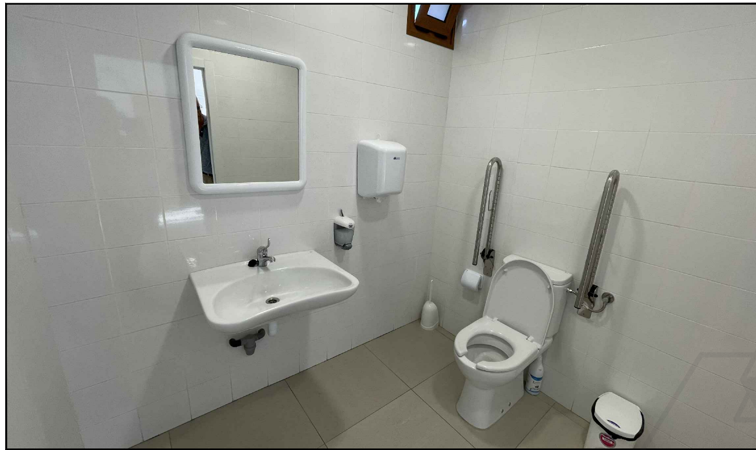
FOTO ESTADO ACTUAL
