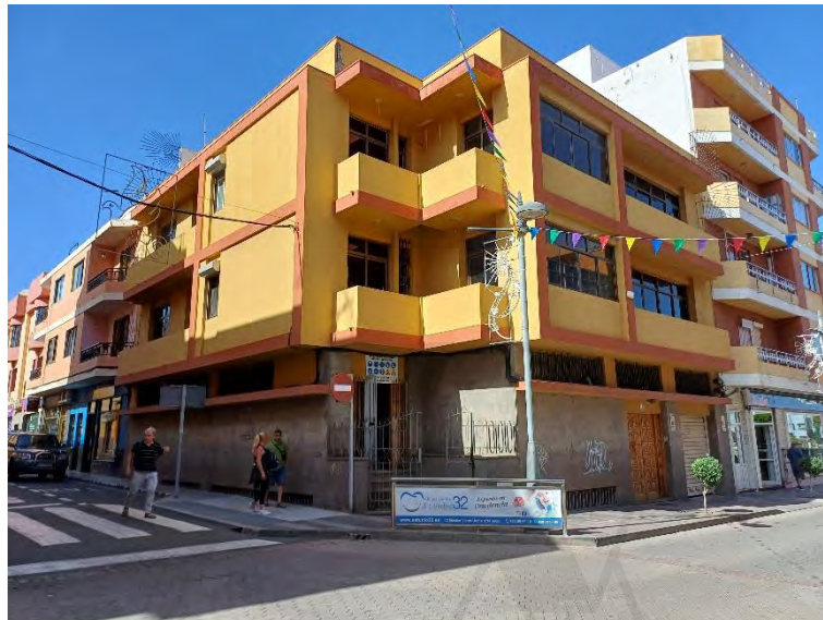
Fachada de edificio. Entrada principal
