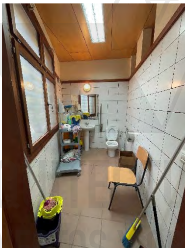
Aseo PMR existente.
