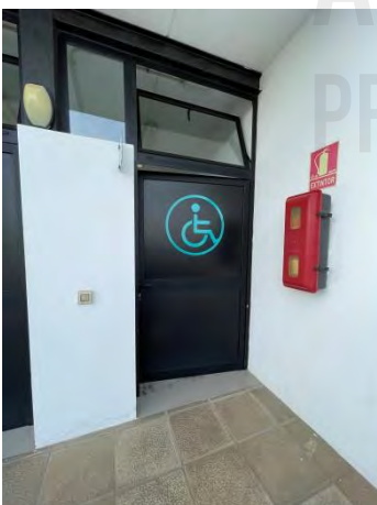
Aseo PMR existente
