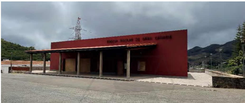
Fachada de edificio. Entrada principal.
