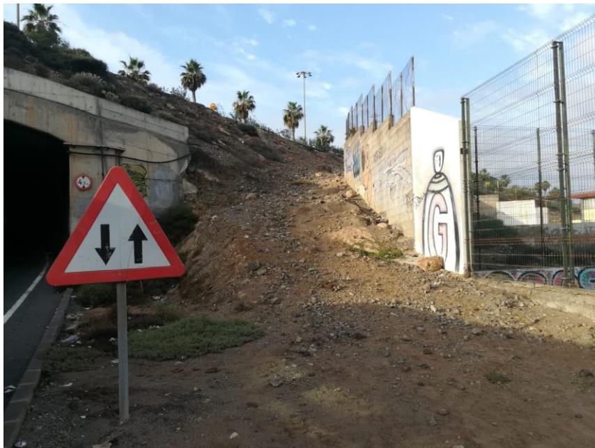
Figura 8. Tramo colindante al túnel que enlaza la GC-2 con la Avenida José Sánchez Peñate
