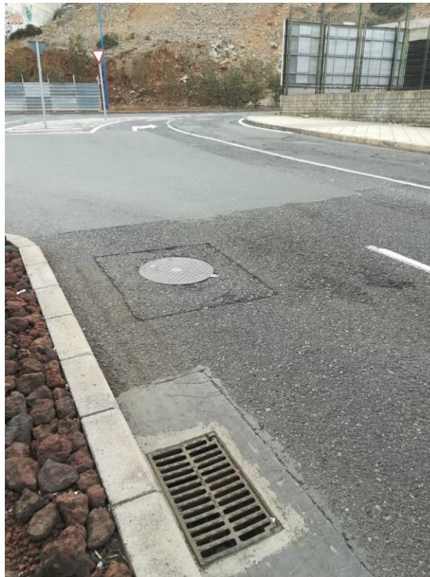
Figura 10. Detalle del imbornal y arqueta de pluviales de la Avenida José Sánchez Peñate
