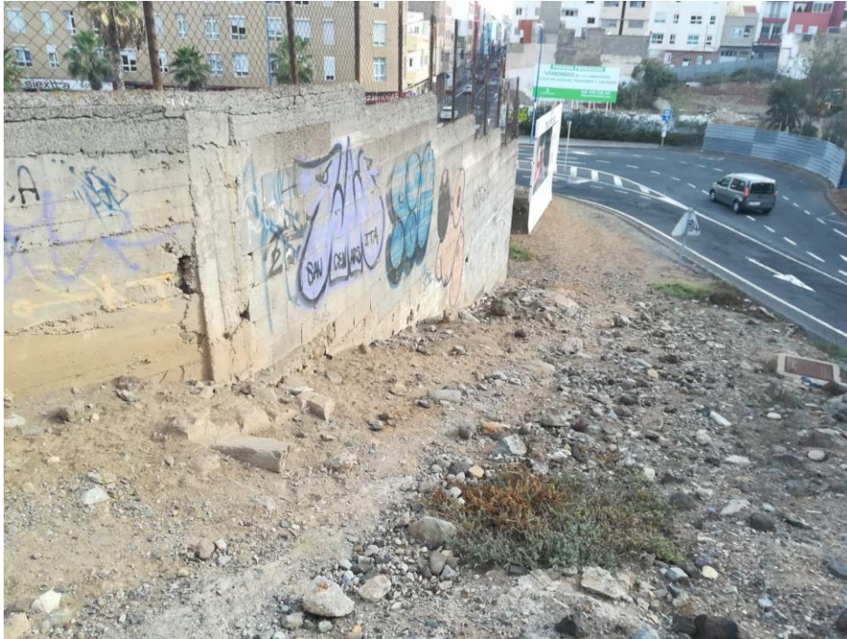
Figura 9. Vista desde el tramo descendente hacia la Avenida José Sánchez Peñate
