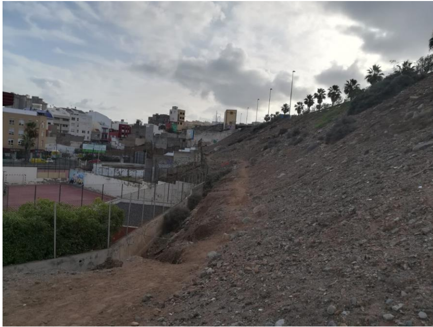
Figura 3. Camino de tierra localizado en la berma intermedia entre taludes
