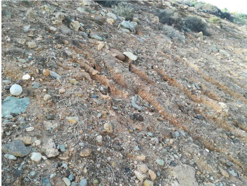
Figura 7. Detalle del talud de carretera GC-2.
