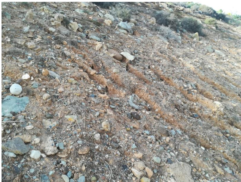
Figura 2. Talud de la carretera GC-2
