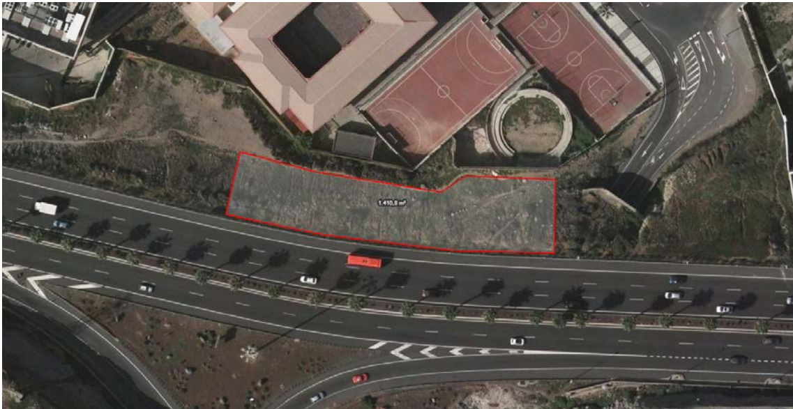
Figura 1. Zona de actuación e instalación de geomanta reforzada con malla metálica
