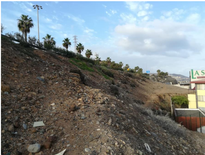
Figura 6. Detalle del talud de la carretera GC-2
