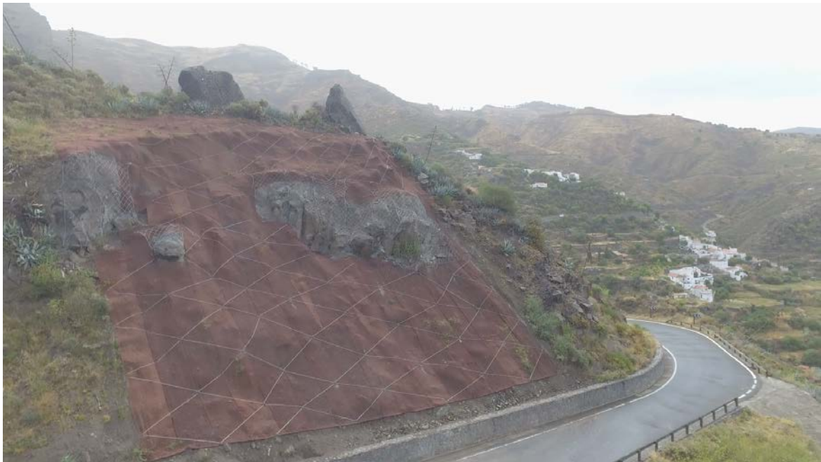
Figura 2. Aspecto final de un talud con geomanta instalada.
