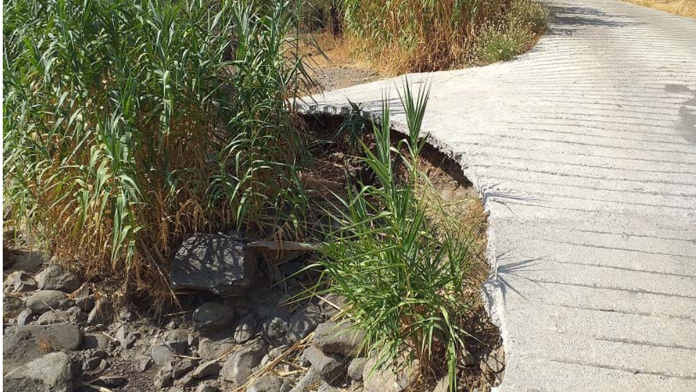
Foto 4: Losa descalzada.
