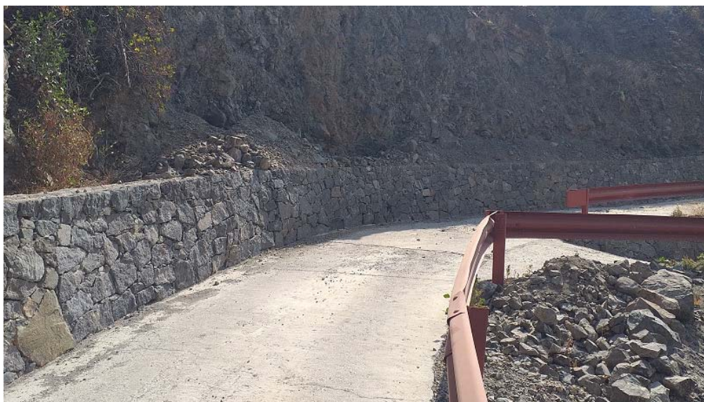
Foto 6: Aterramientos sobre la coronación del muro..
