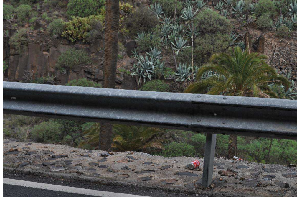
Ilustración 5. Barrera bionda existente en borde de calzada
