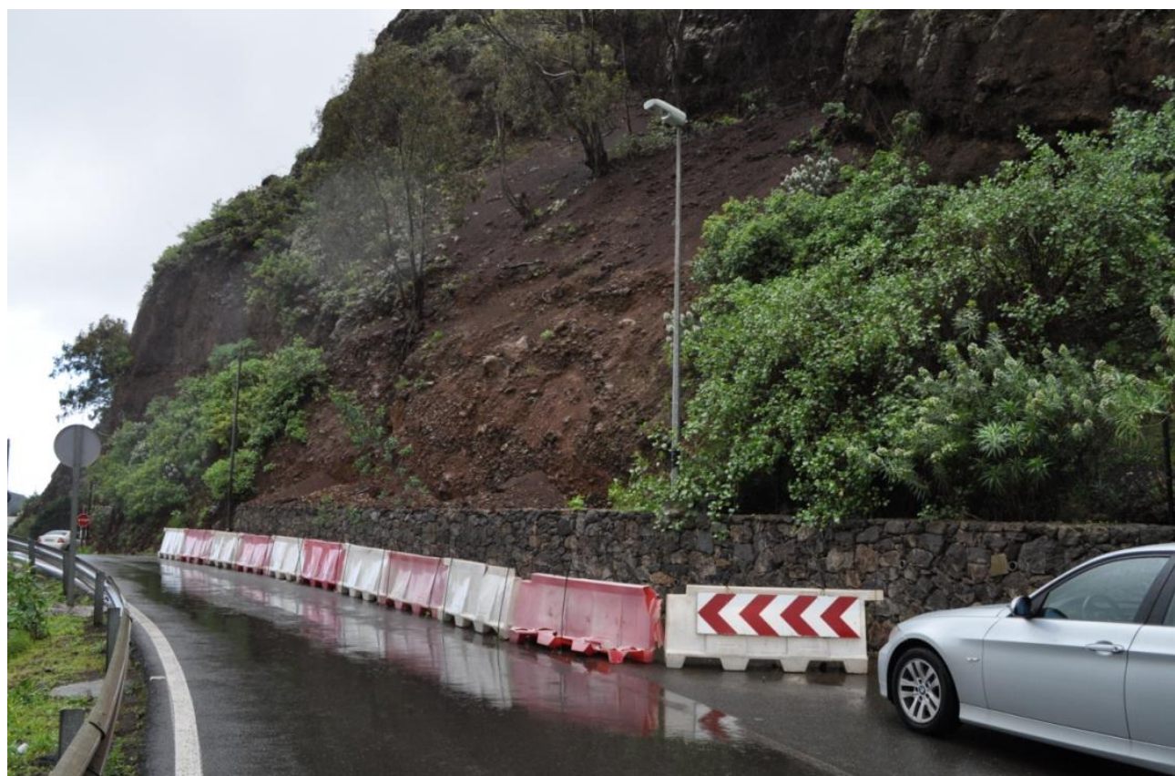
Ilustración 1: Vista general del talud en el margen derecho GC-321.
