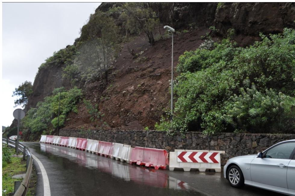
Ilustración 2. Fotografía vista general del talud en la GC-321. Fuente: Elaboración propia.
