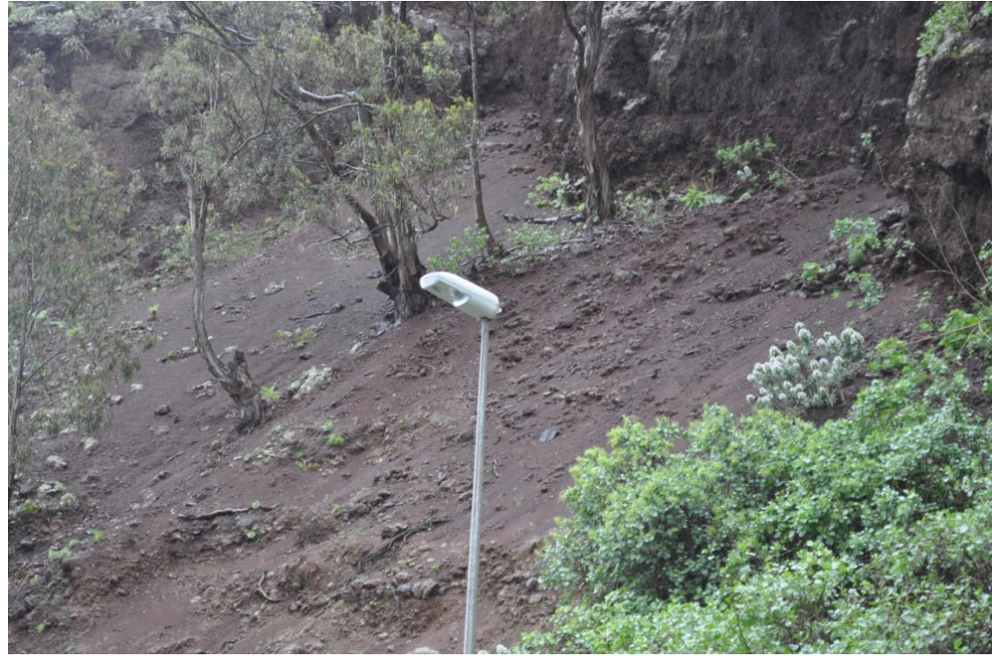
Ilustración 4: Ladera en la parte baja del terreno ubicado sobre el talud en la GC-321.
