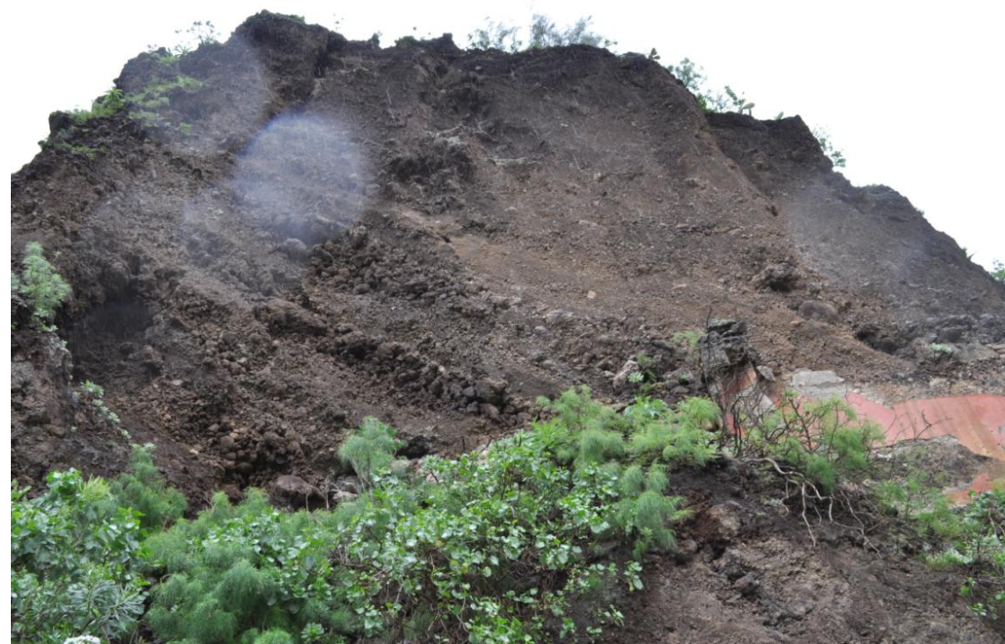
Ilustración 5: Vista central parte alta de los terrenos sobre el talud en la GC-321.
