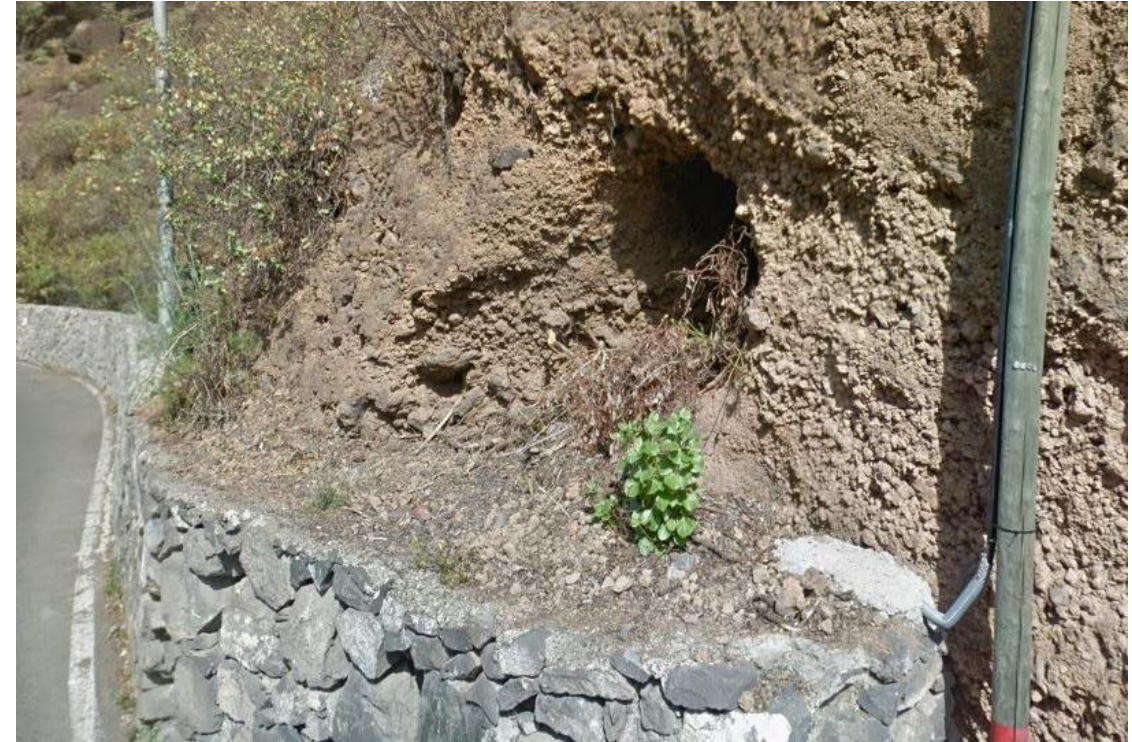
Ilustración 6: Oquedad donde se encuentra una tubería de hormigón que cruza la calzada (final del tramo).
