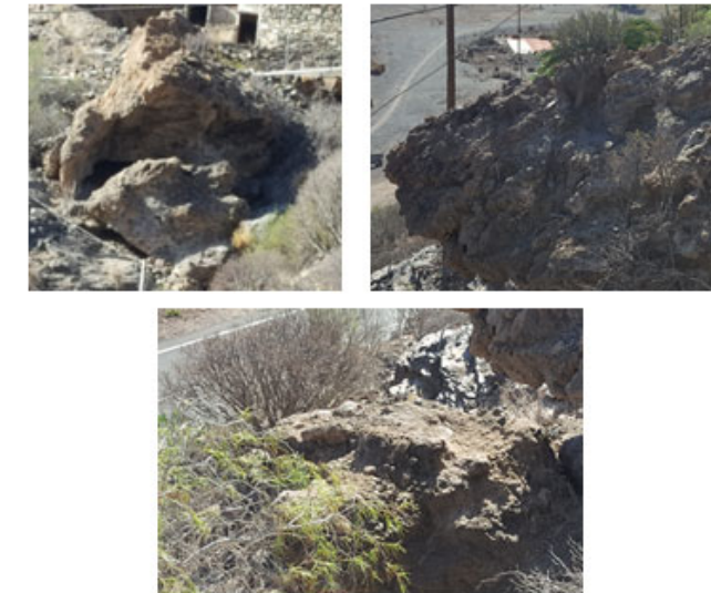
Imagen 3-1.-Estado del macizo presente en el talud
