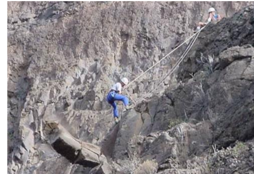
Ilustración 3-1.-Desbroce con medios manuales de un talud
