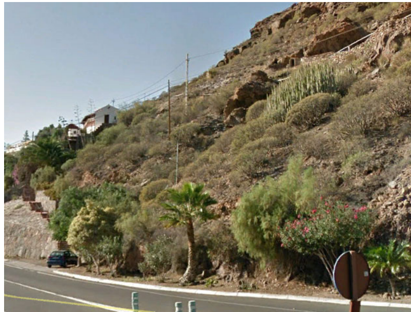
Ilustración 3-3.-Imagen del talud.
