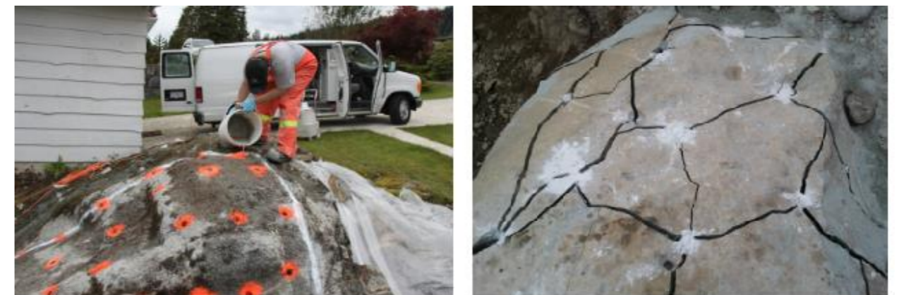
Imagen 3-3.-Uso del Mortero expansivo
