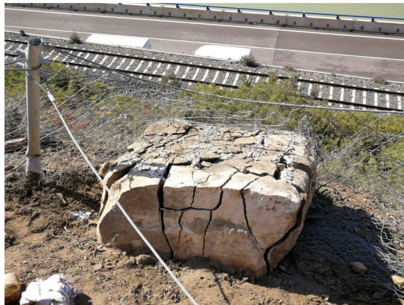
Imagen 3-4.-Uso de cemento expansivo sobre roca
