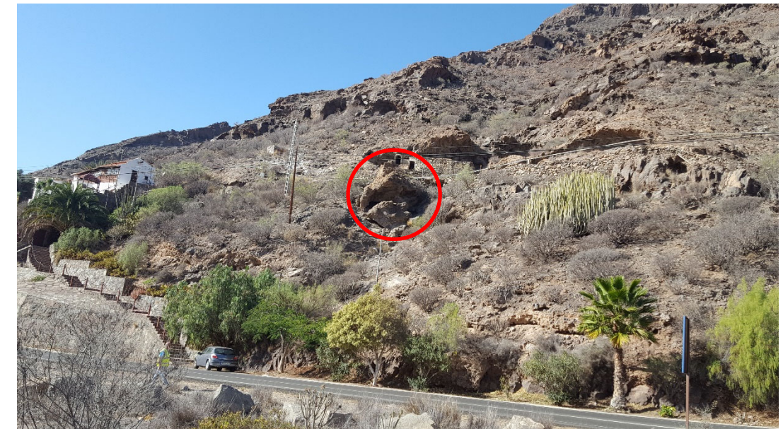
Imagen 2-1.-Vista del talud
