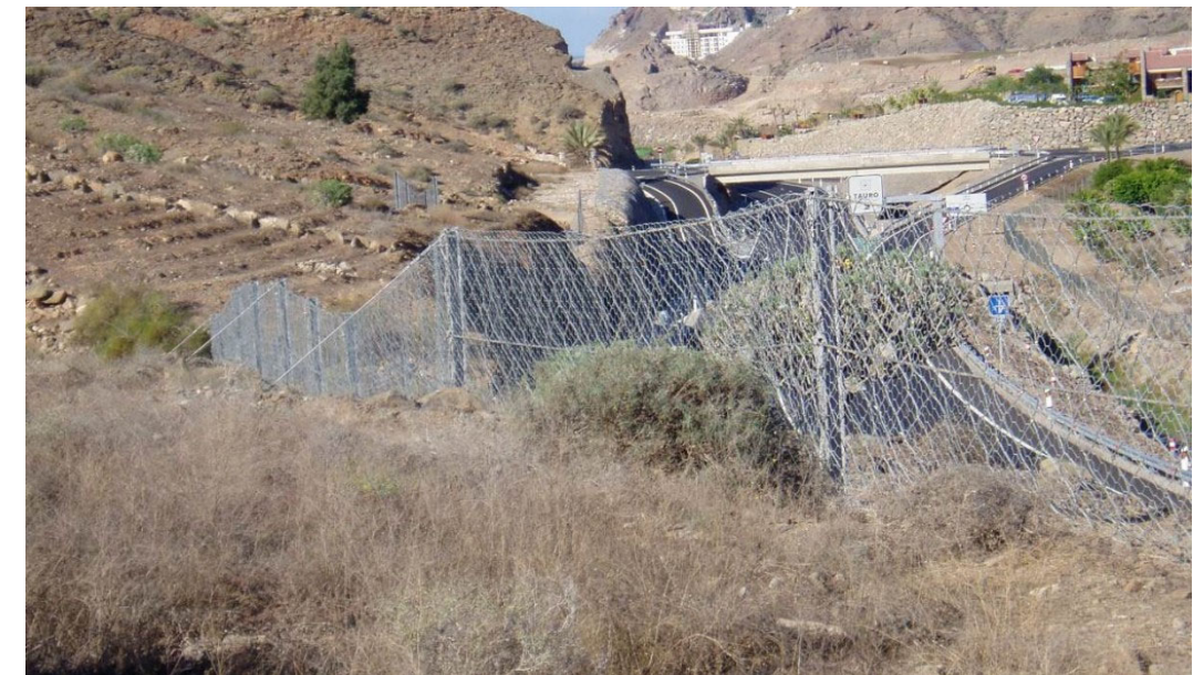
Imagen 4-1.-Instalación barrera estática
