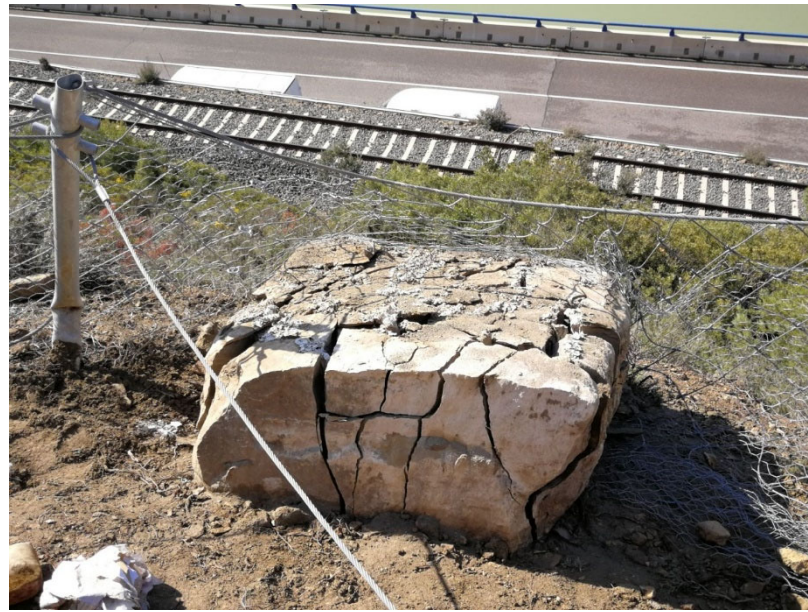
Imagen 4-3.-Uso de cemento expansivo sobre roca
