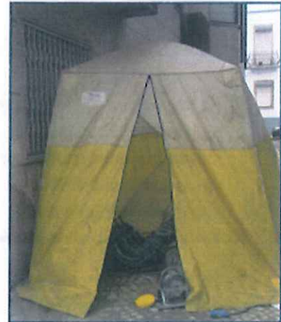
Caseta para proteger la soldadura de lluvia o viento.
