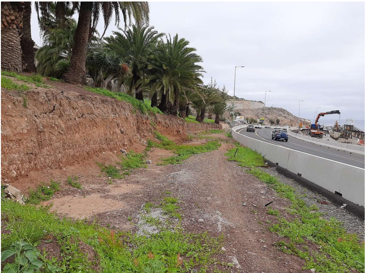
Desmonte en zona de estudio. Fuente: Rabadán 17
