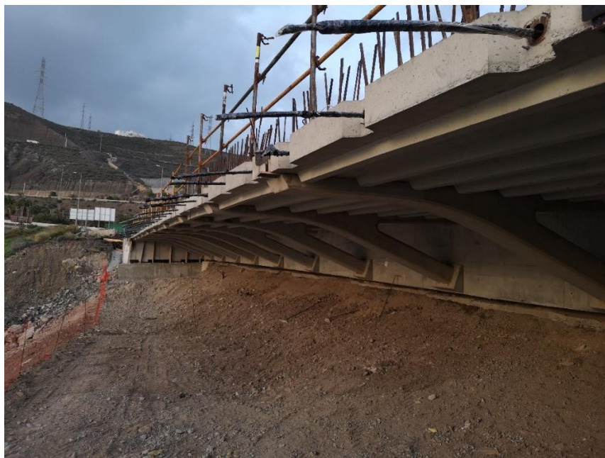
Viaducto GC-1. Fuente: Rabadán 17.
