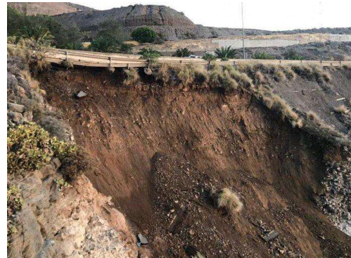
Colapso muro GC-1. Fuente: Desconocido
