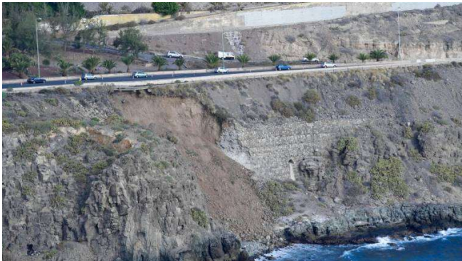
Colapso muro GC-1. Fuente: Desconocido
