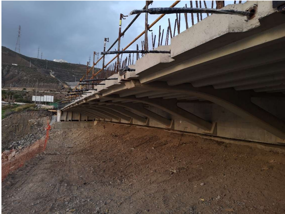
Viaducto GC-1. Fuente: Rabadán 17.
