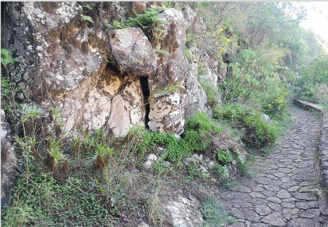
Foto: Zona estrecha donde se prevé la instalación de microdifusores.
