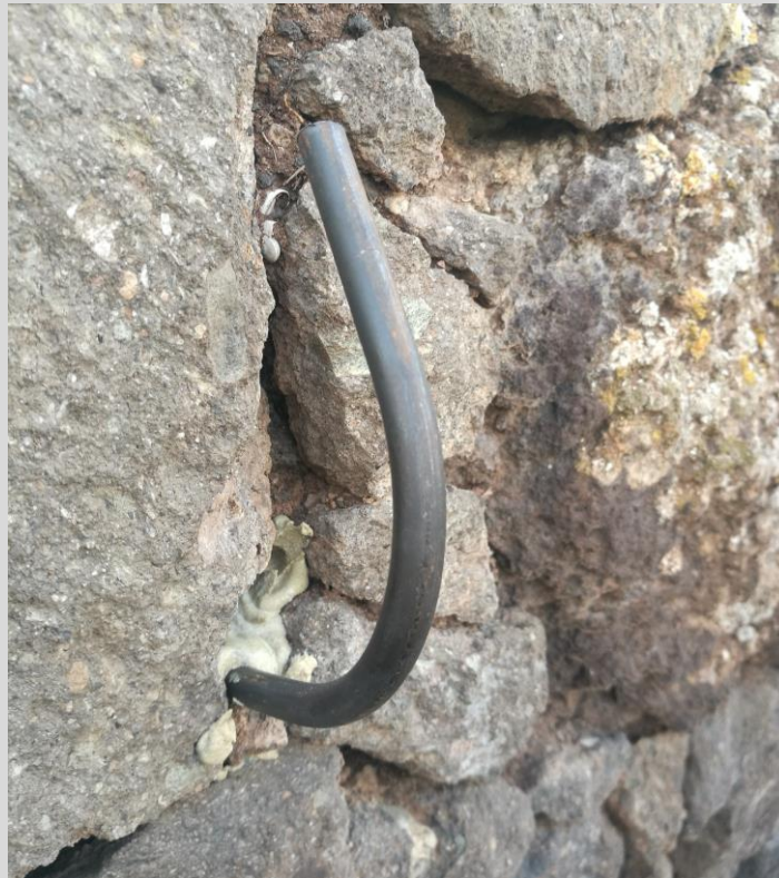
Método utilizado para el anclaje de tuberías a paredes y muros.
