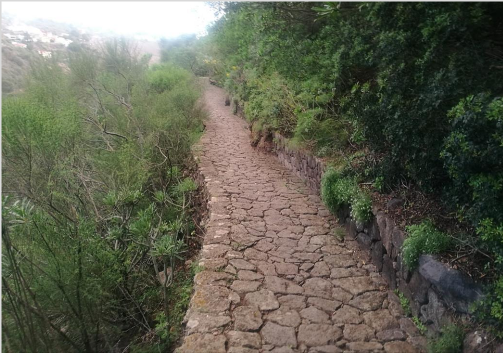
Camino de mampostería donde se prevé la construcción de un pase de caminos
