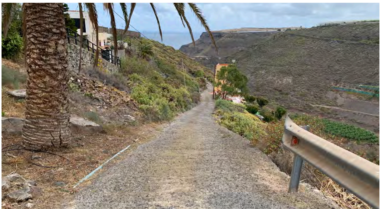
Imagen de ramal en hormigón.
