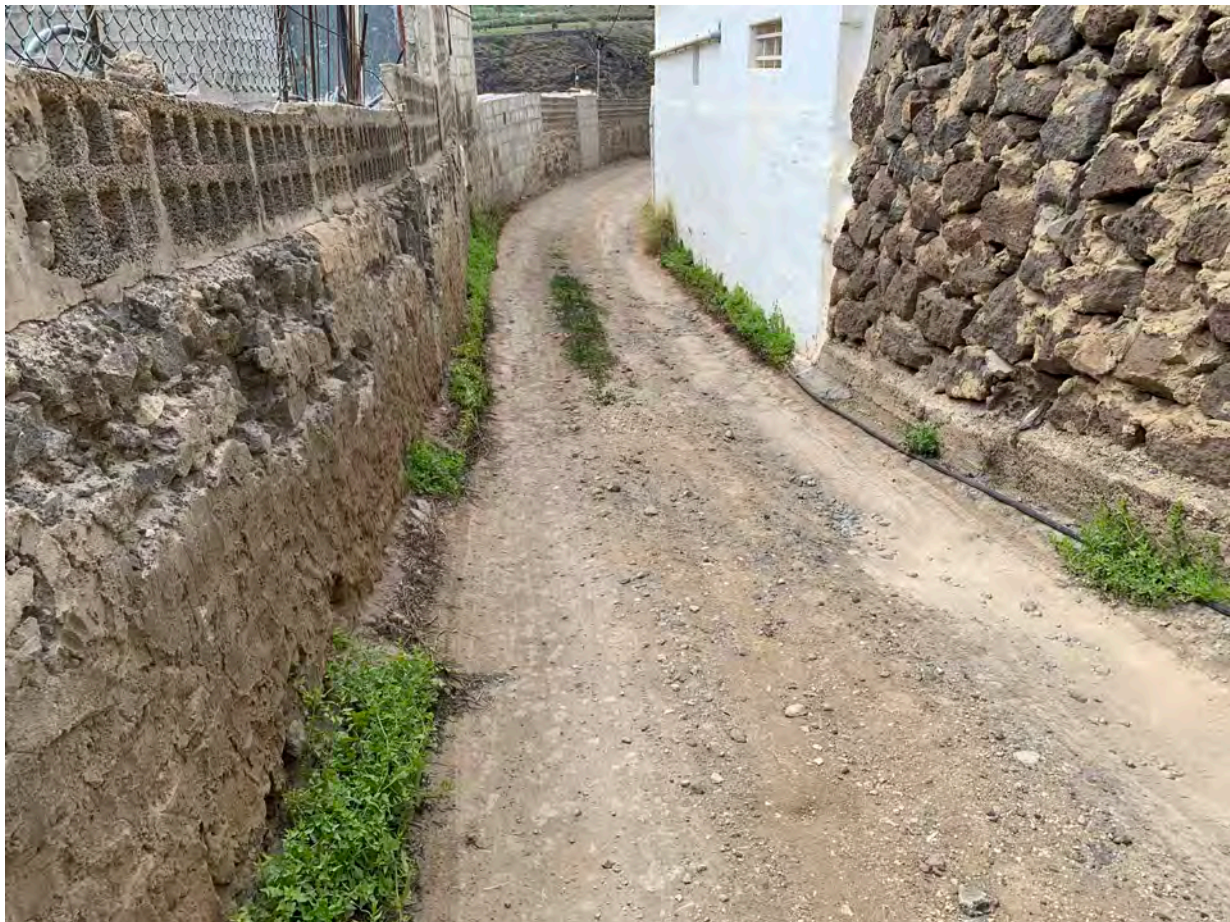
Imagen de ramal en material granular.
