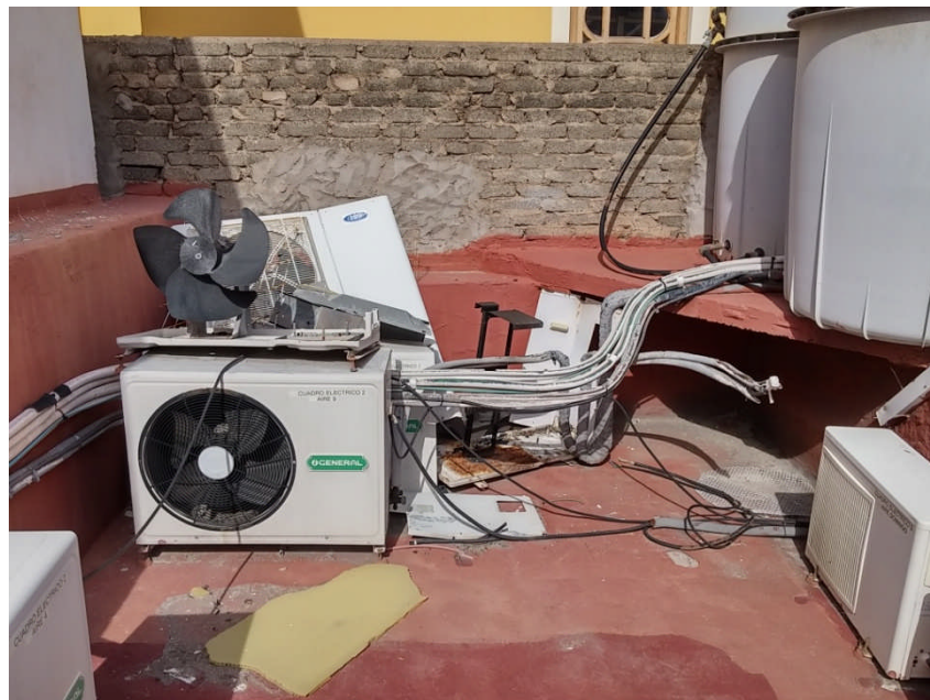
Imagen 6.- Vista instalaciones actuales en cubierta
