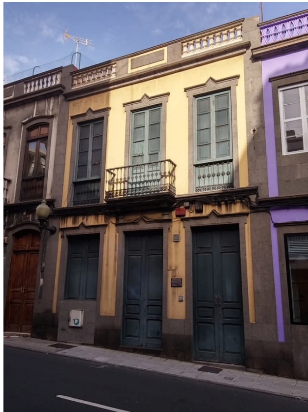
Imagen 2.- Vista exterior fachada principal
