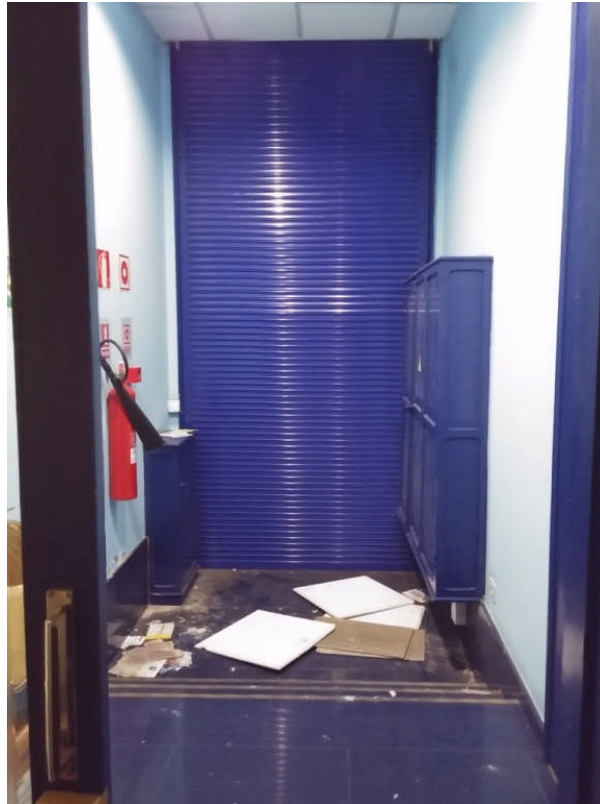
Imagen 3.- Vista interior entrada principal
