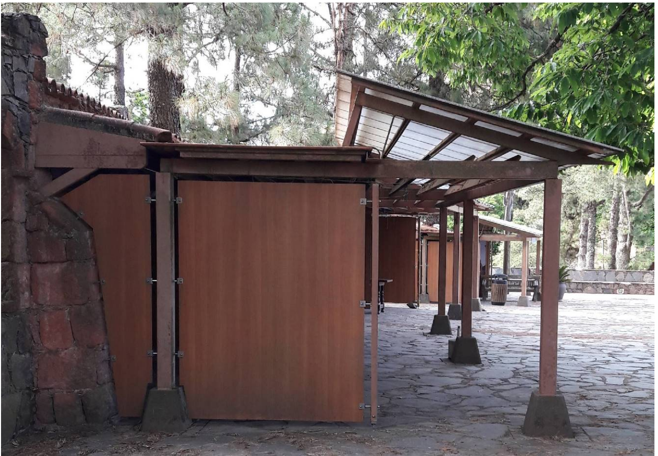
Imagen 7. Vista general exterior de los puestos. Sección de marquesina. Puesto 6
