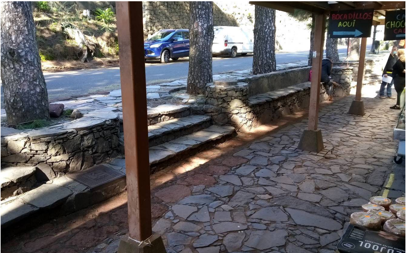
Imagen 9. Vista general exterior de los puestos. Encuentro con Calle
