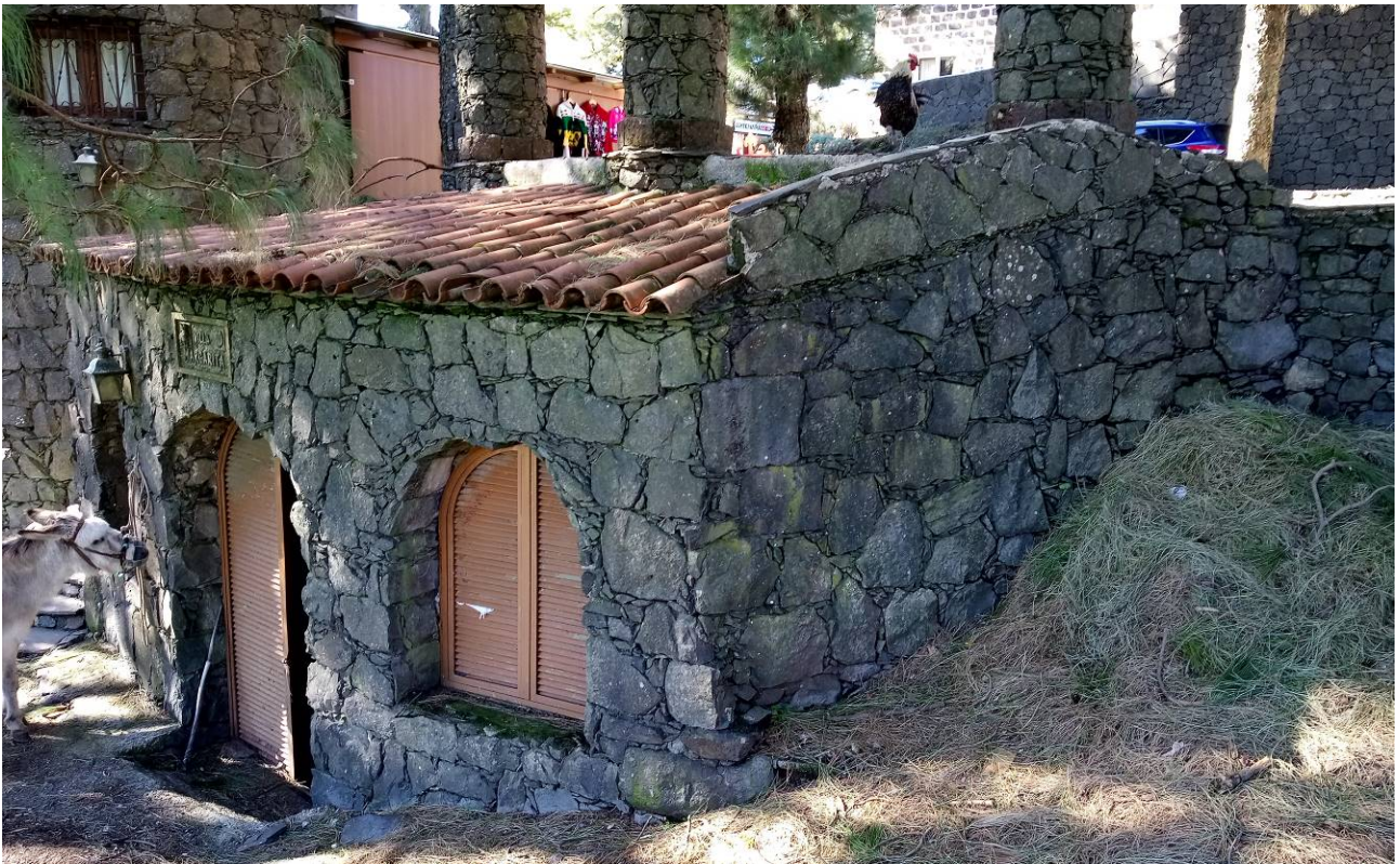
Imagen 13. Vista general exterior de los puestos. Cuartillo para el Asno
