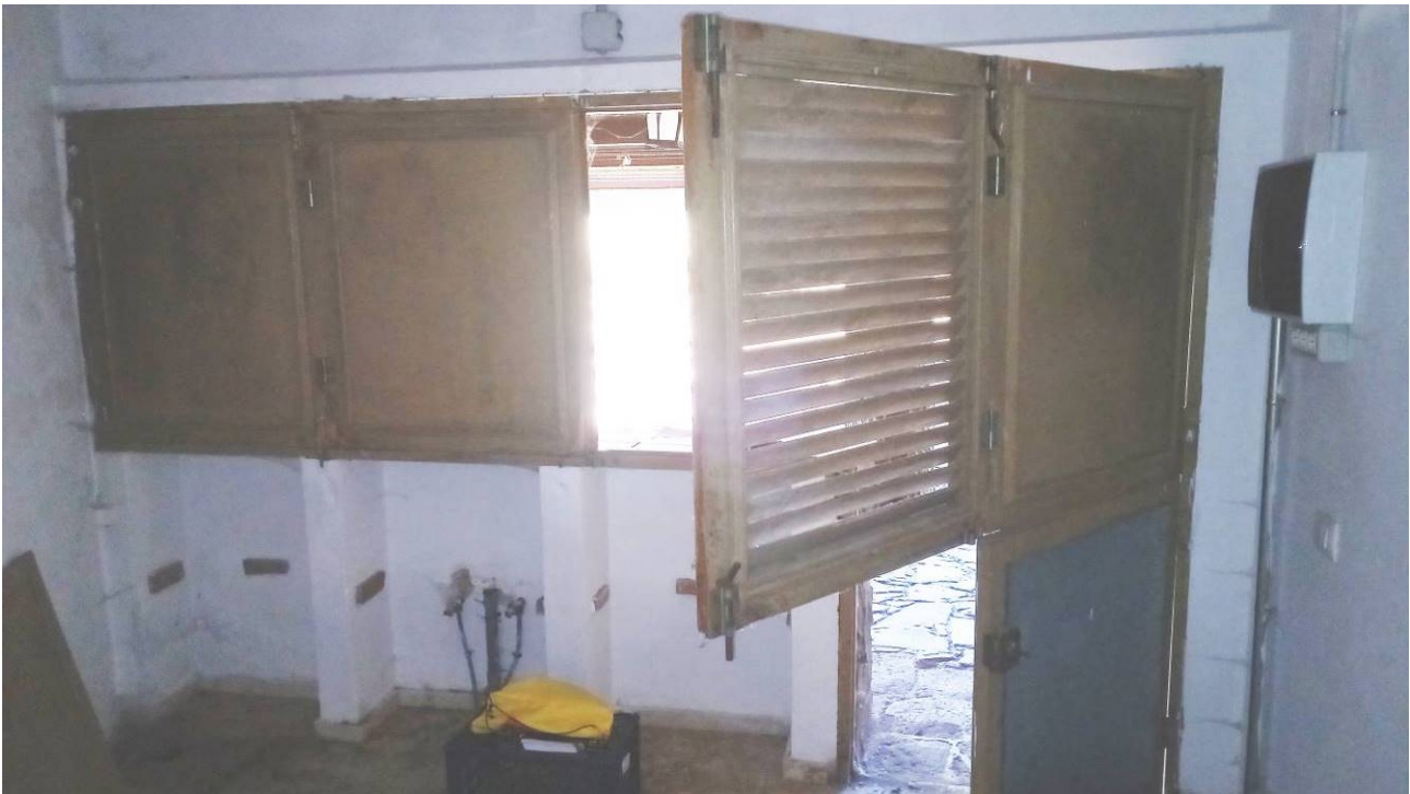
Vista general interior de los puestos. Instalaciones mínimas
