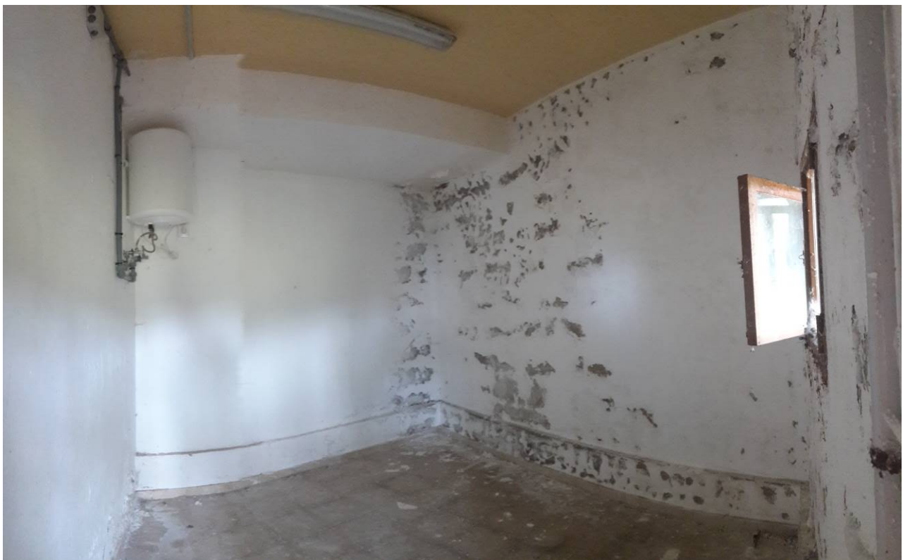
Vista general interior de cuarto inferior
