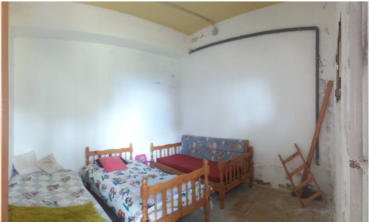
Vista general interior de cuarto inferior
