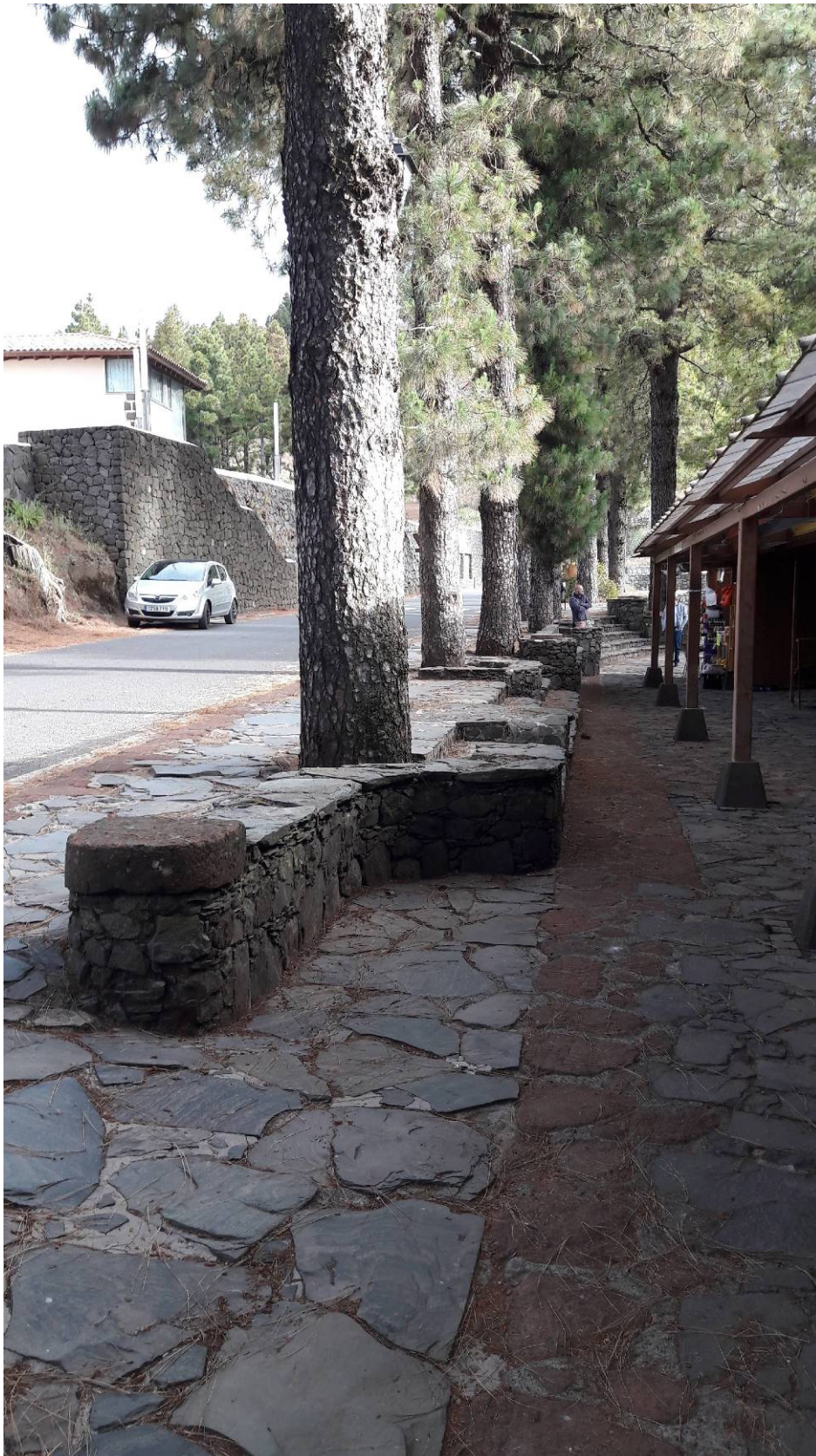
Imagen 8. Vista general exterior de los puestos. Encuentro con Calle
