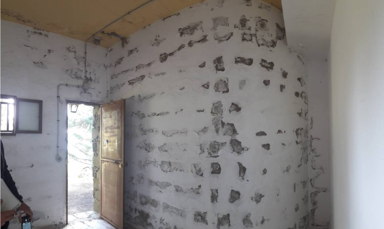
Vista general interior de cuarto inferior
