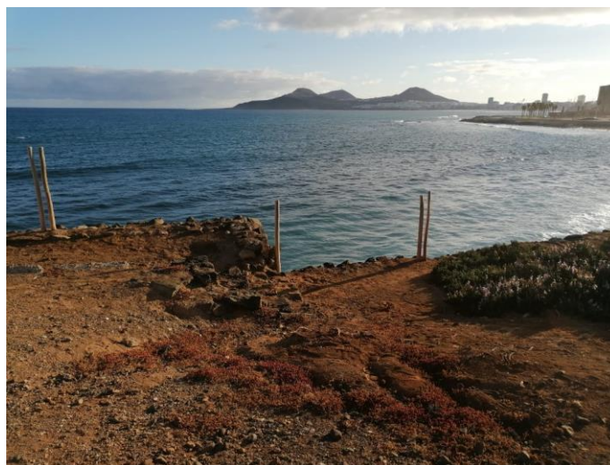
Ilustración 7 vista de la zona sin protección de caída
