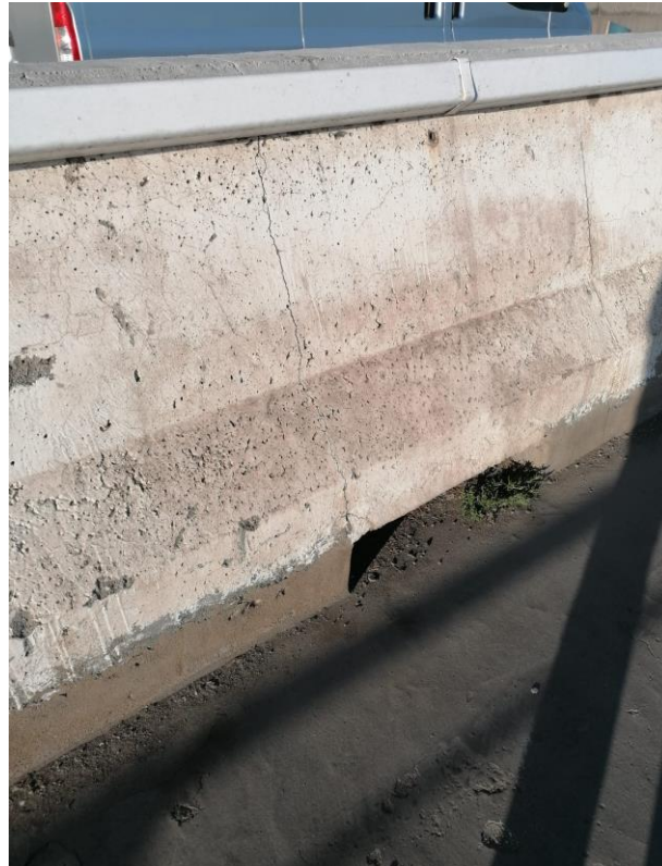
Ilustración 16 Imagen del camino entre el PK 2+500 y el 2+800. Instalaciones eléctricas de señalización de la vía sobre la barrera New Jersey
